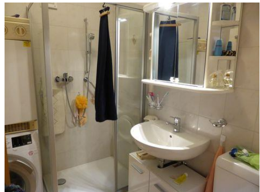
Salle de douches | Colonne de lavage
