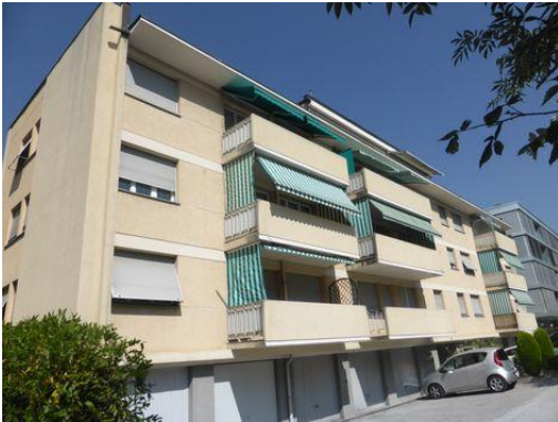
Vue angle Sud-Ouest
