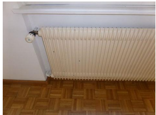
Radiateur avec vanne thermostatique
