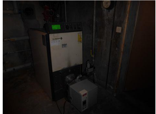
Chaudière à gaz (1987)
