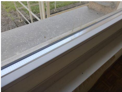
Fenêtre en PVC | Double vitrage (1998)
