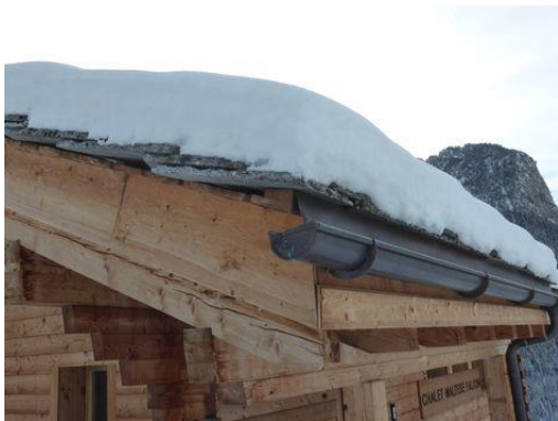
Ferblanterie en cuivre | Couverture en ardoises naturelles
