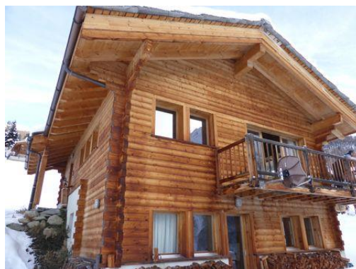
Vue angle Sud-Est
