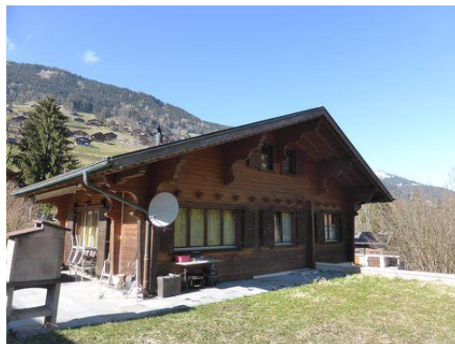
Vue angle Sud-Est
