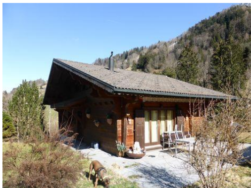
Vue angle Sud-Ouest
