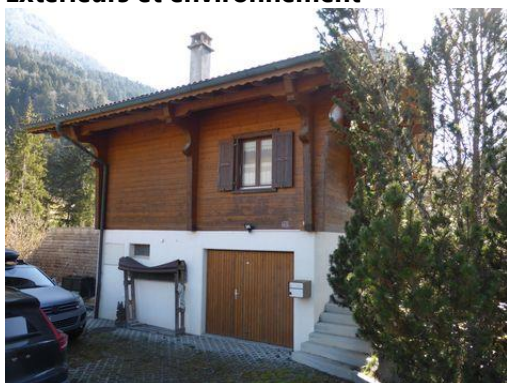
Vue angle Nord-Ouest
