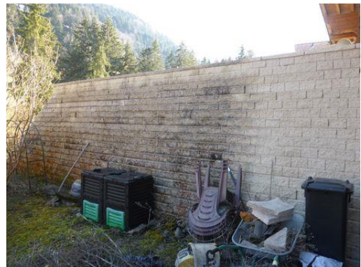
Mur de soutènement jardin orienté Est
