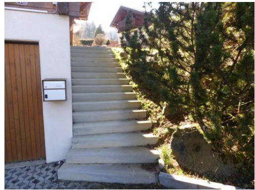
Accès entrée principale
