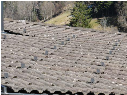
Couverture en tuiles fibrociment
