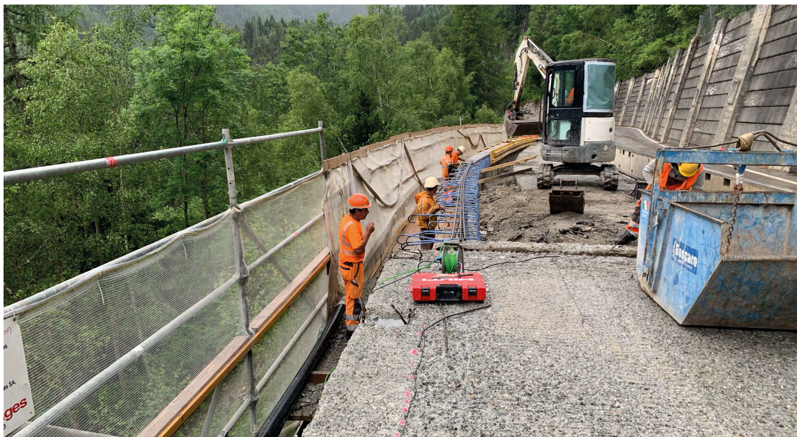
Rénovation du Pont des Aavilles | Sanierung der Pont des Aavilles
