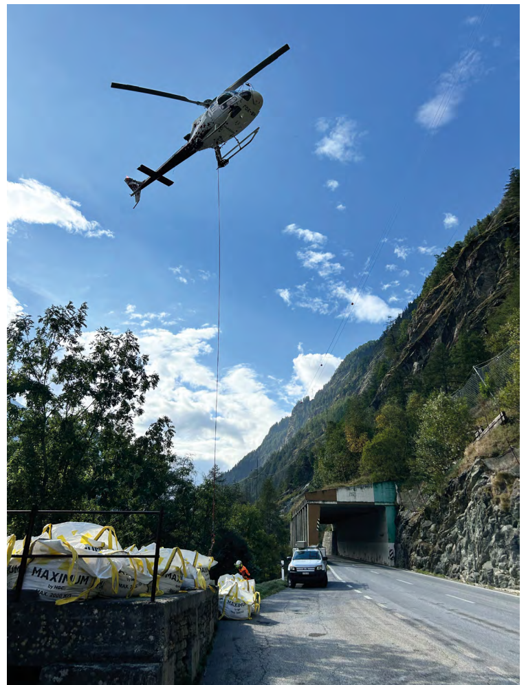
Für bestimmte Arbeiten ist der Helikopter notwendig | L'hélicoptère est nécessaire pour la réalisation de certains travaux
