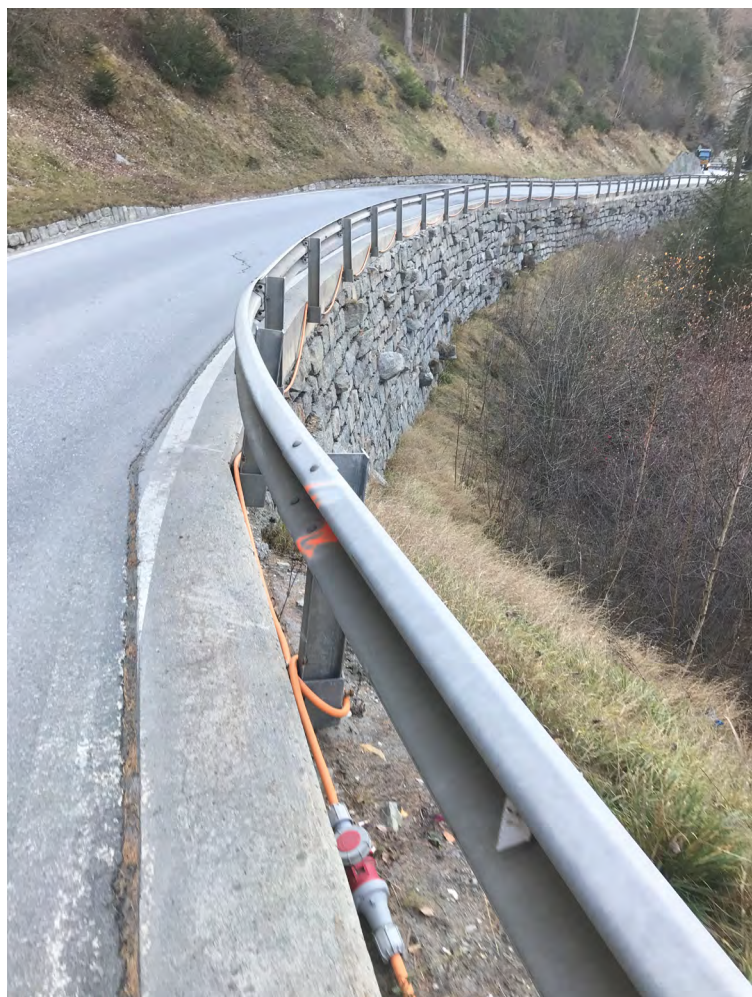
Strasse vor dem Ausbau | La route avant l'élargissement
