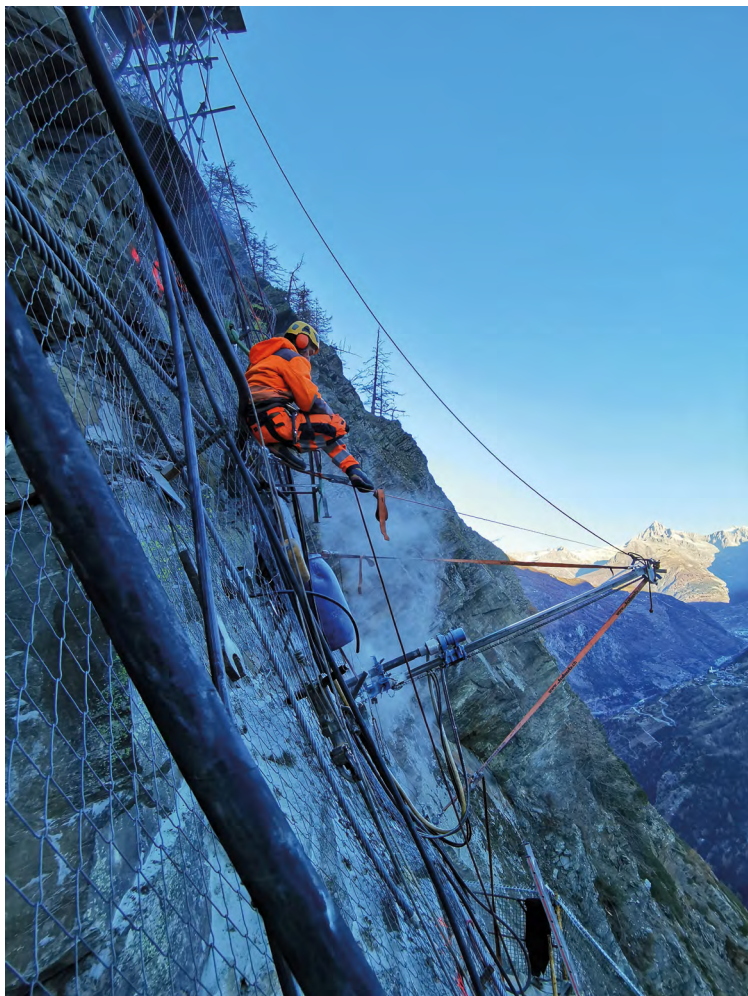
Installation von Sicherheitsnetzen | Pose des filets de protection
