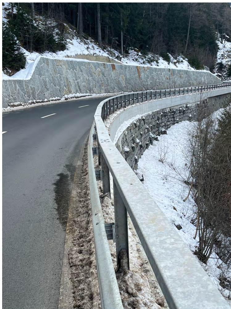
Strasse nach dem Ausbau | La route après l'élargissement
