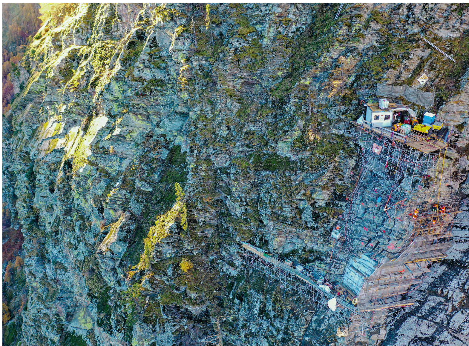
Sicherungsarbeiten im Bereich « Turm » | Travaux de sécurisation secteur « Turm »
