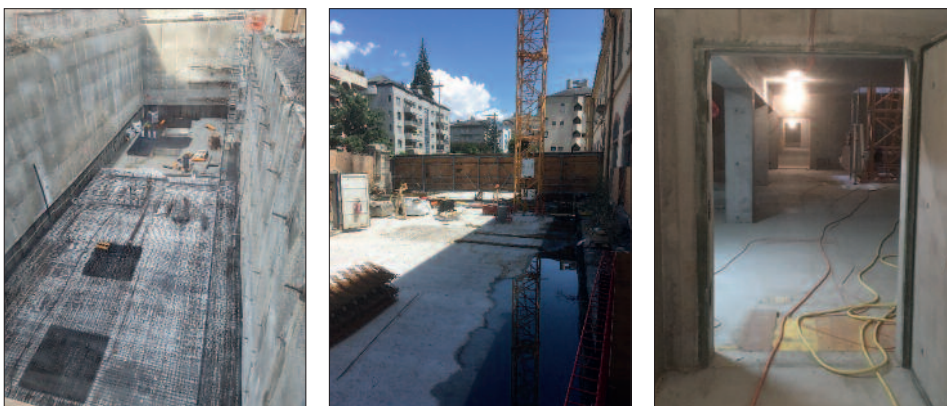
Fig. 1-3. A la mi-mars 2018 (à gauche), la fouille qui doit accueillir les nouveaux dépôts des Archives de l'Etat du Valais est terminée, les parois berlinoises sont posées tandis que les fondations sont en cours de réalisation. A la mi-juillet 2018 (au milieu), la construction des trois étages est presque terminée. Vue en profondeur de l'intérieur des dépôts (à droite).
