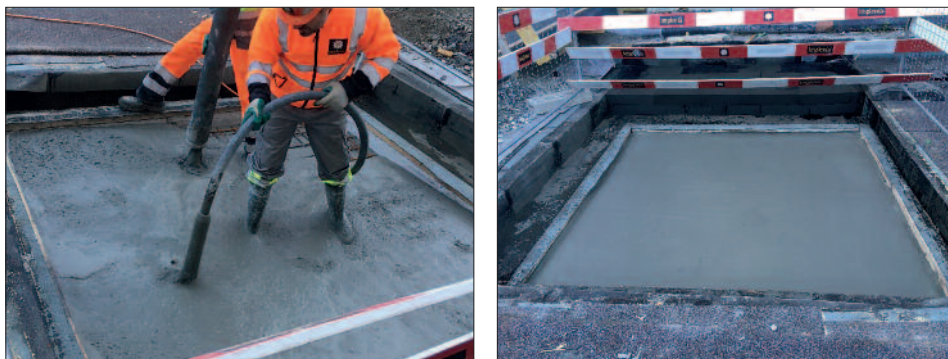
Fig. 6-7. Le 10 octobre 2018 est coulée la dernière partie de la dalle supérieure des nouveaux dépôts des Archives de l'Etat du Valais. Seront ensuite posées sur cette dernière une couche d'étanchéité, puis une couche d'isolation et enfin une double couche d'étanchéité, de manière à pouvoir créer une barrière imperméable entre le bâtiment et l'environnement extérieur.
