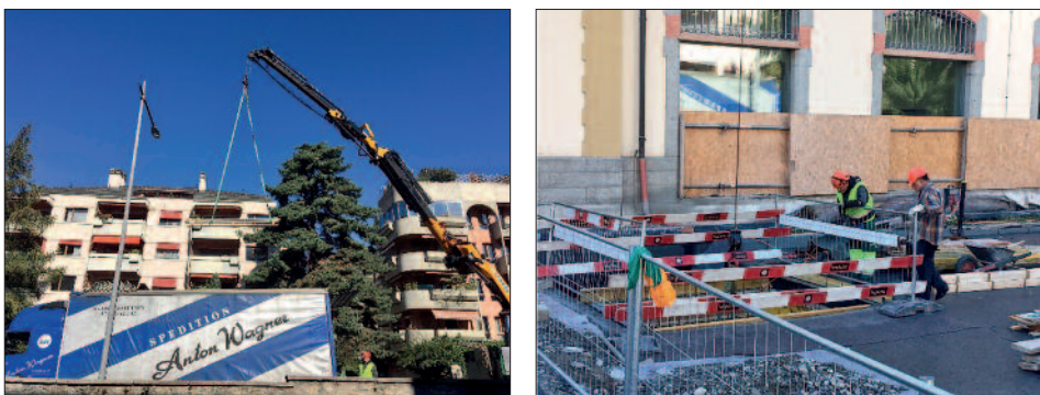
Fig. 4-5. Passage des rails des rayonnages mobiles par la trémie le 4 octobre 2018 en vue de leur pose et de leur intégration à la chape.
