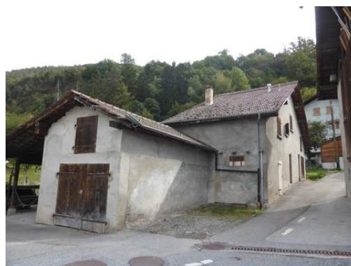
Vue angle Nord-Ouest
