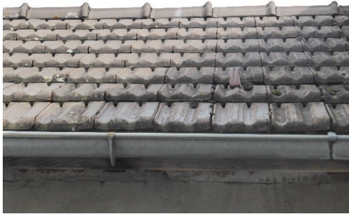
Couverture en tuiles terre cuite | Gouttière en acier
