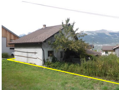
Vue angle Sud-Ouest
