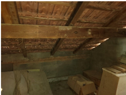
Remise sous combles
