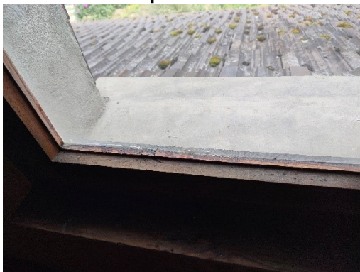
Fenêtre bois | Vitrage simple
