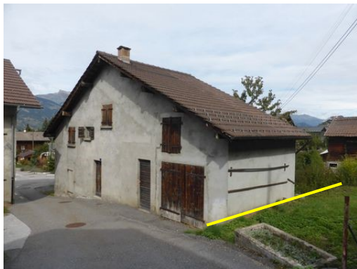
Vue angle Sud-Ouest
