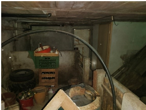
Cave/stockage (local non accessible/photo par fenêtre)
