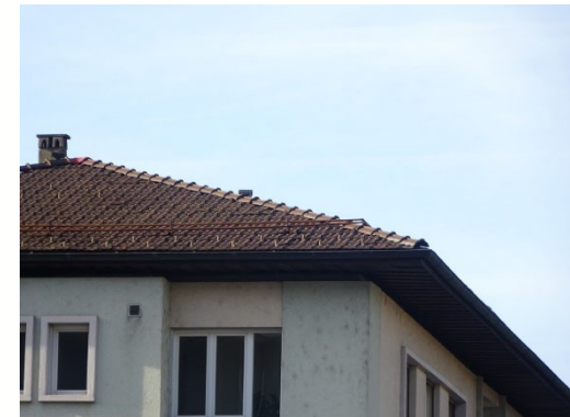
Couverture tuiles / ferblanterie cuivre
