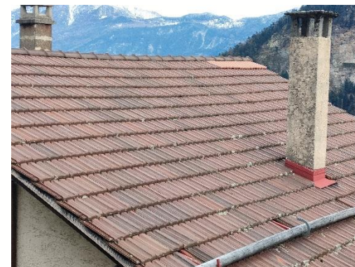
Couverture en tuiles terre cuite
