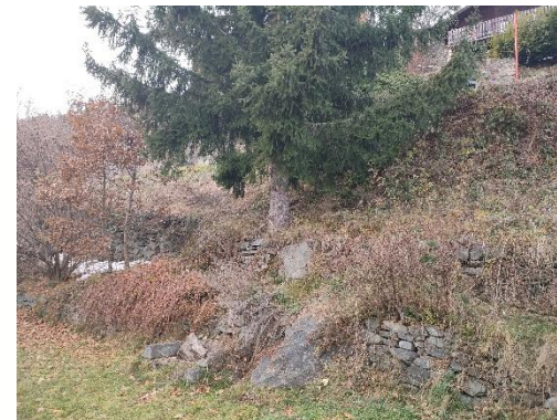
Talus extrémité Est
