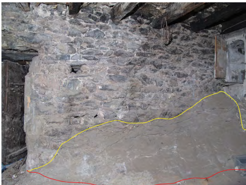
Fig. 2 Grimisuat, Château. Local 01, paroi nord de la cave. Le mur est construit sur la surface du rocher (jaune). Au pied du mur, le rocher est excavé sur plus de 1 m de hauteur. La ligne rouge indique la limite nord de la plate-forme taillée à l'horizontale.
