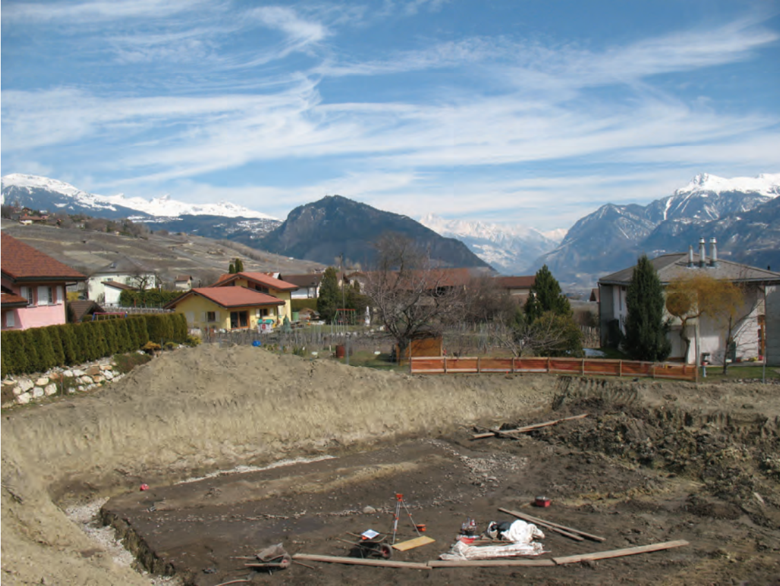
Vue générale du chantier en direction de l'Est
