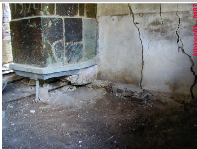
17. Détail de la pose du fourneau
