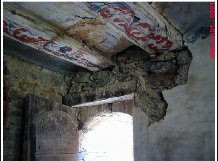
20. Détail encastrement des solives
