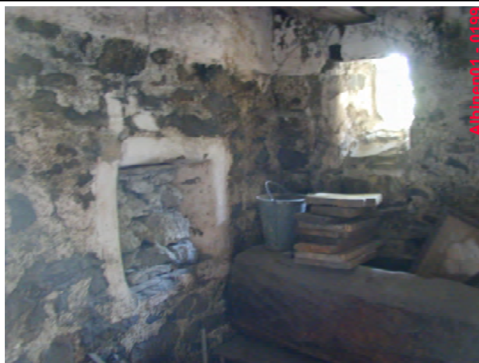
13. Fenêtres du rez-de-chaussée
