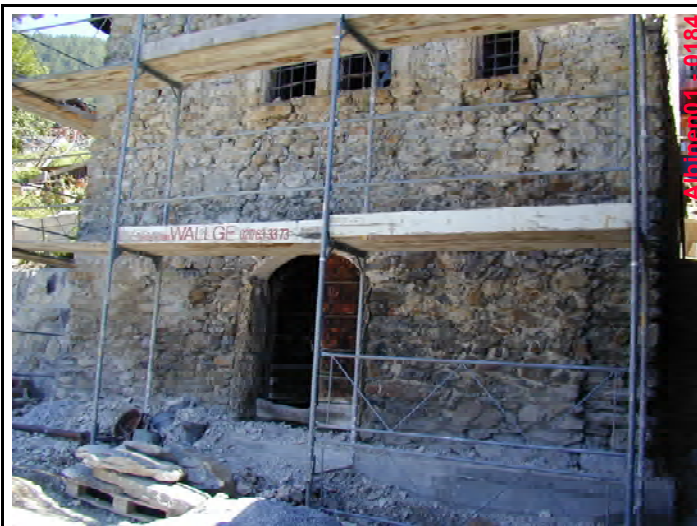
07. Façade ouest, partie basse
