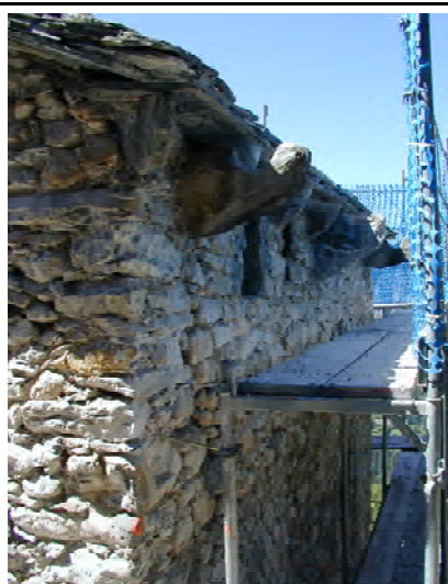
05. Façade nord, partie haute
