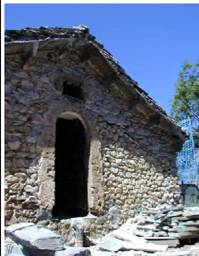
04. Façade est, partie nord
