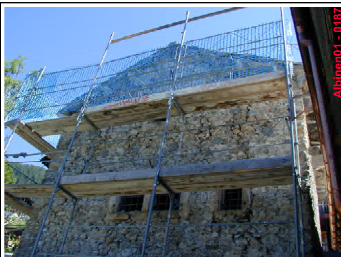
08. Façade ouest, partie haute
