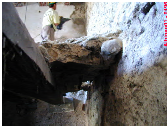
15. Détail de la dalle de mortier
