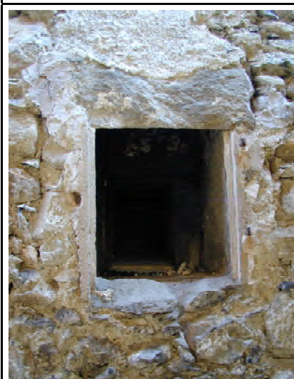
11. Façade sud, ouverture à l'arrière du fourneau
