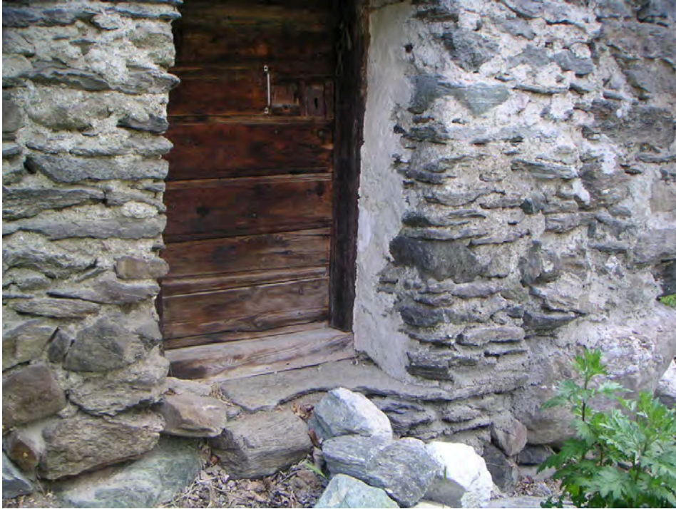
Fig. 3 Façade occidentale ; seuil de l'ancien passage pris sous la maçonnerie qui bouche la grande ouverture arquée et crée le piédroit de la nouvelle porte.
