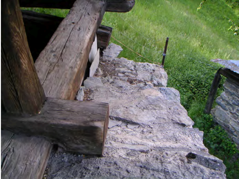
Fig. 5 Façade occidentale ; pan sud du pignon recouvert d'une assise de pierres plates.
