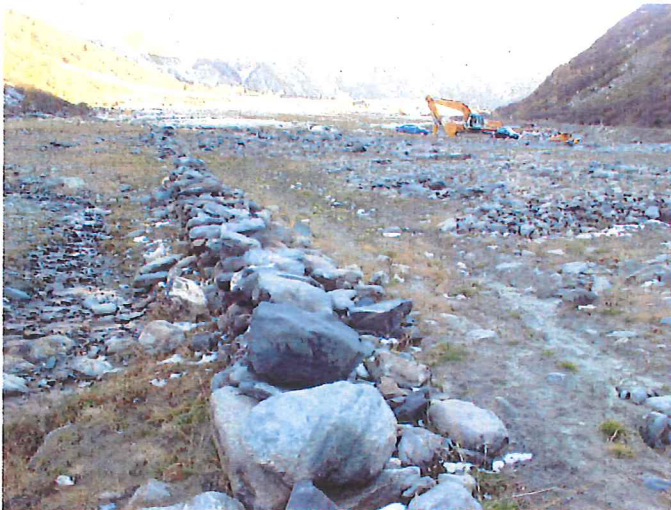
Fig. 7. Le tracé rectiligne d'un second mur en pierres sèches est visible en limite de la côte supérieure du lac. A droite, les travaux de sondage.
