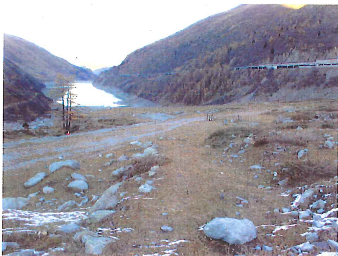
Fig. 13. Ancien tracé (premier plan), recoupé par la route Napoléon. Au troisième plan, la piste pour camion du chantier.
