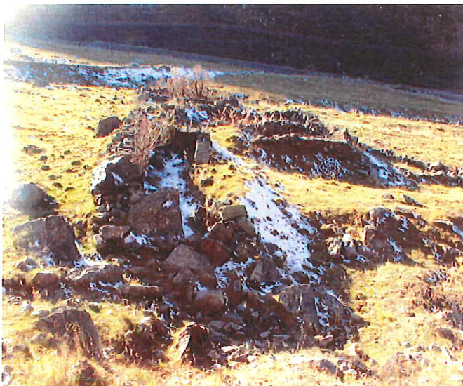
Fig. 9. La ruine des corps de bâtiment de l'alpage de Proz.
