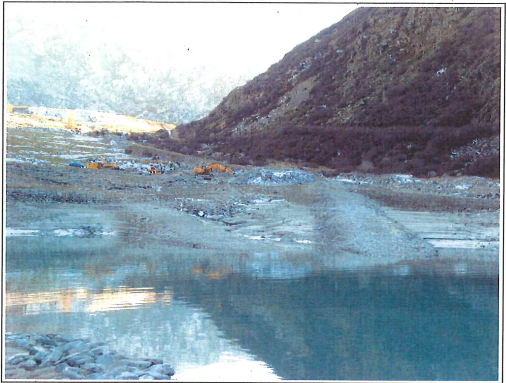
Travaux de sondage effectués en amont du lac
