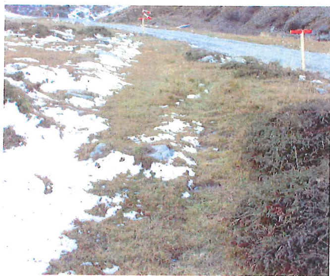
Fig. 17. La suite de l'ancien tracé, coupé par la piste du chantier. Le cliché est pris depuis le même endroit que la photo précédente, mais dans la direction opposée.
