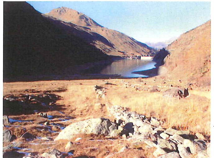
Fig. 8. Prolongement amont du mur visible sur le cliché de la Fig. 7
