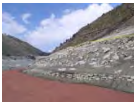
Fig.31. Détail de l'image précédente. En rouge, la route du XIX e siècle bordée du côté amont par un mur ; en jaune, le muret en pierres sèches qui soutient le tracé plus ancien situé en amont.
