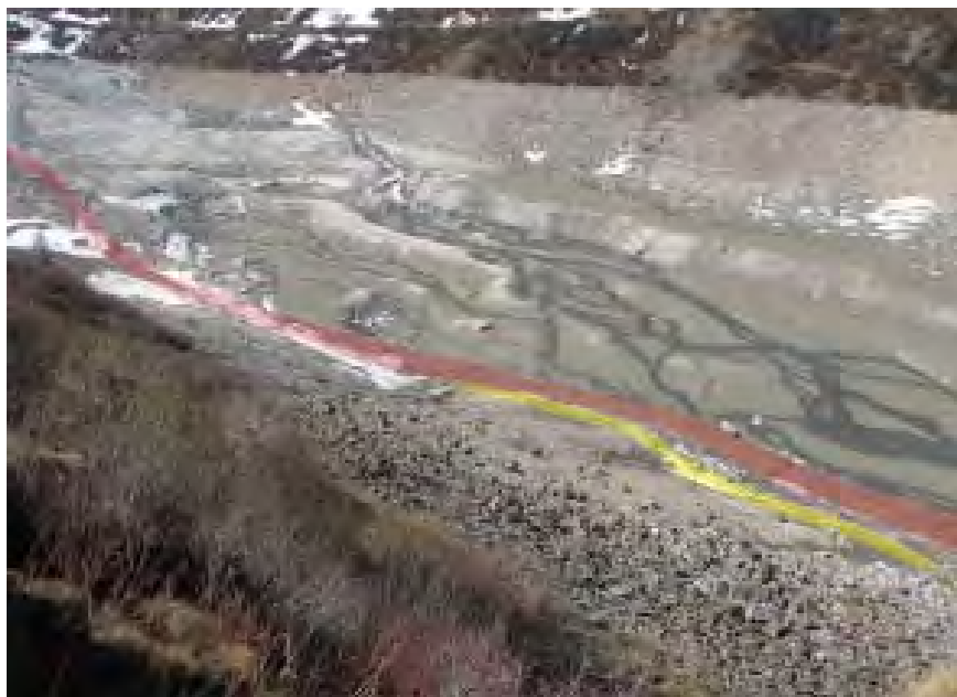
Fig.29. Secteur en aval de la Cantine, dans la partie inondée du barrage, vu vers l'ouest. La route du XIX e siècle (en rouge) est dominée à cet endroit par un tracé parallèle, plus ancien (en jaune).
