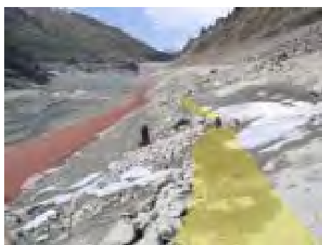
Fig.37. Partie inondée du barrage, vue vers le nord. A gauche, partiellement noyé sous les eaux, le replat de la route du XIXe siècle (en rouge). A droite, recouvert par les dépôts de vase, le tracé plus ancien bordé par un petit muret de soutènement (en jaune).
