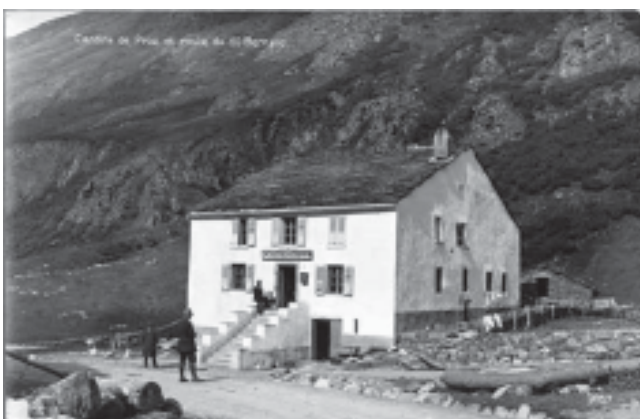
Fig. 14. La Cantine de Proz vers 1910, vue depuis le sud-ouest. Le crépi de la façade vient d'être refait et l'annexe adossée contre l'angle nord-ouest (à gauche) a disparu, de même qu'une cheminée. Au premier plan, la courbe de la route achevée en 1893. On distingue encore bien l'ancien cheminement montant tout droit et bordé par un mur de pierres sèches que nous avons retrouvé. Carte postale, Médiathèque Valais, Martigny, 130phA147b2-001.
