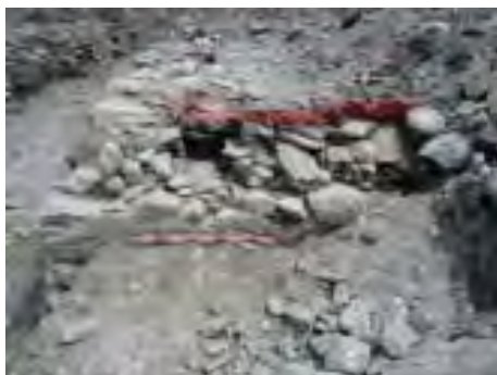
Fig. 9. L'angle nord-ouest de la Cantine de Proz, vu depuis l'ouest. Au niveau du rez-de-chaussée, les parois étaient doublées par un lambris de bois (en rouge).
