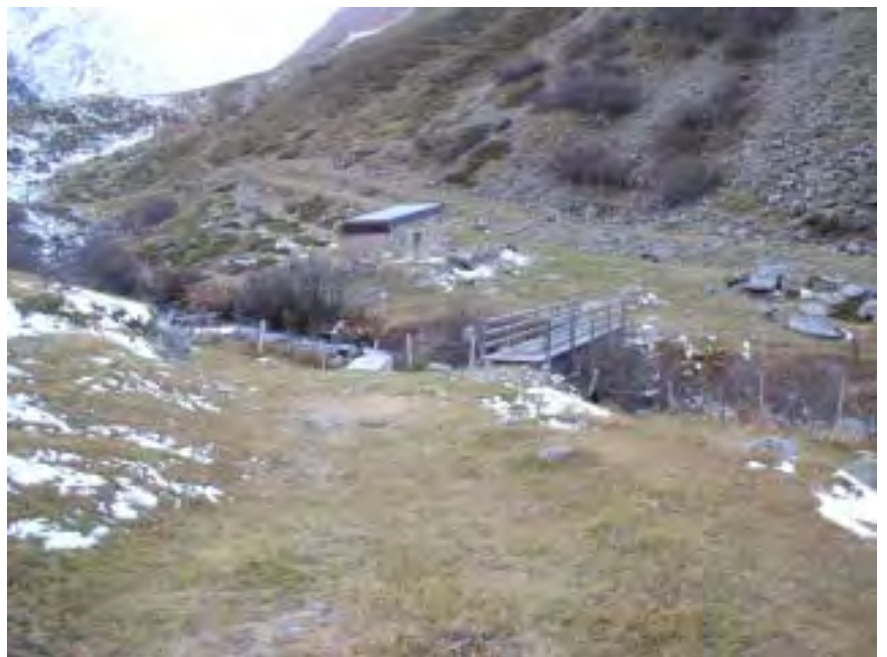
Fig.53. L'ancien cheminement aboutit à une passerelle qui franchit la Dranse et qui est empruntée par l'itinéraire pédestre actuel, témoignant d'une persistance du tracé historique. Sur l'autre rive, l'itinéraire tourne à gauche et tend ensuite à se perdre sous les remblais talutés du gazoduc moderne.
