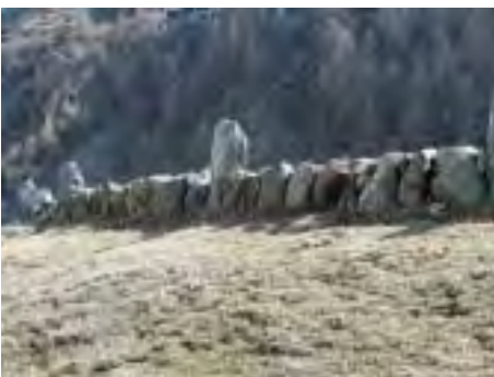
Fig. 28. Détail de l'image précédente. Face extérieure du bord de la chaussée renforcée par des dalles posées de biais et délimitée par des bouteroues.
