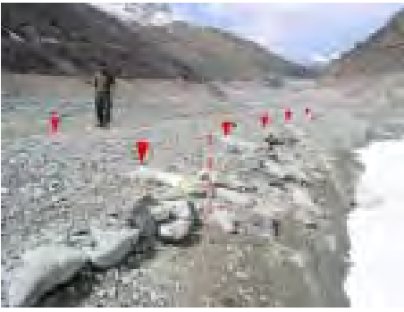
Fig. 26. La chaussée de la route utilisée entre 1893 et 1963, vue depuis la Cantine vers l'aval. Les bouteroues jalonnant jadis le tracé se sont déversées vers l'extérieur sous l'effet des fluctuations du niveau du barrage. A cet endroit, la route présente un profil bombé et forme une berme surélevée par rapport au terrain environnant.
