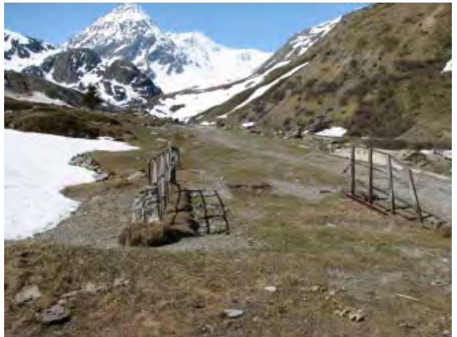
Fig.33. La route du XIX e siècle en amont de la Cantine, au sommet de l'alpage de Proz. L'ancienne passerelle métallique enjambant un bras du torrent de Perche. Vue vers l'amont.
