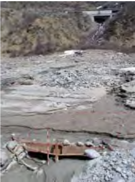
Fig.32. Tracé de la route du XIX e siècle. Sous la vase, on aperçoit l'ancien pont métallique aménagé au XX e siècle pour franchir le torrent de Pieudet. Vue vers l'est, en direction du flanc droit de la vallée. En haut de la photo, la route actuelle.
