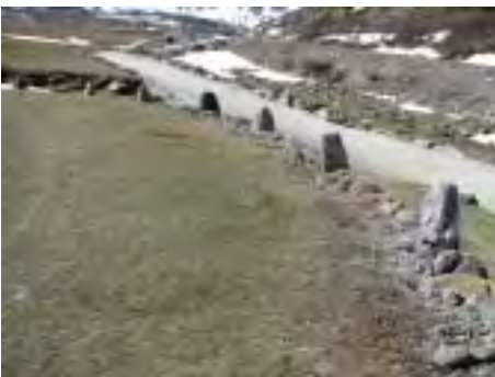
Fig. 27. Secteur en amont de la Cantine. L'un des virages de la route du XIX e siècle, avec ses bouteroues intactes, vu vers l'amont. A droite, la nouvelle piste d'accès du chantier.
