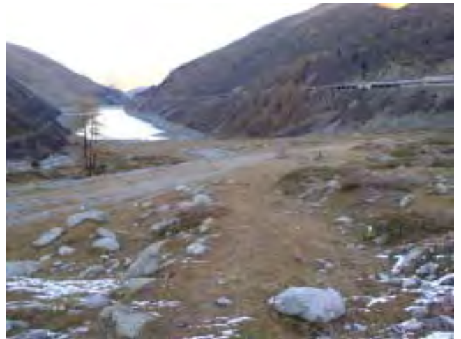
Fig.48. Sommet du pâturage de Proz. La rampe d'un tracé qui s'écarte de la route de 1893, juste en amont de l'ancienne passerelle métallique franchissant un cours d'eau.
