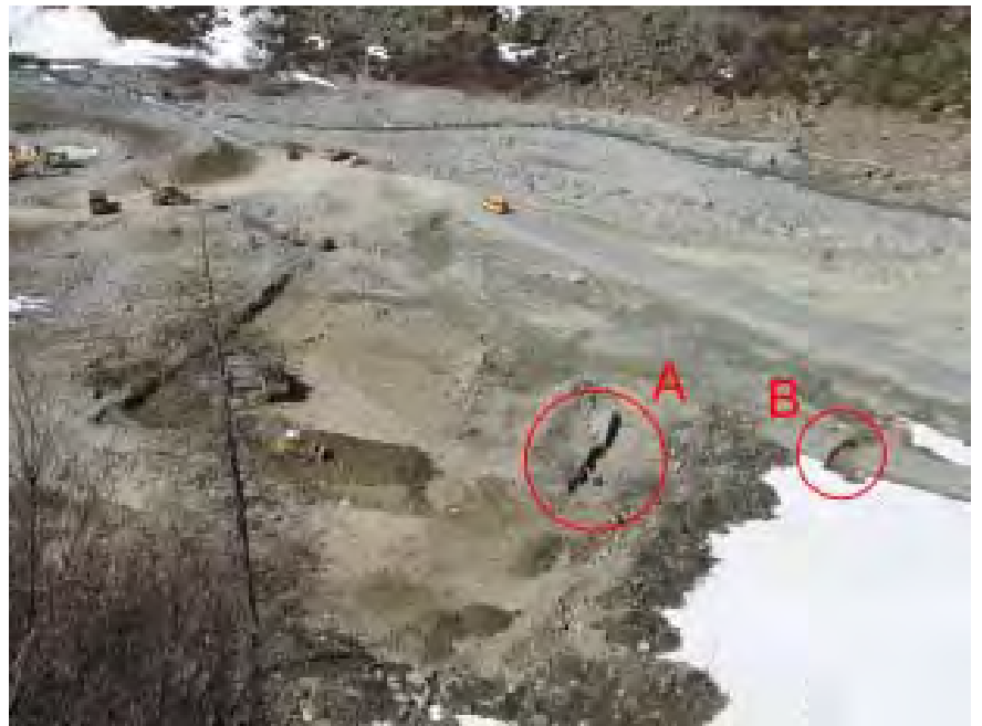
Fig. 4. Vue générale du chantier du barrage, en limite amont du lac (vue vers le sud-ouest). Les cercles indiquent la position respective des deux tranchées ouvertes à travers la Cantine de Proz (A) et la route du XIX e siècle (B).
