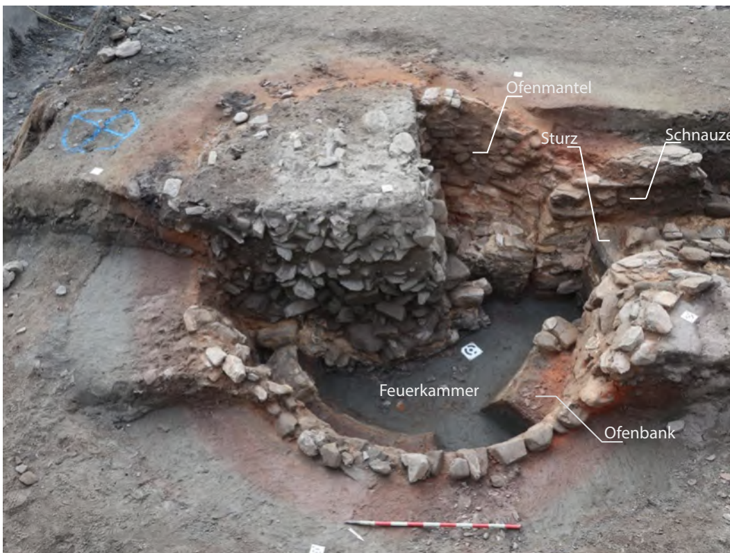
Abb. 14: Brig-Glis, Wieri. Photographie des Innenraums des Kalkbrennofens mit den verschiedenen Konstruktionselementen, in Blickrichtung Westen.
