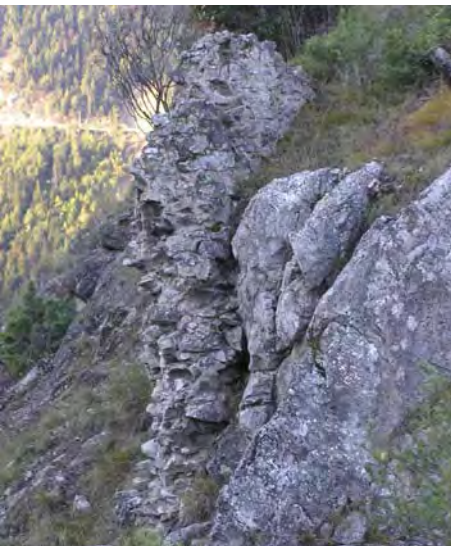
Fig. 9 Vestige du mur d'enceinte côté fossé.
