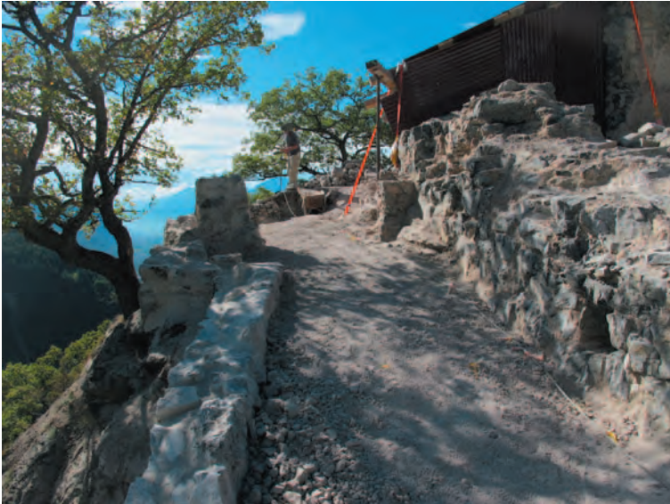
Fig. 4 Etat actuel de la rampe longent le logis après remontage de la courtine sud. Cette rampe conduit à la 3e porte séparant la cour inférieure de la cour supérieure. On distingue les deux piédroits de la porte à droite de l'arbre. Vue vers l'ouest.
