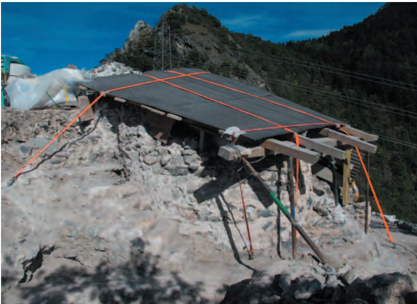
Fig. 18 Toit provisoire sur la tourelle d'escalier (C), en attendant la mise en valeur définitive. Vue vers l'est.
