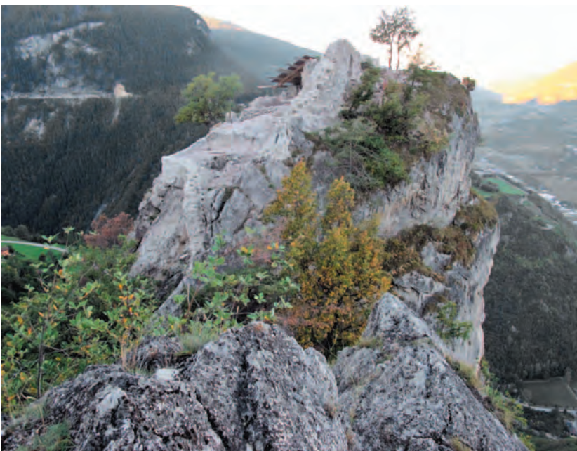
Fig.19. Vue générale du site après la fin des travaux de l'année 2010. Vue prise en direction de l'ouest depuis le pylône électrique.
