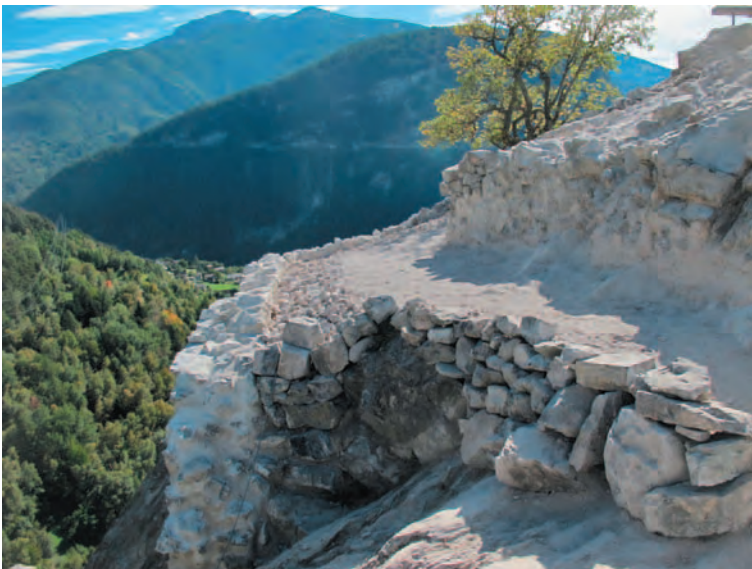
Fig. 6 Etat actuel de la courtine sud-est après remontage du mur d'enceinte et réaménagement de la rampe d'accès avec la terre dégagée dans le logis. Le muret au premier plan, posé à sec, sert à stabiliser les remblais; il sera démonté lors de la reprise des travaux. A droite, le mur oriental du logis, en cours de nettoyage. Vue en direction du Val d'Anniviers.
