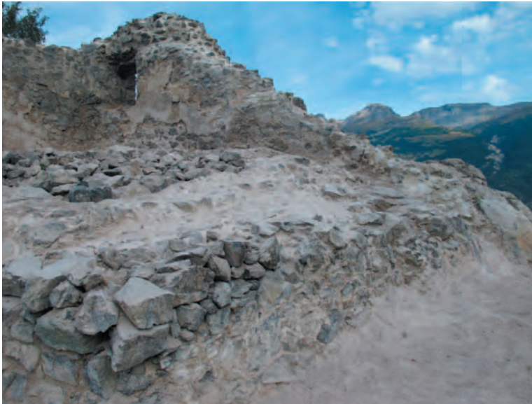
Fig. 7 Le logis vue depuis l'angle sud-est de la courtine. Les pierres réparties sur le sol du logis serviront à consolider les murs est et sud de ce corps de bâtiment. Ensuite, l'espace intérieur pourra être aménagé définitivement (surface moyenne 5 x 6 m).
