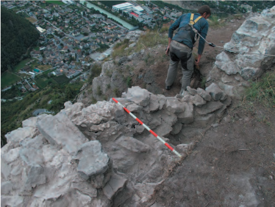
Fig. 2 Détail de la courtine ouest en cours de dégagement et de remontage. Le cliché montre bien les conditions de travail. Vue en direction du nord-ouest, avec Chippis en contrebas.
