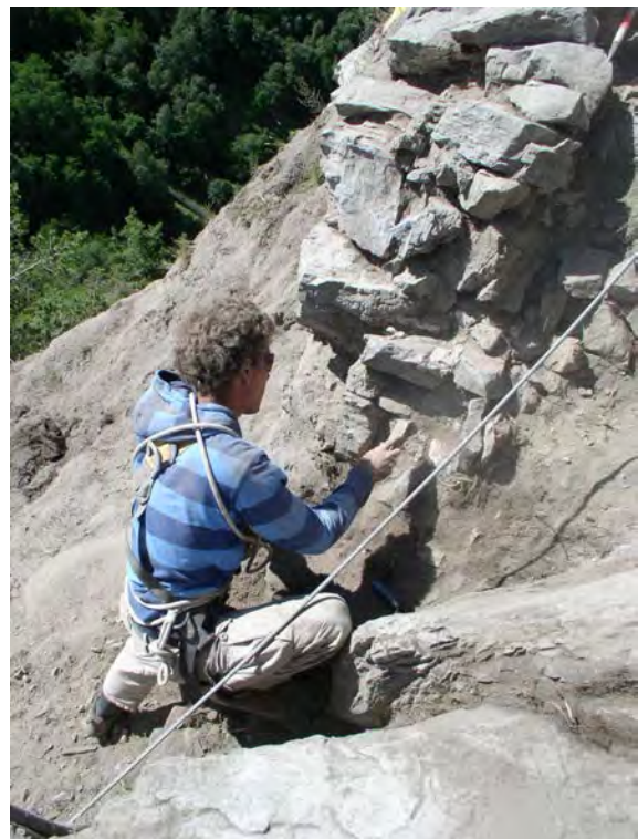
Fig. 5 Négatif de montant en bois observé dans la maçonnerie de la courtine (indiqué par la main du fouilleur).
