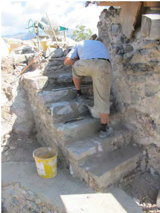
Fig.22 L'escalier conduisant à la terrasse supérieure: travaux de remontage.
