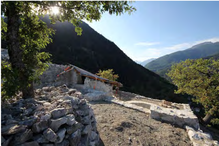
Fig.26 La terrasse supérieure à la fin des travaux 2011.
