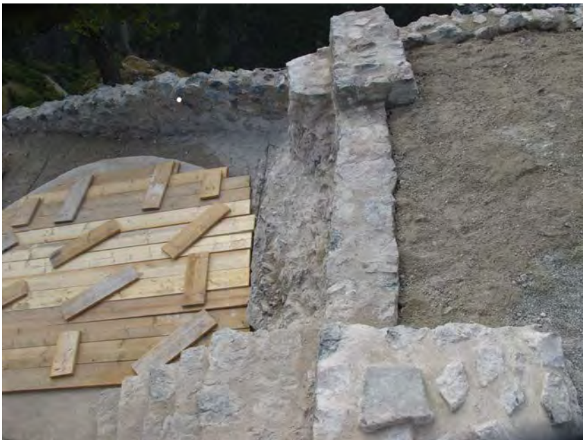
Fig.20 Couverture provisoire de la citerne.
