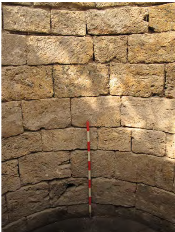
Fig. 7 Parement de la citerne en blocs de cargneule taillés. Une couche de limon argileux vert olivâtre dans et contre laquelle les blocs sont adossés assure l'étanchéité.
