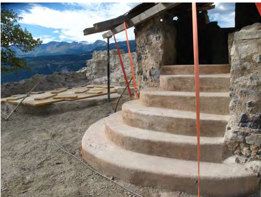
Fig.21 Etat de la cour de la citerne à la fin des travaux 2011.
