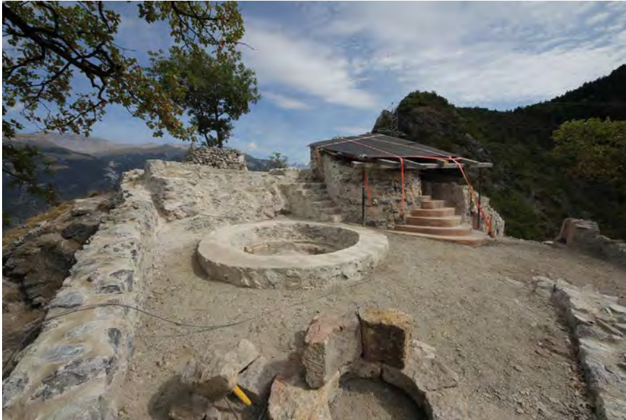
Fig.25 La cour de la citerne à la fin des travaux 2011.
