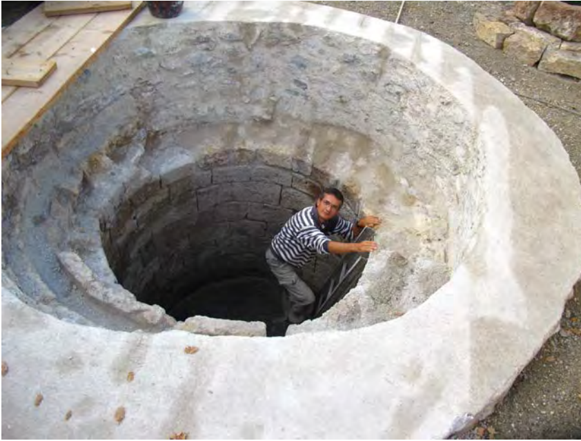
Fig.19 La citerne après consolidation du parement intérieure et remontage de la margelle.
