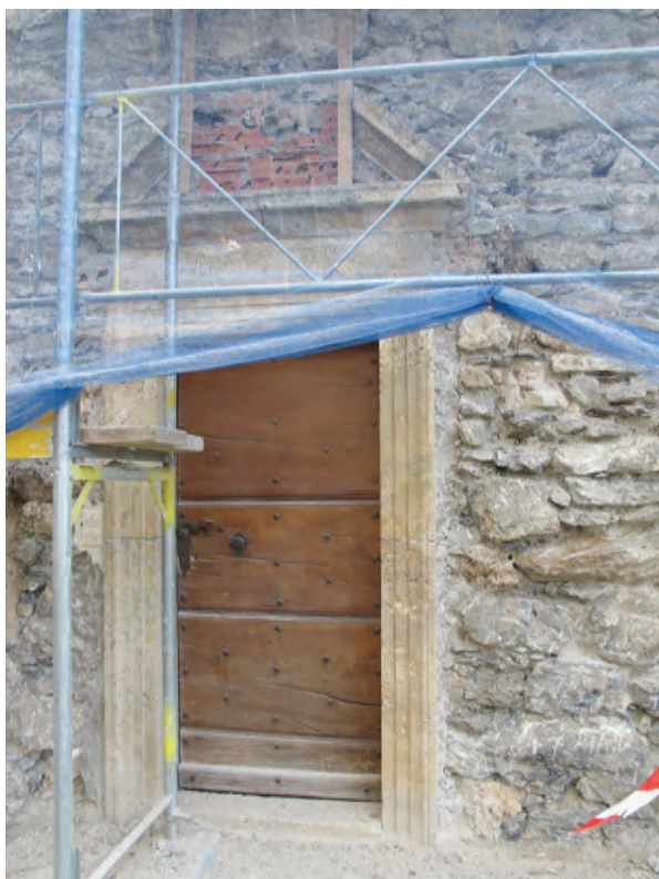
Fig. 15. Façade Ouest, porte d'entrée. Le cadre primitif a été remplacé.
