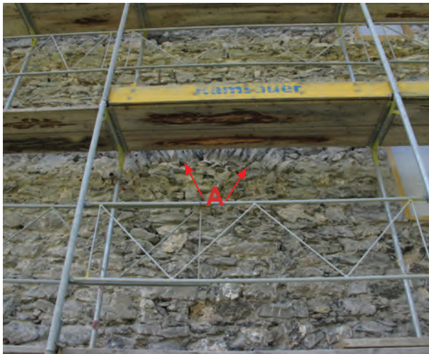
Fig. 9. Façade Est, arc de décharge dans la maçonnerie primitive.
