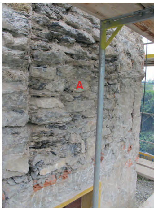
Fig. 13A et B. Façade Nord. A: porte bouchée du 2e étage.
