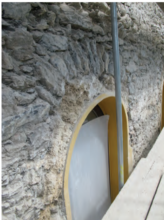
Fig. 2. Façade Sud, porte de la cave.
