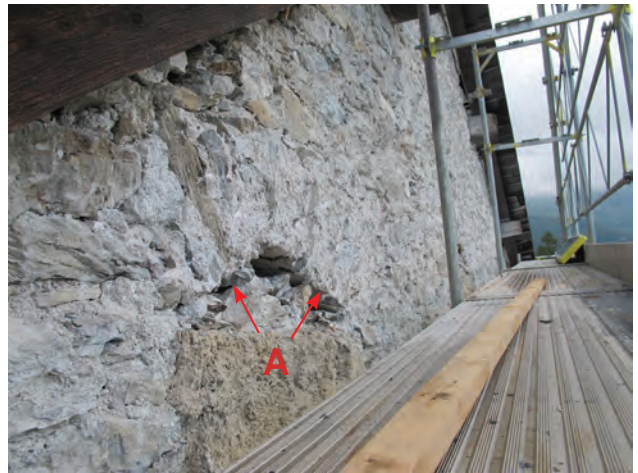
Fig. 7. Façade Sud, fenêtre des combles. A: Planches obliques surmontées d'un arc de décharge.
