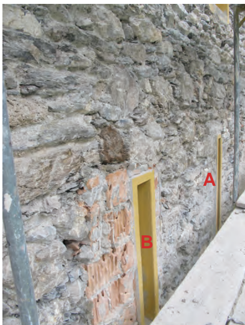
Fig. 12. Façade Nord, fenêtre du 1er étage (rez-de-chaussée). A: fenêtre primitive. B: fenêtre redimensionnée.
