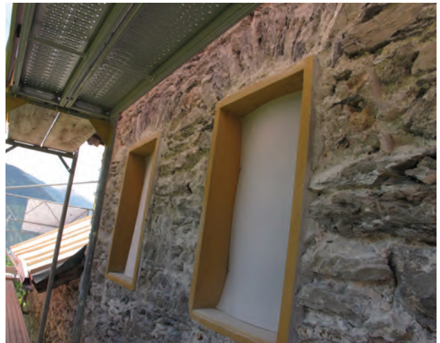
Fig. 10. Façade Est, fenêtres des combles avec cadre maçonné.
