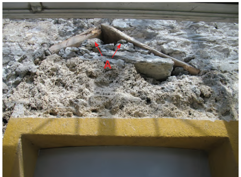
Fig. 6. Façade Sud, fenêtres des combles. A: Planches de décharge.
