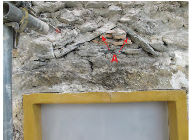
Fig. 3. Façade Sud, fenêtre du 2e étage. A: Dalles de décharge.
