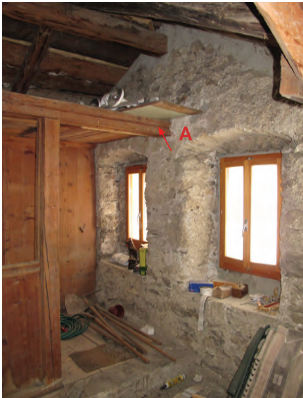
Fig. 18. Combles, Chambres en bois de 1833. A: reinure ddes planches du plafond.
