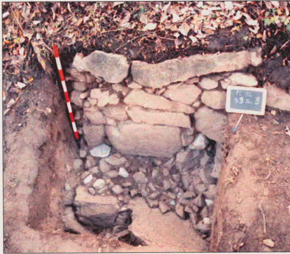
1 Fig. 1 Parement du rempart nord, conservé sur une hauteur d'environ 1m
