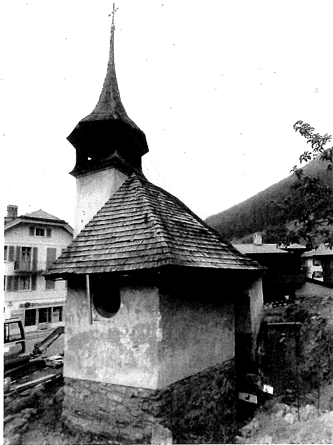
Blick gegen Westen. Zustand nach der Freilegung der Fundamentmauern.
