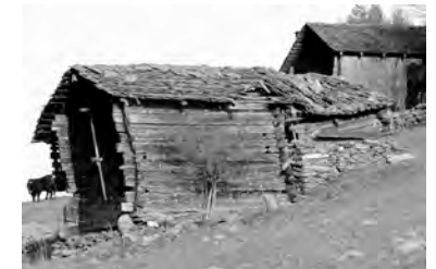
Fig. 9. Bâtiments semi-enterrés actuels. Granges-écuries aux Crétaux (Iséables).
