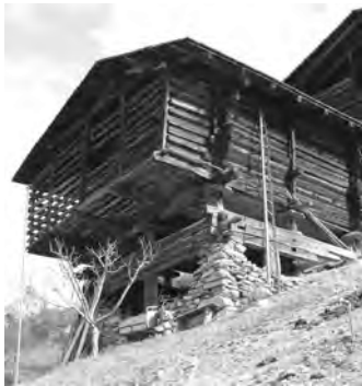
Fig. 12. Bâtiment actuel surélevé dans la pente à Isérables (cliché 2005).
