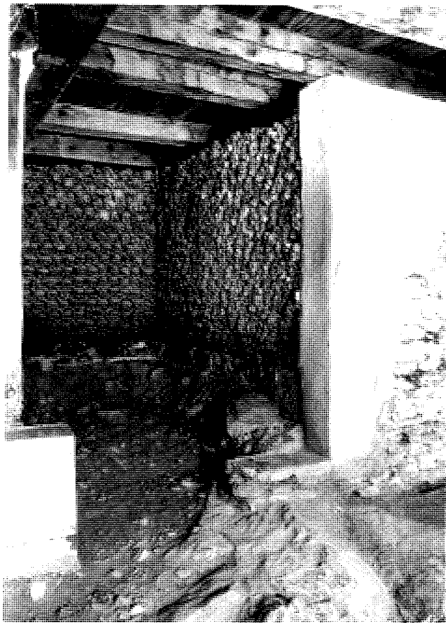
Nordostbereich des Beinhauses rechts die Trennwand zum ehem. Kapellbereich.
