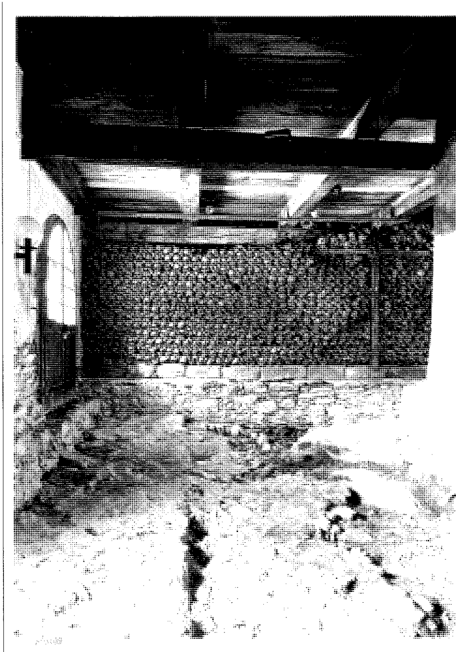
Südteil des Beinhauses gegen Westen im Vorder- und Mittelgrund links das Fundament (7), rechts das Fundament (2).
