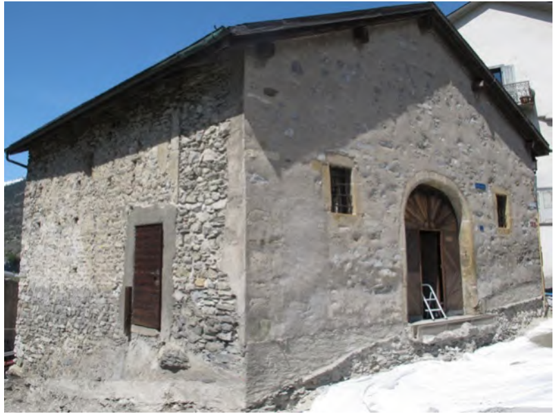
Fig. 2 – Leuk-Stadt, Rathausplatz. Maison Spritzenhaus lors des travaux de 2018. Vue du sud-est.
