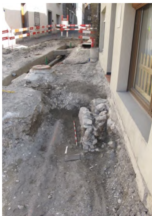
Fig. 38 – Leuk-Stadt, Rathausplatz. Hauptplatz, au pied de la façade ouest de la maison formant l'angle sud-ouest du quartier (pizzeria Burg). Le mur (M14) a été rhabillé par du ciment (A) sur sa face ouest. Son chaînage d'angle nord-ouest (B) est constitué de gros moellons taillés (disparu lors du dégagement). A l'arrière plan, la canalisation UT15 observée dans le profil d'une tranchée moderne. Vue du nord.
