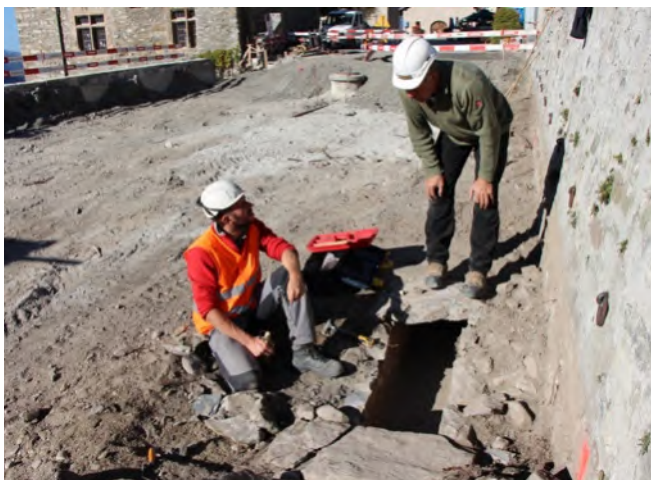
Fig. 41 – Leuk-Stadt, Rathausplatz. Au nord-est du Rathaus, une canalisation similaire à celle de la rue Zum Gaisstall a été retrouvée en 2017 le long du mur de soutènement longeant la route créée en 1830. Vue de l'est. Photo Archéologie Cantonale.
