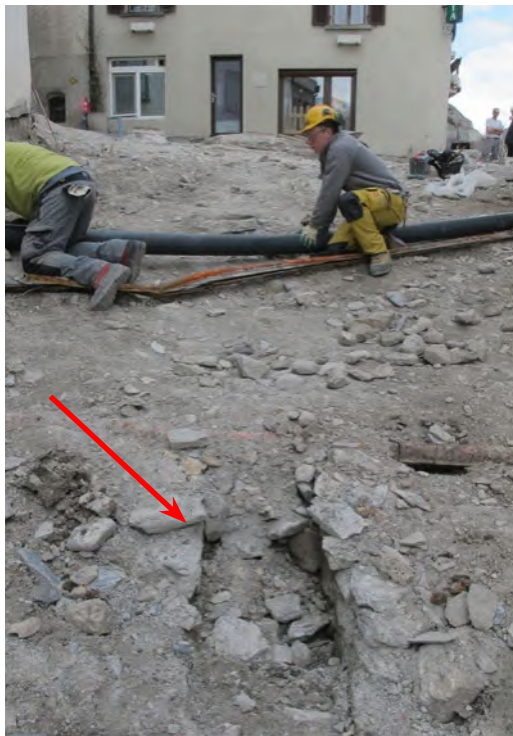
Fig. 39 – Leuk-Stadt, Rathausplatz. Zum Geissstall. Canalisation UT38 aménagée dans la rue, peut-être au 19 e siècle. Vue de l'ouest.
