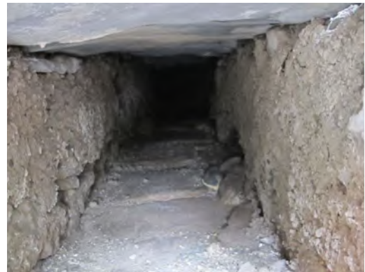
Fig. 40 – Leuk-Stadt, Rathausplatz. Zum Geissstall. Canalisation UT38 aménagée dans la rue. En parfait état de conservation avant les travaux de 2018. Vue de l'est.
