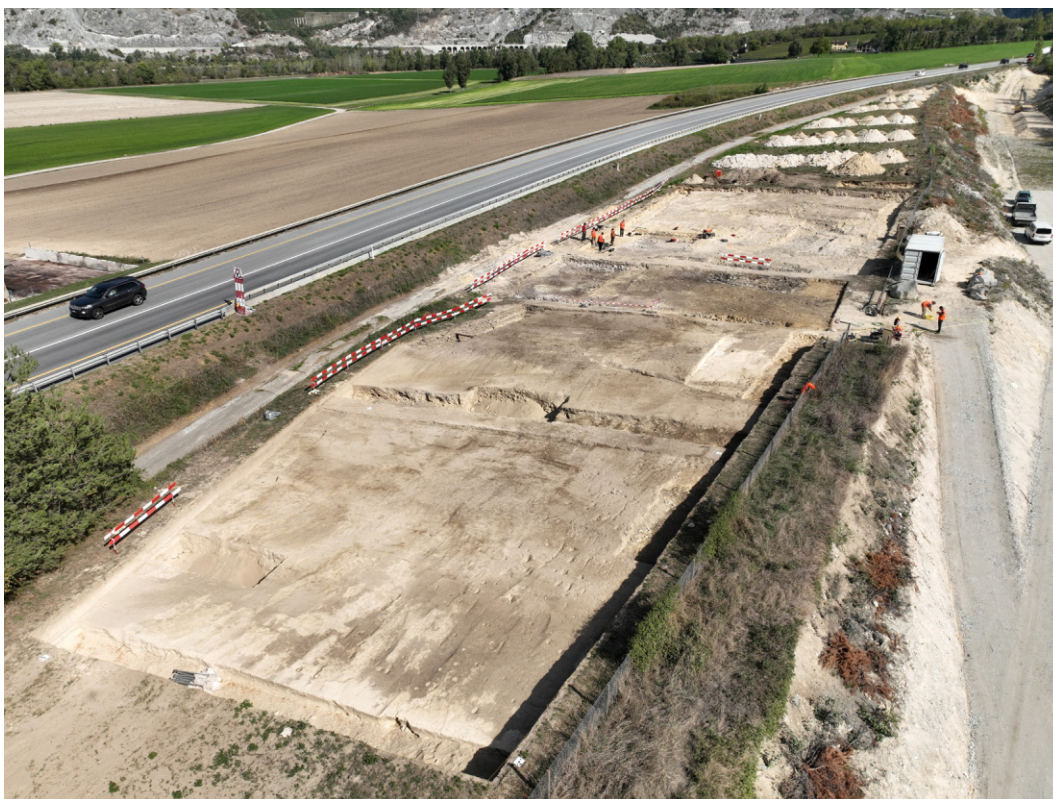
Fig. 12 – Vue générale du chantier en début de fouille, septembre 2022 (© InSitu).
