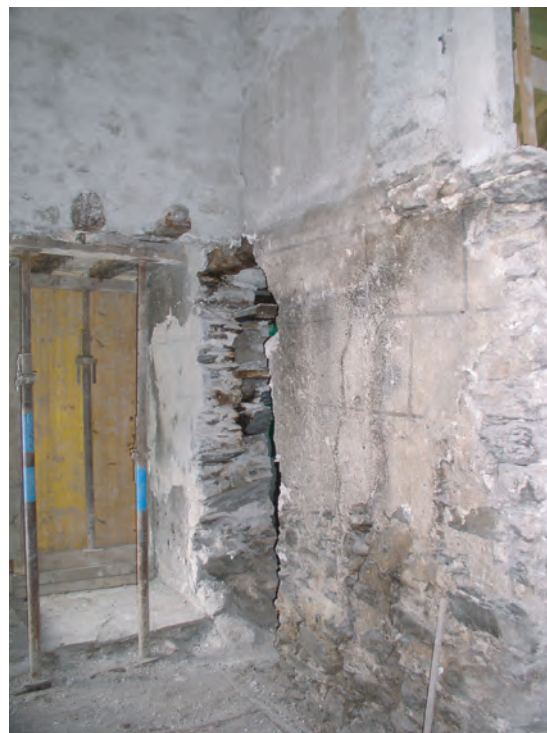
Fig. 29: Corps Principal. Détail du crépi conservé contre sa façade Est (niveau du 1er étage).
