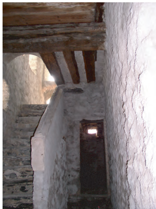
Fig. 14: Annexe Est, rez. Escalier maçonné. Vue sud.
