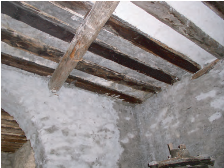
Fig. 21: Annexe Est, rez (Pressoir). Plafond composé d'un solivage axé Nord-Sud avec entrevous maçonnés. Vue ouest.
