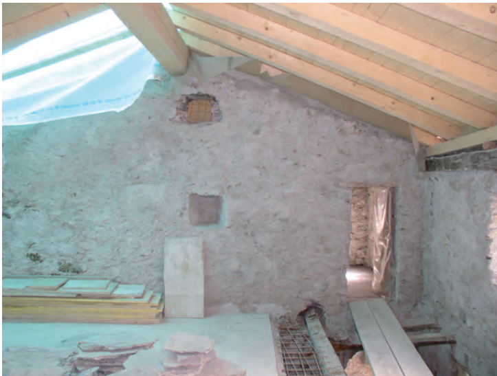
Fig. 34: Corps Principal, 2e étage (combles), paroi est. A droite, la porte qui conduit à la chambre aménagée dans l'Annexe Est, au centre, deux anciennes fenêtres transformées en niche.
