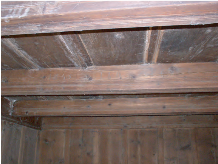
Fig. 31: Annexe Nord-Est. Chambre boisée datée de 1845 ; détail du solivage.
