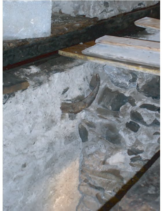
Fig. 18: Annexe Est, rez, paroi orientale au-dessus de la voûte de la cave à vin. Détail de la paroi crépie avec la corne en guise de crochet.
