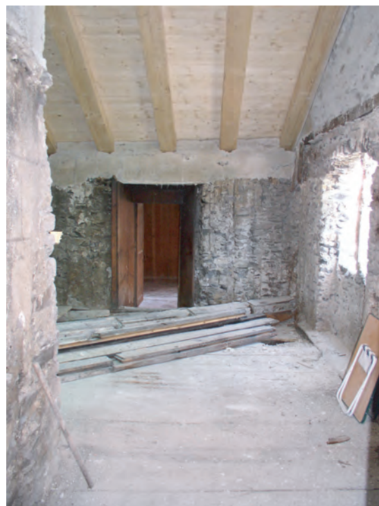
Fig. 27: Annexe Est, 1er étage. Les parois Est et Nord portent des négatifs très profonds de la boiserie. Vue nord.
