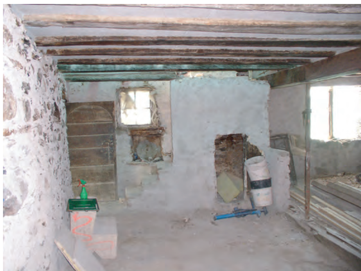
Fig. 24: Corps Principal, 1er étage. L'escalier en maçonnerie qui mène aux combles. Vue sud.
