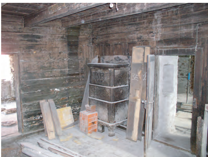
Fig. 25: Annexe Ouest, 1er étage. La chambre boisée avec son fourneau daté de 1857 aménagé dans l'angle nord-est.
