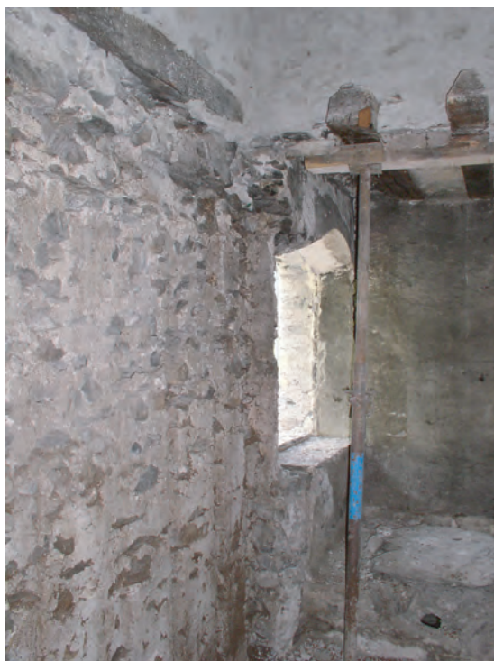
Fig. 28: Annexe Est, 1er étage. Négatifs de la boiserie contre la paroi Est et amorce d'une maçonnerie démolie qui venait clore la pièce côté sud. Vue sud-est.
