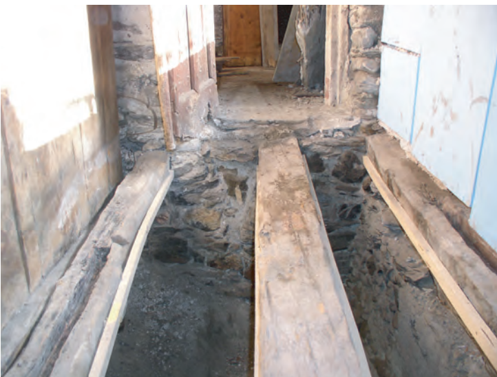
Fig. 19: Annexe Nord-Est. Solivage du balcon, les deux solives latérales rainurées.
