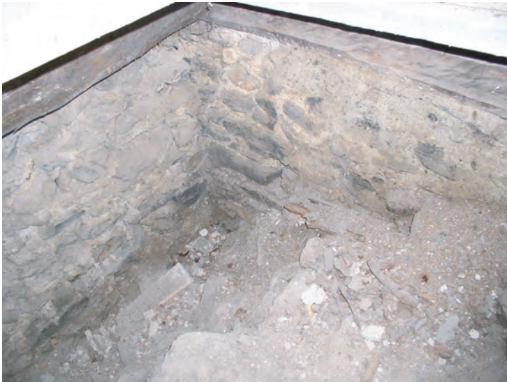
Fig. 20: Annexe Est. Angle Nord-Ouest. A droite, négatif d'arrachement.
