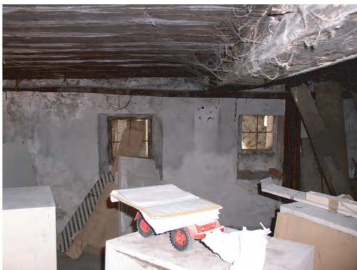
Fig. 12: Annexe Ouest, rez supérieur (Grange 2). Les ouvertures (69 et 70) du mur Nord avec leurs embrasures de tailles différentes.
