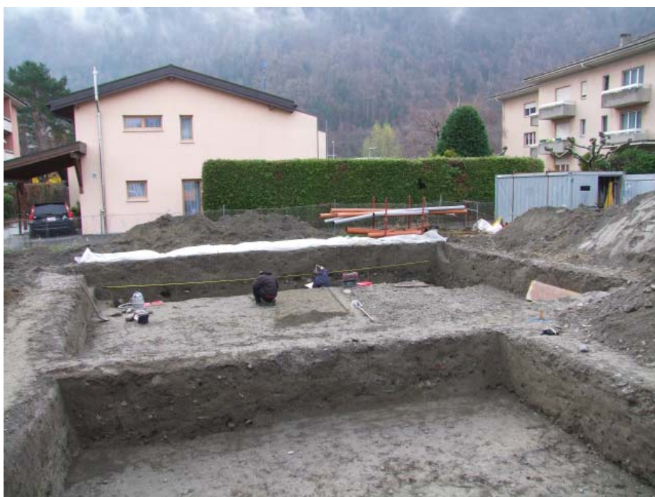
Martigny, La Délèze. Vue générale en direction du sud.
