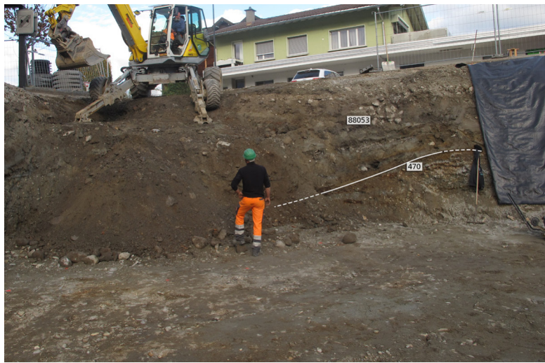
Fig.7 – La rivière 470 a été partiellement observée dans les profils de l'excavation à 4 m de profondeur. Vue en direction du nord-est.
