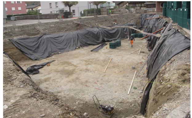
Fig.4 – L'excavation pour la construction d'un bassin d'infiltration atteint 4 m de profondeur. Vue en direction du sud-ouest.
