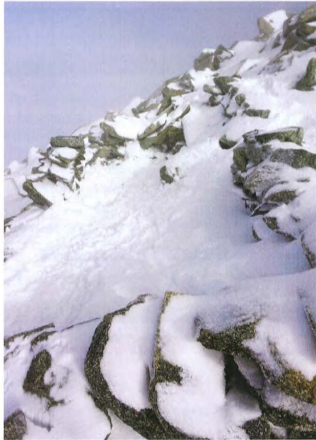
BAT 3. VUE EN DIRECTION DU NORD-OUEST, AVEC LE MURET AVAL EN PARTIE EFFONDRE
