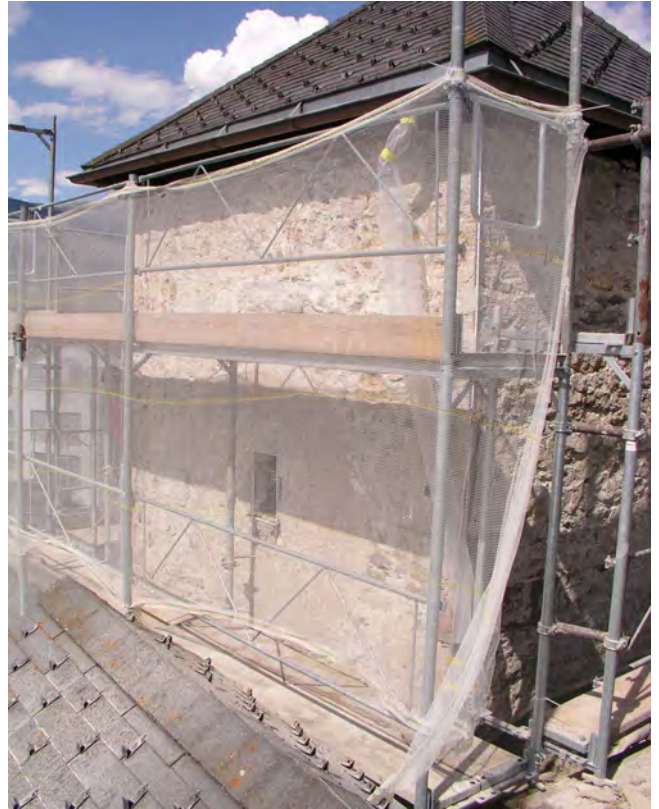
Abb.6 Kindergarten, oberstes Turmgeschoss von Südwesten.
