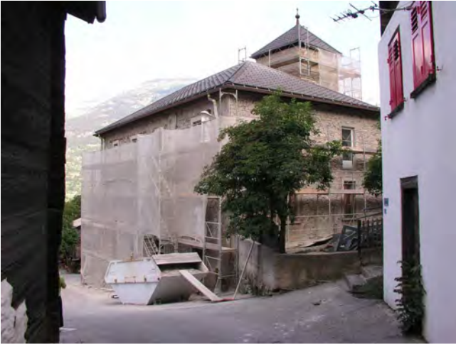
Abb.1 Ried-Brig, Kindergarten, Ansicht von Südosten.
