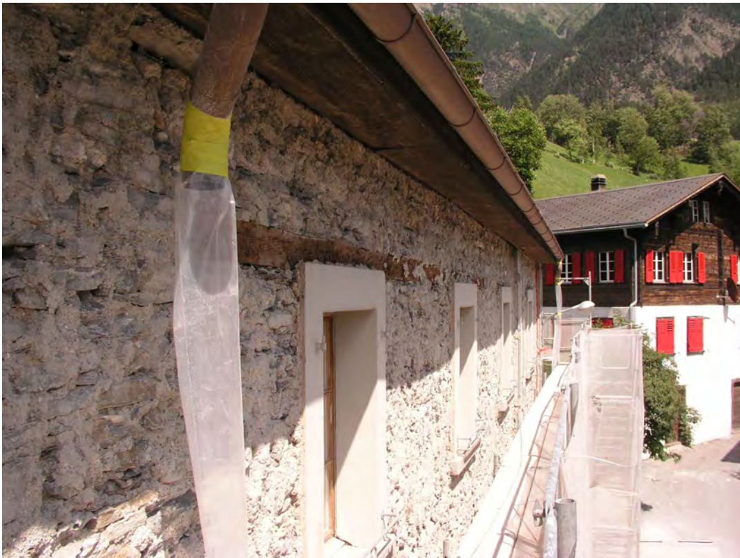
Abb.11 Kindergarten, Südfassade : Fenster des 3. Geschosses. Nur die Fensterbank ist aus Granit, Gewände und Sturz waren ursprünglich aus Holz (hier in Zement erneuert).
