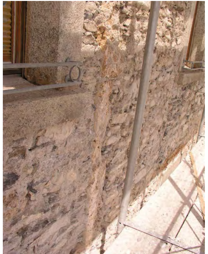
Abb.4 Kindergarten, Südfassade : Tuffsteinrahmen eines vermauerten Kapellenfensters.
