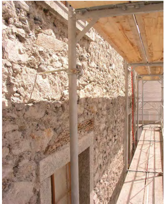
Abb.10 Kindergarten, Westfassade : Fenster des 2. Geschosses. Rahmen und Fensterbank sind aus Granit.
