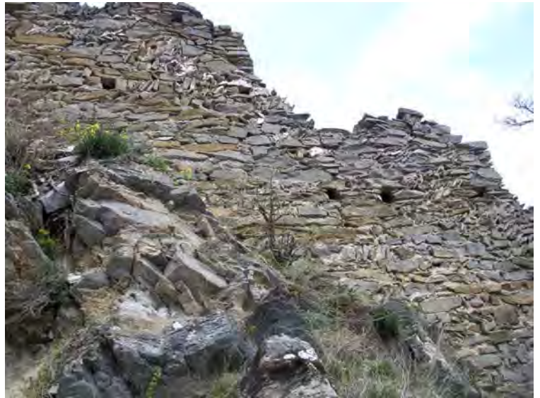
Fig. 12 Muraille occidentale, face extérieure de la partie amont. On distingue la limite oblique entre les maçonneries UT4 (partie inférieure) et UT5 (partie supérieure).
