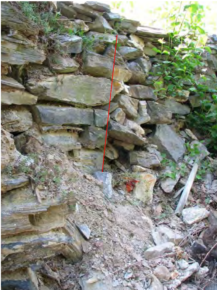
Fig. 17 Tronçon nord de l'enceinte avancée, face extérieure. Montant ouest d'une ouverture indéterminée.
