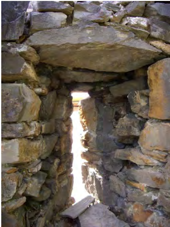
Fig. 5 La meurtrière supérieure du 1er mur occidental (UT1), face intérieure.
