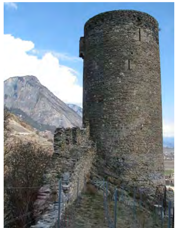
Fig. 14 Vue générale du tronçon le mieux conservé de l'enceinte nord, avec le chemin de ronde. Vue vers l'est.
