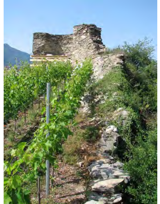
Fig. 4 Le tronçon nord de l'enceinte avancée. Vue vers l'ouest.
