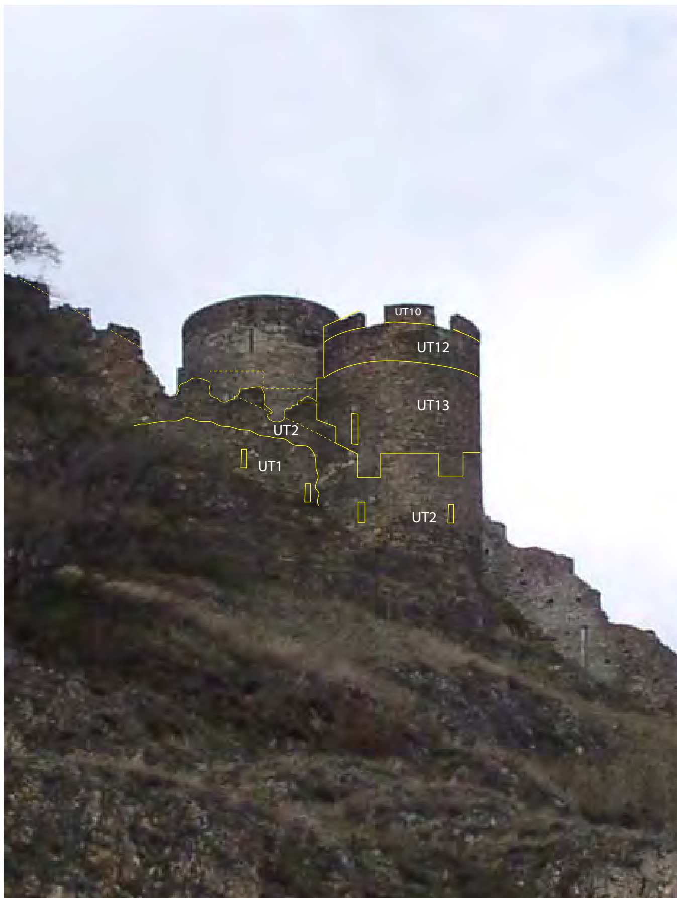
Fig. 7 Tour médiane "B", avec la partie aval du tronçon d'enceinte qui s'étire vers le nord, face extérieure. 1e phase: UT1; 2e phase: UT2; 4e phase: UT13 (exhaussement de la tour); 5e phase: UT10 et UT12 (crénelage de la tour).
