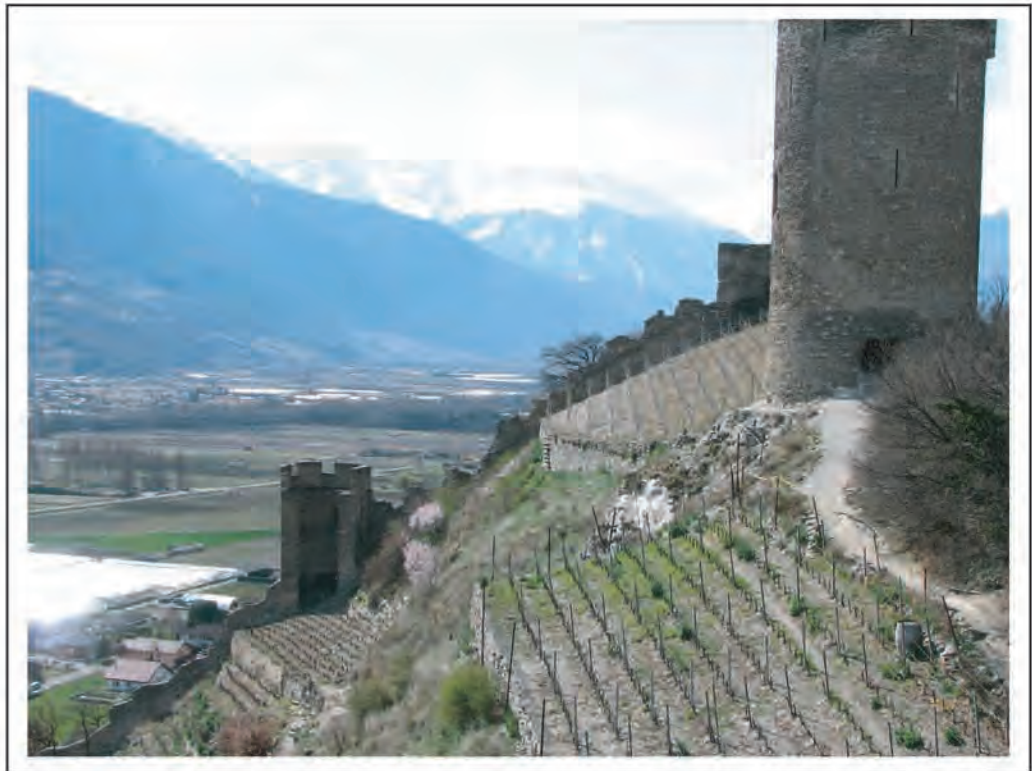
Enceinte occidentale, face intérieure
