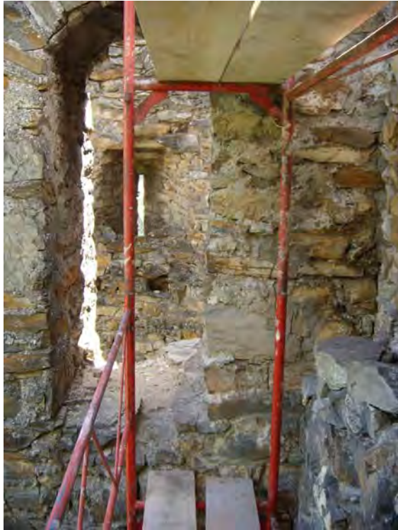
Fig. 11 Porte de la tour médiane "B", aménagée lors du 1er l'exhaussement (UT13). Vue vers le sud. A droite le ressaut du mur d'enceinte.
