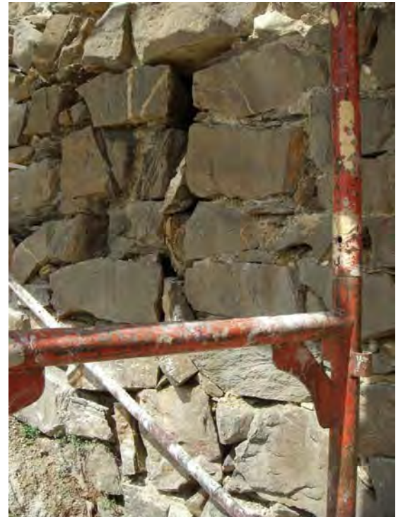
Fig. 6 La meurtrière inférieure du 1er mur occidental (UT1), face extérieure.
