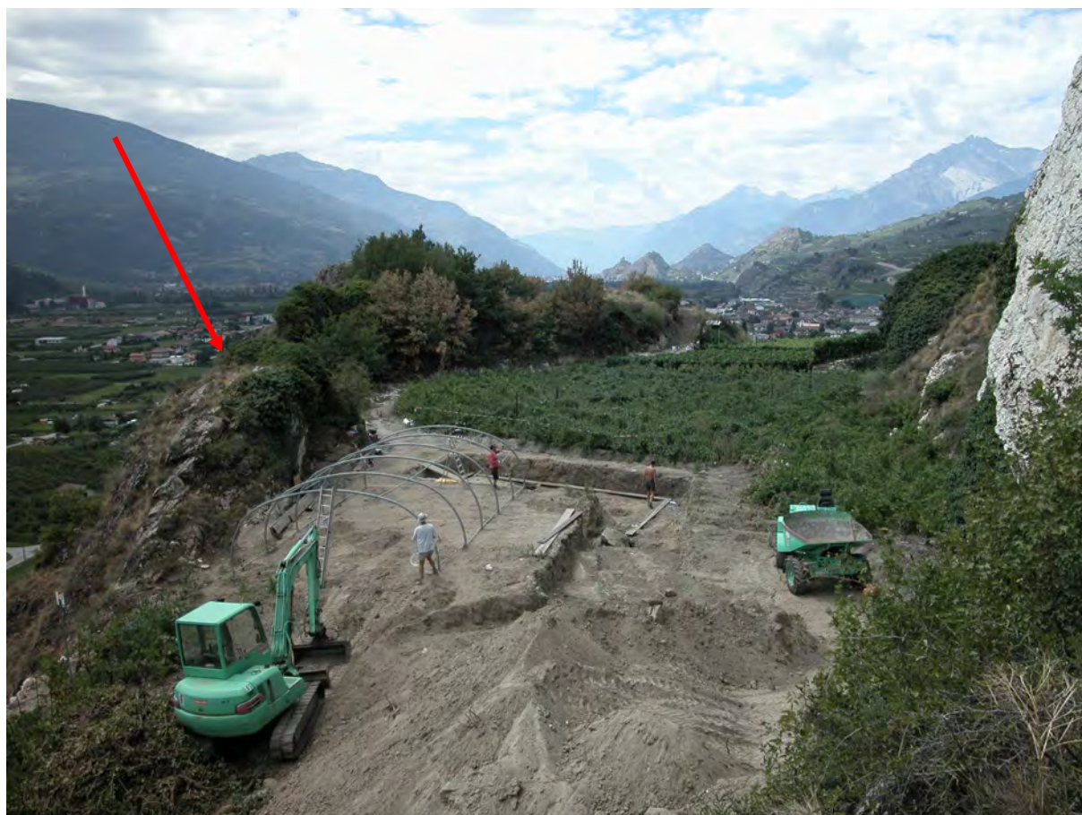
Figure 2 : vue du plateau ouest (GQ) depuis son extrémité orientale. La zone où la vigne a été arrachée correspond à l'emprise maximale de terrain pour la construction de la route de chantier. La flèche rouge indique l'emplacement sur la crête rocheuse limitant l'ensellement au sud d'une série de grandes cupules inédites.
