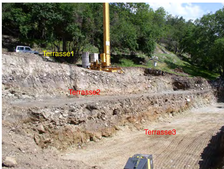
Fig. 9 Saint-Martin, « La Gréferic ». Travaux de terrassement effectués au niveau de l'étable avant l'intervention archéologique. Vue depuis le nord-ouest.
