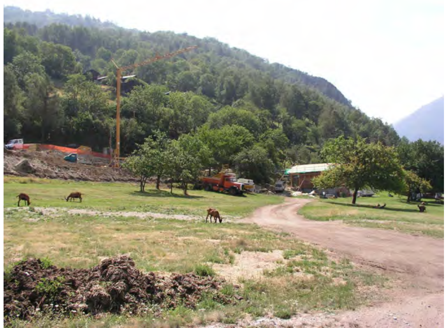
Fig. 7 Saint-Martin, « La Gréferic ». Le chantier de l'étable se situe au pied du versant qui domine le plateau. Vue depuis le nord-ouest.
