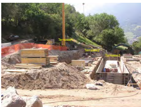
Fig. 10 Saint-Martin, « La Gréferic ». Travaux de coffrage pendant l'intervention des archéologues. Vue depuis le nord.
