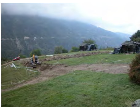
Fig. 5 Saint-Martin, « La Gréferic ». Vue générale des tranchées, en septembre 2005. Vue depuis le sud-est.
