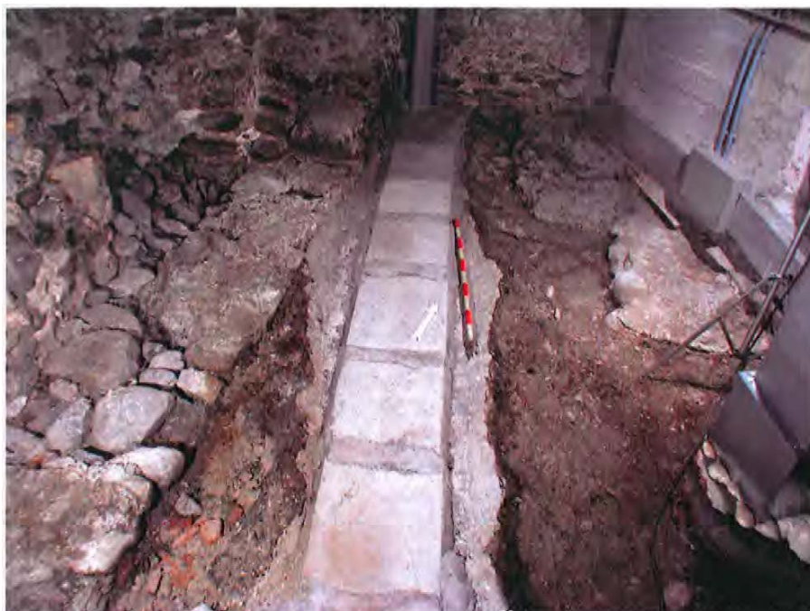
fig. 6 Les vestiges arasés de la quatrième cave, dégagés de part et d'autre d'une conduite moderne. Vue vers le nord..
