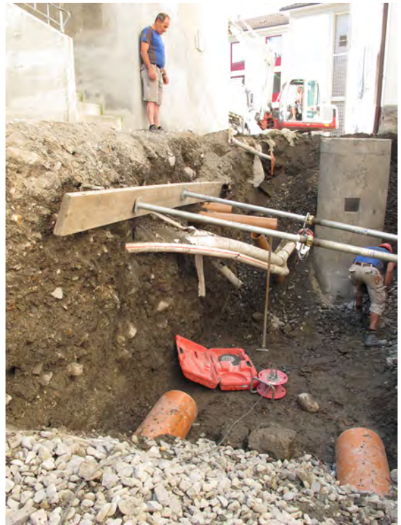
Fig. 3. St-Maurice, Jardin de l'Octogone. Tranchée 3, vue générale depuis le nord.
