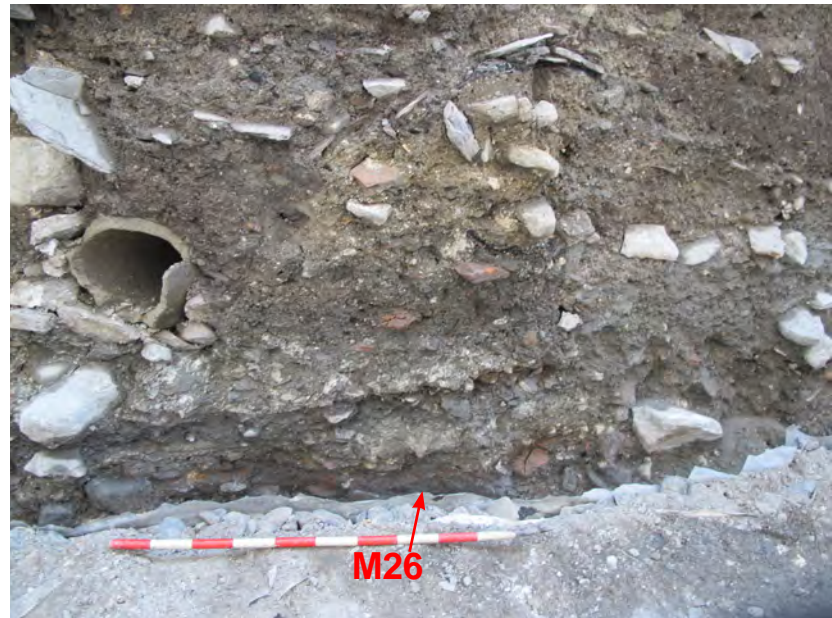
Fig. 15. St-Maurice, Jardin de l'Octogone. Tranchée 1, profil est, vu depuis l'ouest. UT26 : sol de la période 2, constitué de silts gris, couvert de poussière et de copeaux de bois résultant peut-être de la présence d'un plancher (UT27).
