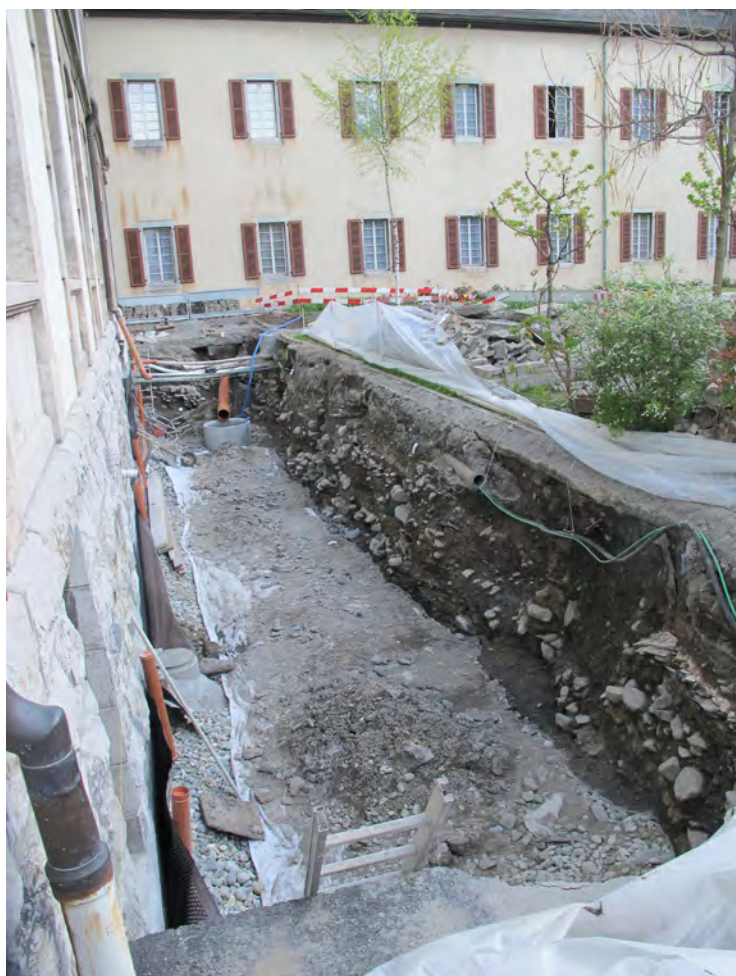
Tranchée ouest, au pied de l'internat, dans le jardin de l'Octogone
