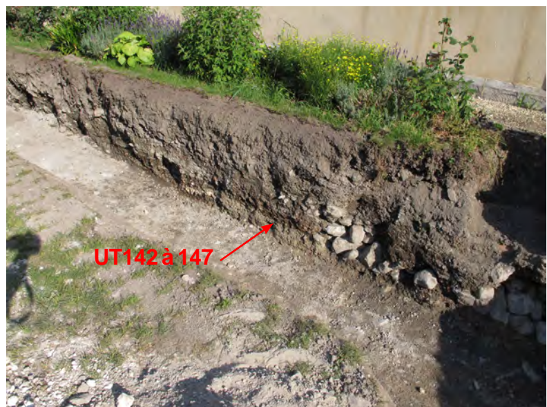
Fig. 33. St-Maurice, Jardin de l'Octogone. Tranchée 2, profil nord, vu depuis le sud-est. UT142 à 147 : couches déposées au cours d'un chantier de construction : celui de l'ancienne aile sud, ou celui de l'aile sud actuelle de l'abbaye.
