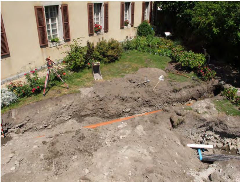
Fig. 6. St-Maurice, Jardin de l'Octogone. Tranchée 4, vue générale depuis le sud-ouest.
