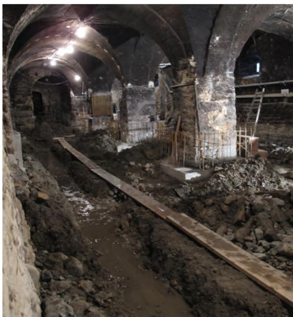
**Fig. 6.** Salle du trésor. Les profondes tranchées de drainage n'étaient pas prévues. Le démontage des ressauts de fondation a provoqué un affaissement des voûtes.
