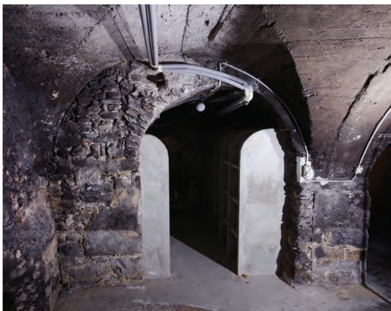
**Fig. 80.** Salle du trésor, même endroit après démontage des casiers et sablage des parois.
