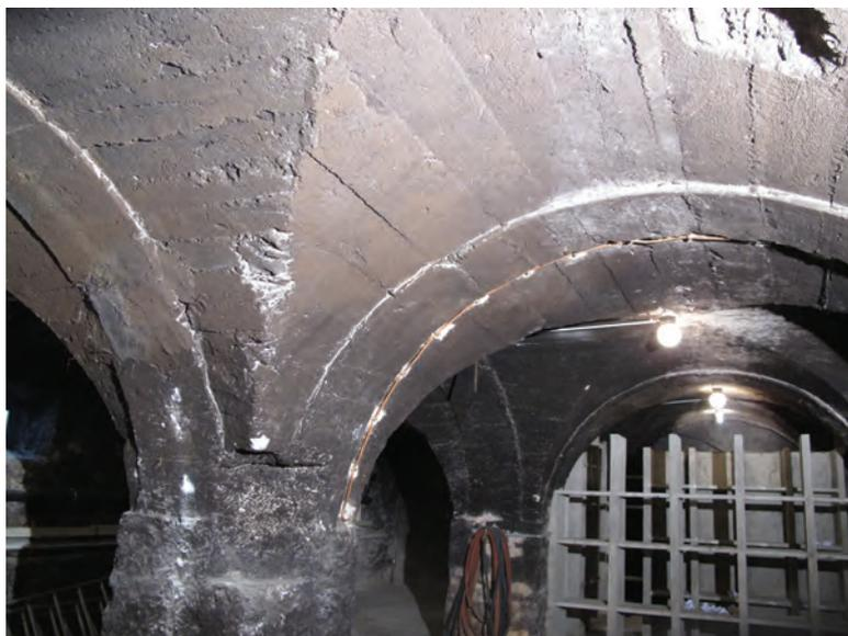
**Fig. 74B.** Détail de l'empreinte d'une planche moulurée en rempli.
