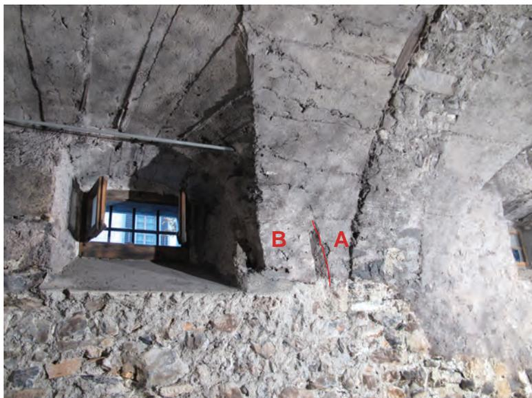
**Fig. 74A.** Salle du trésor, détail de la voûte maçonnée (M654) avec les empreintes du coffrage de construction.
