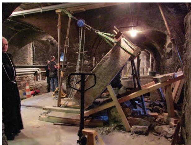
**Fig. 88.** Salle du trésor, démontage du pressoir rond.
