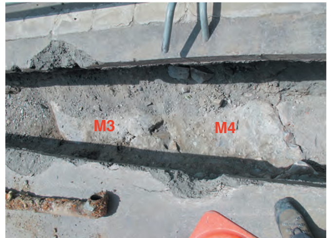
Fig. 6 Avenue d'Agaune. Tranchée vue vers l'est. Le mur M3 doublé par le mur M4 (à gauche).
