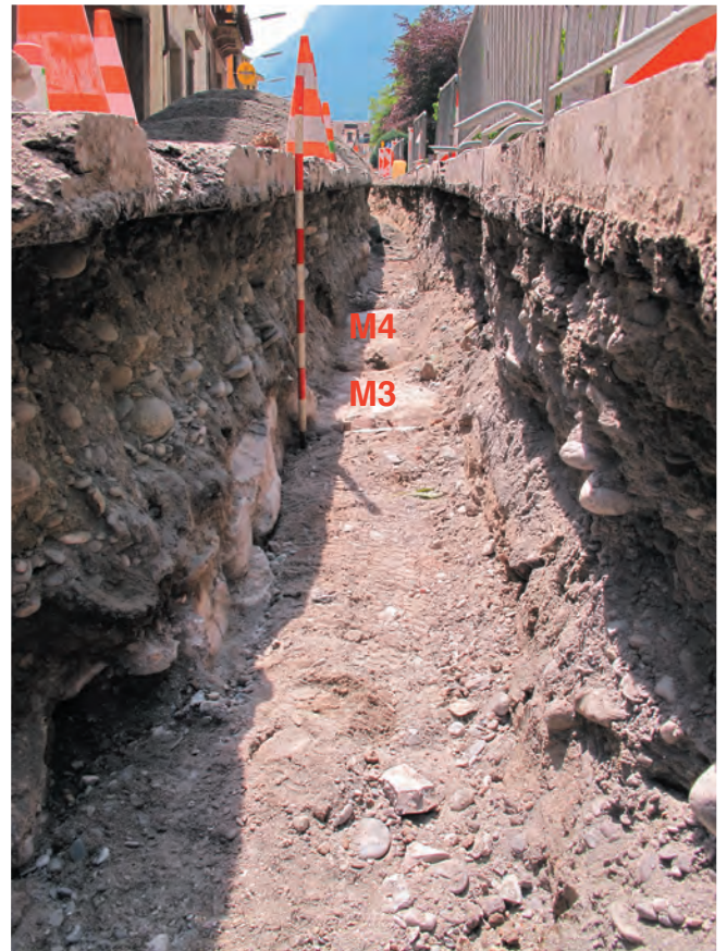
Fig. 4 Avenue d'Agaune. Tranchée vue vers le sud. La mire indique l'anglé chaîné des murs M2-M3.
