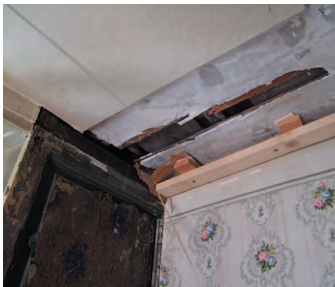
Fig. 30B Bâtiment n° 63/65, 1er étage, local 2.11N. Salle d'angle aux boiseries simples, sondage dans le plafond (angle sud-est). Sous le lambris récent est apparu un plafond en carreaux de pavatex collé sur une couche de plâtre. La hauteur du plafond ancien est indiquée par la limite de coloration gris-bleuté de la boiserie.
