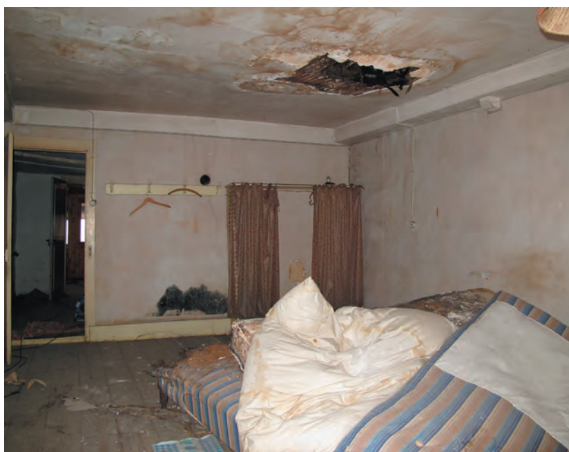
Fig. 15 Bâtiment n° 59, 2e étage, local 2.1. Le solivage du plafond est posé latéralement sur une poutre de rive tenue par des consoles.
