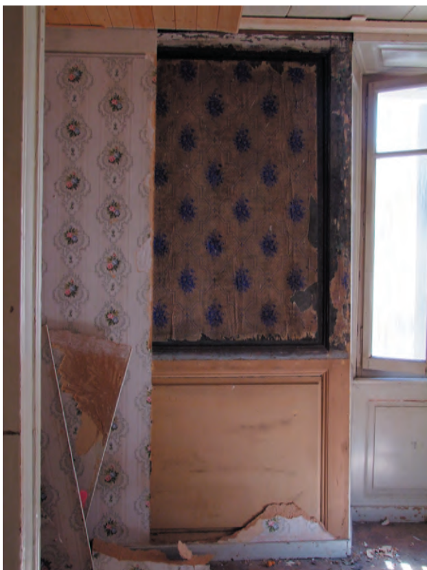
Fig. 30C Bâtiment n° 63/65, 1er étage, local 2.11N. Salle d'angle aux boiseries simples. L'ancienne boiserie est entièrement conservée. Elle a d'abord été transformée en lambris d'appuis de couleur blanc-crème avec tapisserie en papier, avant d'être recouverte par des panneaux de pavatex.
