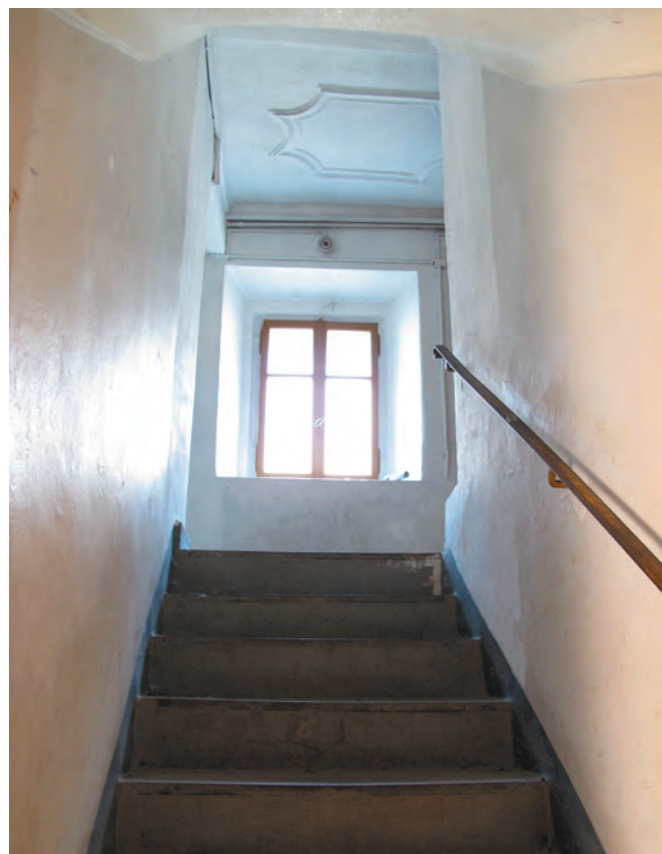
Fig. 33 Bâtiment n° 63/65, local 2.13. Escalier menant au 2e étage. Le palier supérieur est orné d'un médaillon en stuc. Vue générale vers le nord avec détail.
