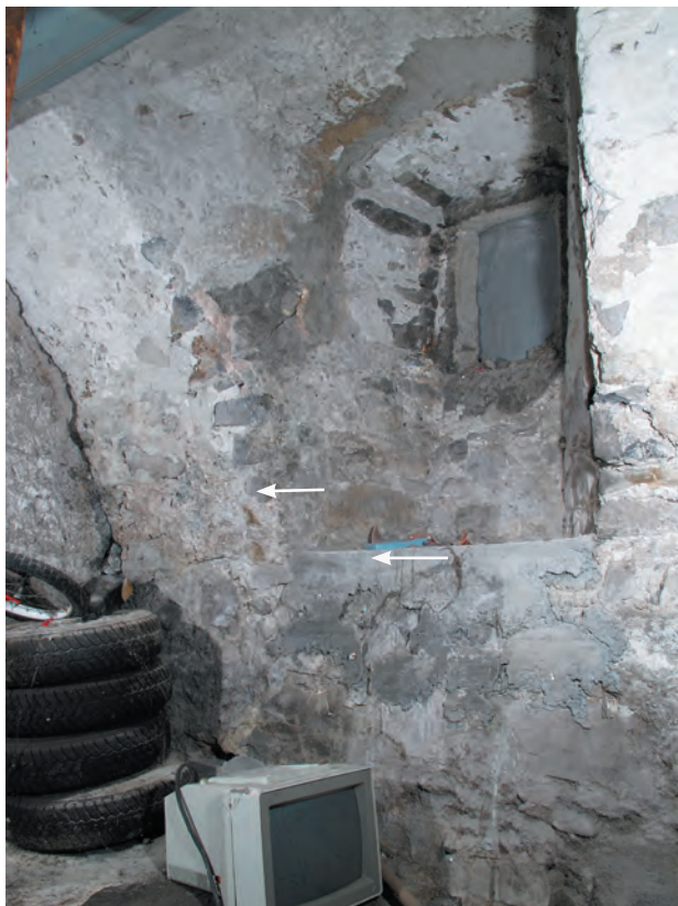
Fig. 26 Bâtiment n° 63/65, rez-de-chaussée, local 0.14. Cave voûtée ajoutée en phase 2.
