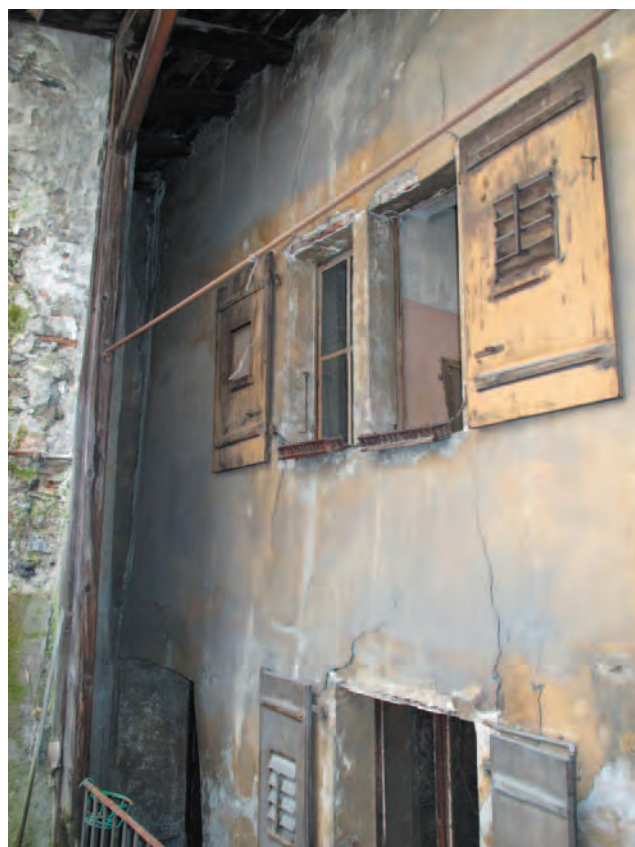
Fig. 10 Façade orientale du bâtiment n° 61, côté cour.
