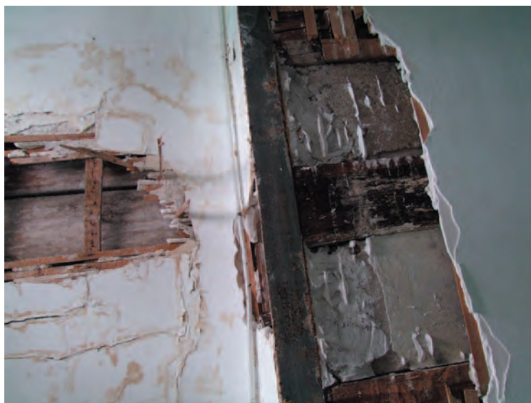
Fig. 29B Bâtiment n° 63/65, 1er étage, local 1.15. Le plafond de la partie « galerie » (à gauche) est constitué d'une chape de plâtre sur lattis. Dessous, des planches jointives non rainurées sont apparues. Le plafond « bas » (à droite) est constitué d'un solivage aux entrevous maçonnés.
