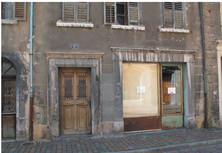
Fig. 6 Façade côté Grand-rue. Devanture du bâtiment n° 61. Porte au cadre chanfreiné, surmontée d'une corniche. Vitrine avec cadre en pierre caractérisé aux angles par des pierres taillées en pyramide.
