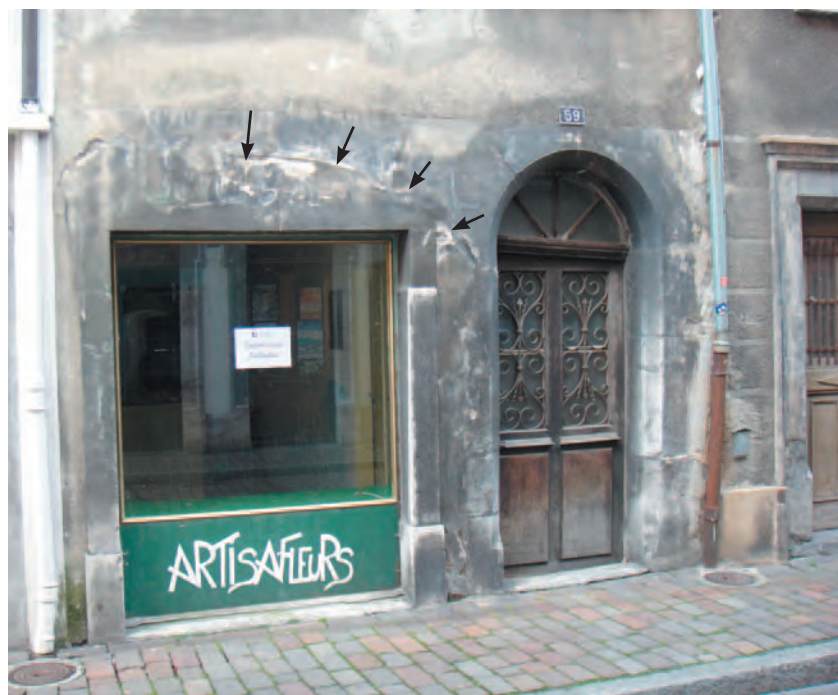
Fig. 5 A et B Façade côté Grand-rue. Devanture du bâtiment n° 59 (vue d'ensemble et détail). La porte au cadre chanfreiné était à l'origine flanquée d'une vitrine arquée (arc indiqué par des flèches au-dessus du linteau actuel). Les deux ouvertures étaient séparées par un poteau chanfreiné sur ses deux faces.
