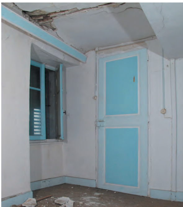
Fig. 29A Bâtiment n° 63/65, 1er étage, local 1.15. Annexe ajoutée en phase 2. A droite le local au plafond bas, à gauche l'ancienne galerie. La paroi manquante entre les deux parties a été remplacée par un din en métal. Vue vers l'est.
