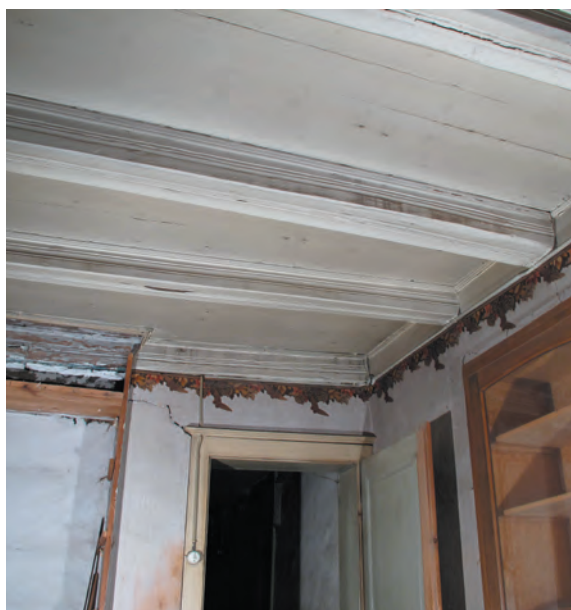
Fig. 18A et B Bâtiment n° 61, 1er étage, local 1.6. A droite: vue d'ensemble, avec le solivage mouluré et le plancher à carreaux. En haut: détail du plafond.
