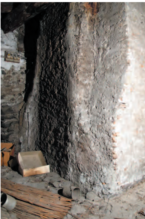
Fig. 16 Bâtiment n° 59, combles. Les deux cheminées remontant depuis les cuisines du 1er et du 2e étage.
