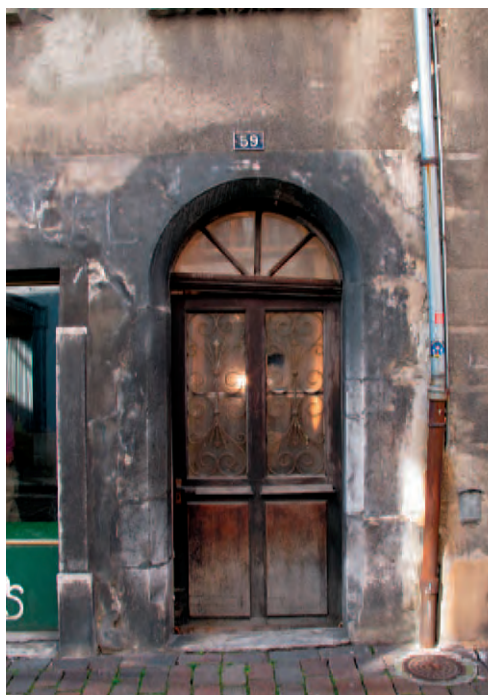
Fig. 5 A et B Façade côté Grand-rue. Devanture du bâtiment n° 59 (vue d'ensemble et détail). La porte au cadre chanfreiné était à l'origine flanquée d'une vitrine arquée (arc indiqué par des flèches au-dessus du linteau actuel). Les deux ouvertures étaient séparées par un poteau chanfreiné sur ses deux faces.
