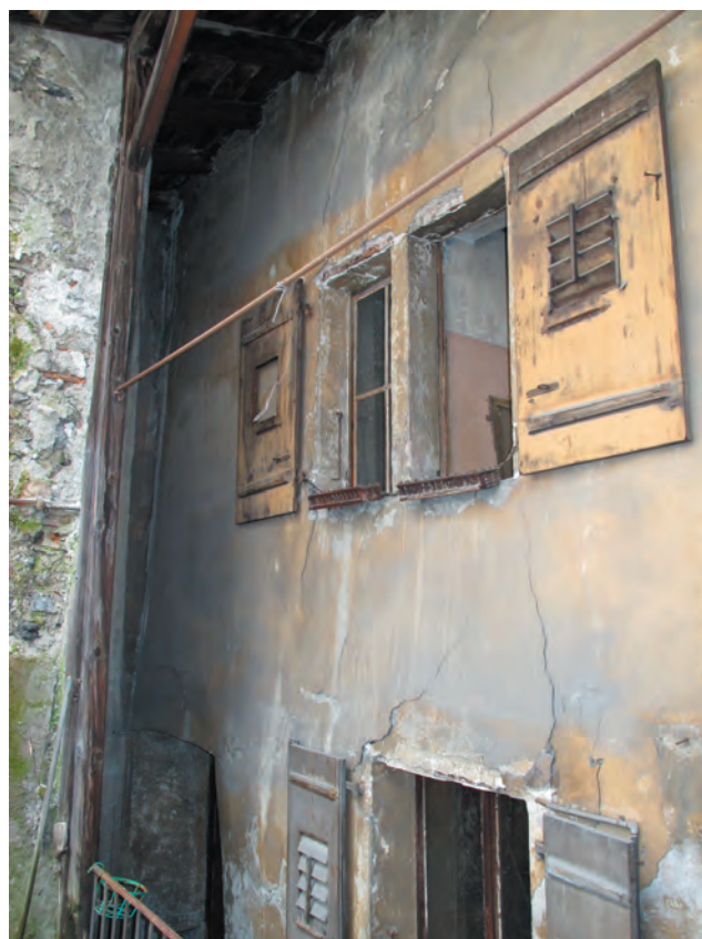
Fig. 10 Façade orientale du bâtiment n° 61, côté cour.
