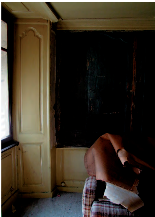
Fig. 28B Bâtiment n° 63/65, 1er étage, local 1.11S. Détail de l'angle sud-est. La partie inférieure de l'ancienne boiserie a été transformée en un lambris d'appuis de couleur blanc-crème par l'ajout d'une liste horizontale, la partie supérieure recouverte d'une tapisserie (plusieurs couches).
