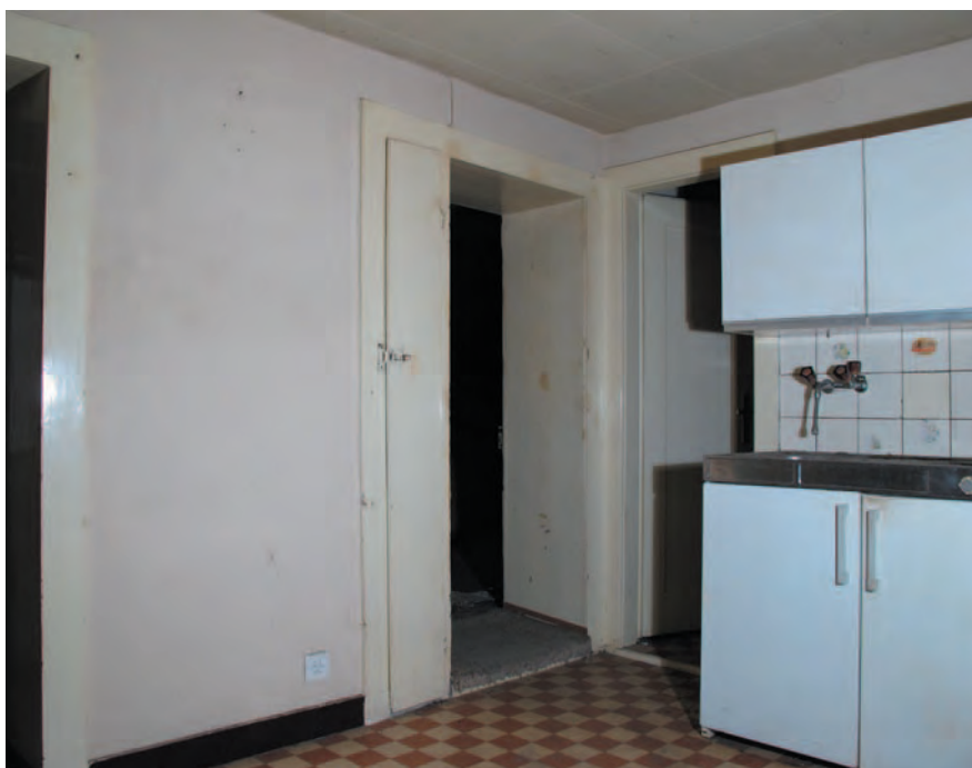
Fig. 27 A Bâtiment n° 63/65, 1er étage, local 1.12. Cuisine. A centre, l'ancienne porte donnant dans la pièce boisée. L'ouverture de la porte a été réduite probablement lors de la subdivision de la pièce en insérant une armoire étroite. Vue vers le sud-est.
