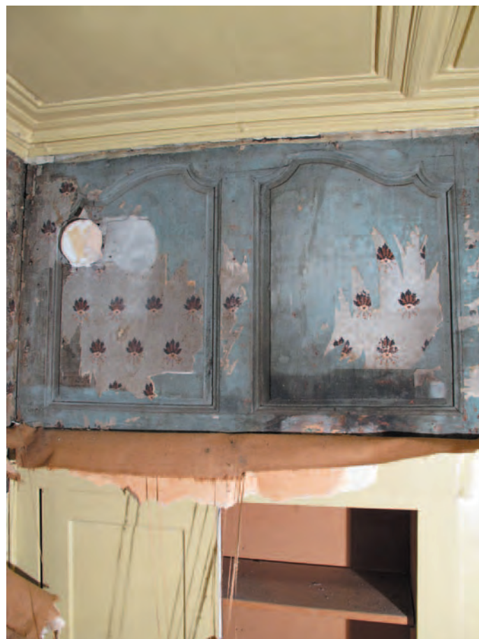
Fig. 28C Bâtiment n° 63/65, 1er étage, local 1.11S. Détail de la boiserie dans l'angle sud-ouest, au-dessus de l'emplacement de l'ancien poêle (remplacée par une armoire).
