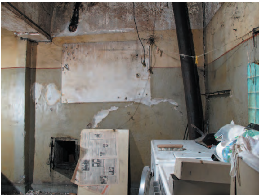
Fig. 19 Bâtiment n° 61, 1er étage, local 1.7. La cuisine avec sa grande hotte de cheminée. En bas à gauche, l'ouverture de chargement d'un ancien poêle.
