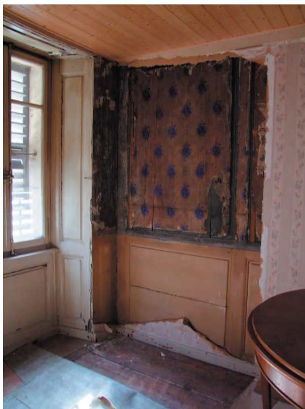
Fig. 30D Bâtiment n° 63/65, 1er étage, local 2.11S. Salle d'angle aux boiseries simples. L'ancienne boiserie est entièrement conservée. Elle a d'abord été transformée en lambris d'appuis de couleur blanc-crème avec tapisserie en papier, avant d'être recouverte par des panneaux de pavatex.
