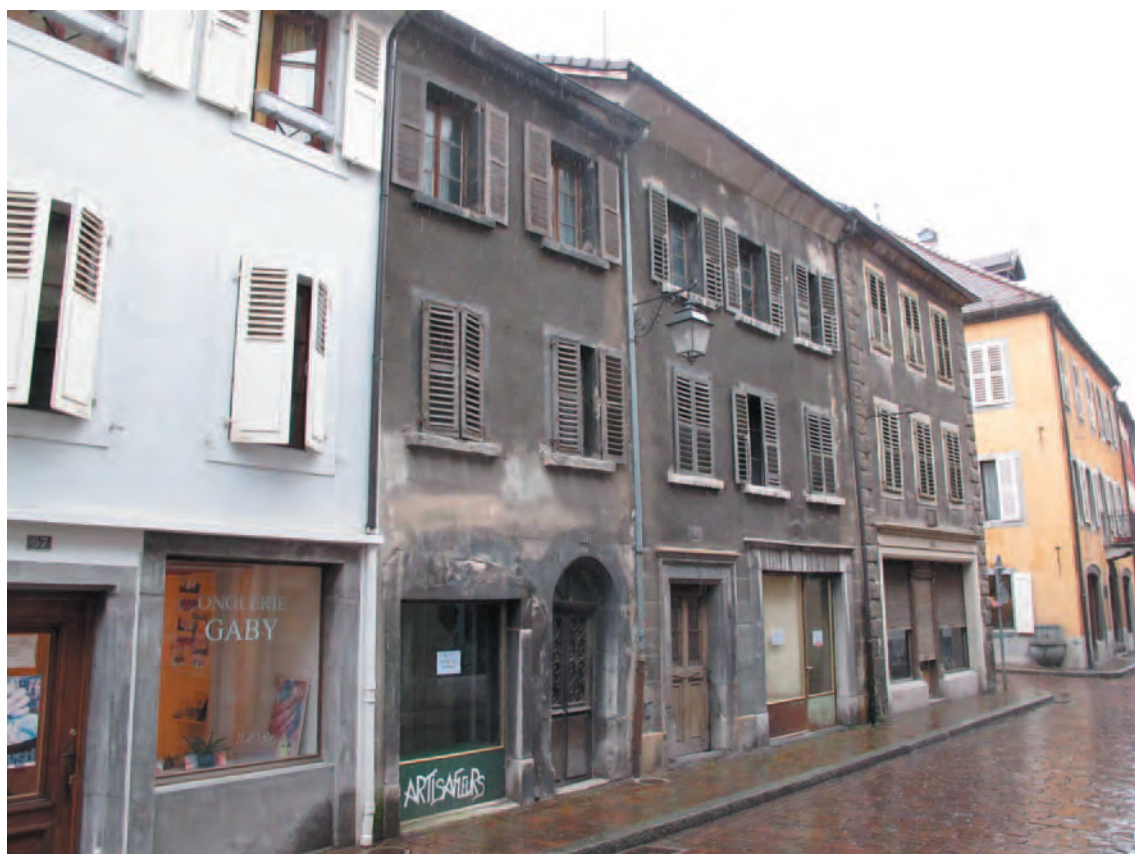
Fig. 4 Façade côté Grand-rue (face est) des bâtiments n° 59, 61, 63/65.
