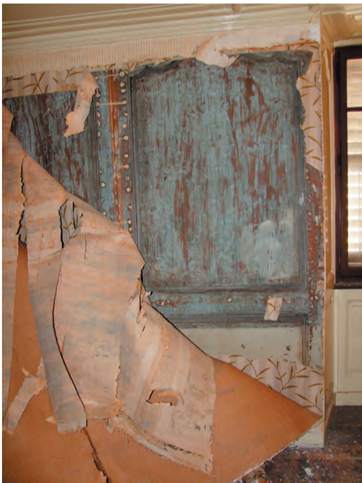
Fig. 28D Bâtiment n° 63/65, 1er étage, local 1.11N. Détail de la boiserie de la paroi nord. L'ancienne boiserie est entièrement conservée. Elle a d'abord été transformée en lambris d'appuis de couleur blanc-crème avant d'être recouverte par une toile de tapisserie (deux couches).
