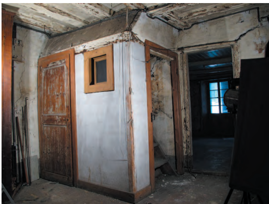
Fig. 23 Bâtiment n° 63/65, 2e étage, local 2.7. Atre de la cuisine (aujourd'hui transformée en cage d'escalier menant aux combles).
