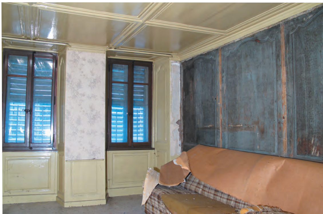
Fig. 28A Bâtiment n° 63/65, 1er étage, local 1.11S. Salle d'angle boisée, sous la moquette est conservé le plancher en lames larges. Vue vers le sud-est.
