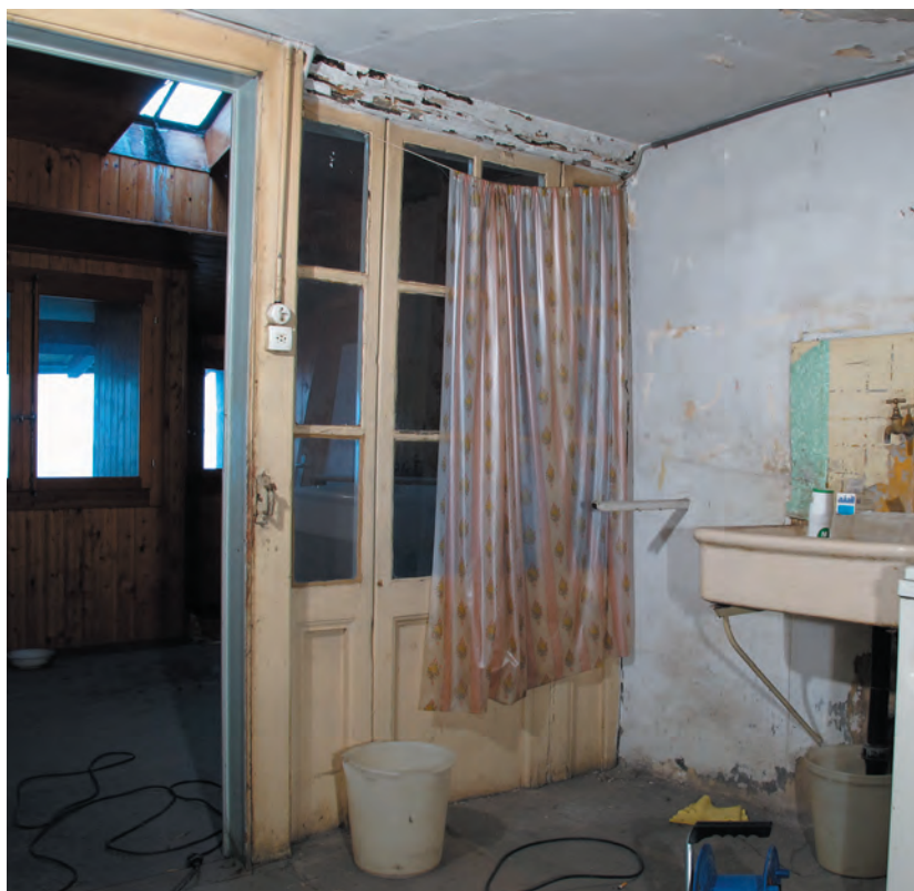
Fig. 14 Bâtiment n° 59, 2e étage, local 2.2. La paroi occidentale de la cuisine, une construction légère, coïncide ici avec l'emplacement de l'ancienne façade.
