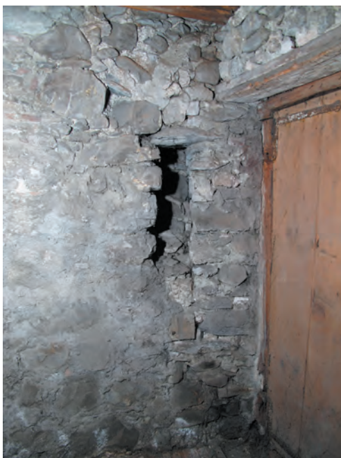
Fig. 11 Bâtiment n° 59, rez-de-chaussée, local 0.5. Meurtrière d'une ancienne façade.
