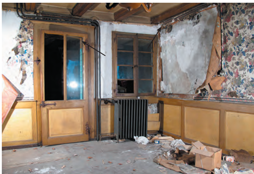
Fig. 20 Bâtiment n° 61, 1er étage, local 1.9. La pièce ajoutée en phase 2 est dotée d'un solivage mouluré et de boiseries à mi-hau- teur conservées sur deux parois.
