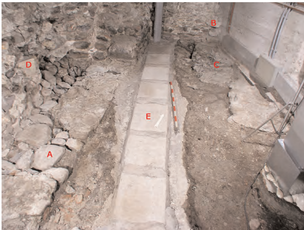
Fig. 10 Cave 4. Maçonneries affleurant au sol et conservées en élévation. A et B : maçonneries formant un angle droit crépi. C : maçonnerie parallèle au mur A, sous B. D : extrados de la voûte couvrant la partie plus récente de la cave 4, qui venait anciennement s'appuyer contre A. E : canal moderne. Vue vers le nord.
