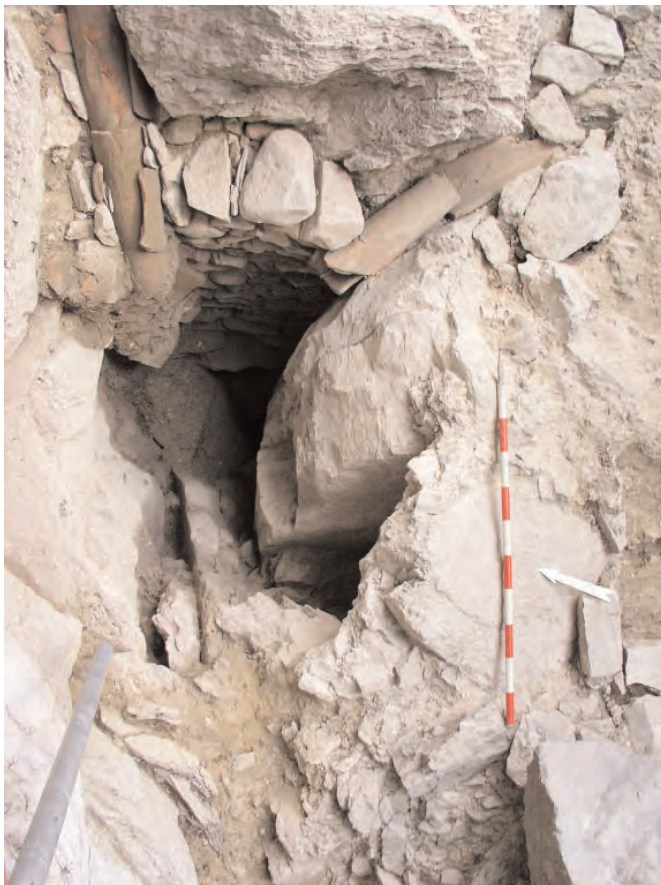
Fig. 7 Secteur au nord de la crypte occidentale. Puits perdu à l'extrémité des deux canalisations composées d'imbrices (St484). Le puits profite d'une faille naturelle entre le rocher (à gauche) et un bloc détaché de la falaise (en bas et à droite), le quatrième côté est fermé par un muret en pierres sèches (M606).
