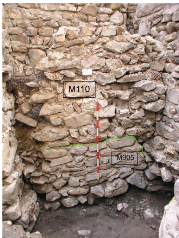
Fig. 30 Mur de terrasse M110 construit sur la maçonnerie plus ancienne M905, parement nord.
