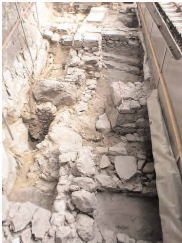
Fig. 5 Vue générale du secteur situé au nord de la crypte occidentale. Vue vers l'est.
