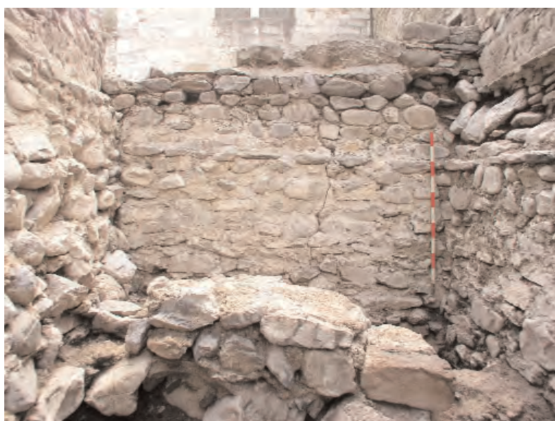
Fig. 27 Parements internes de la sacristie adossée au sud contre l'abside rouge II ; le ressaut horizontal est bien visible. Au premier plan, la maçonnerie arasée plus ancienne (M905). Vue vers l'est.
