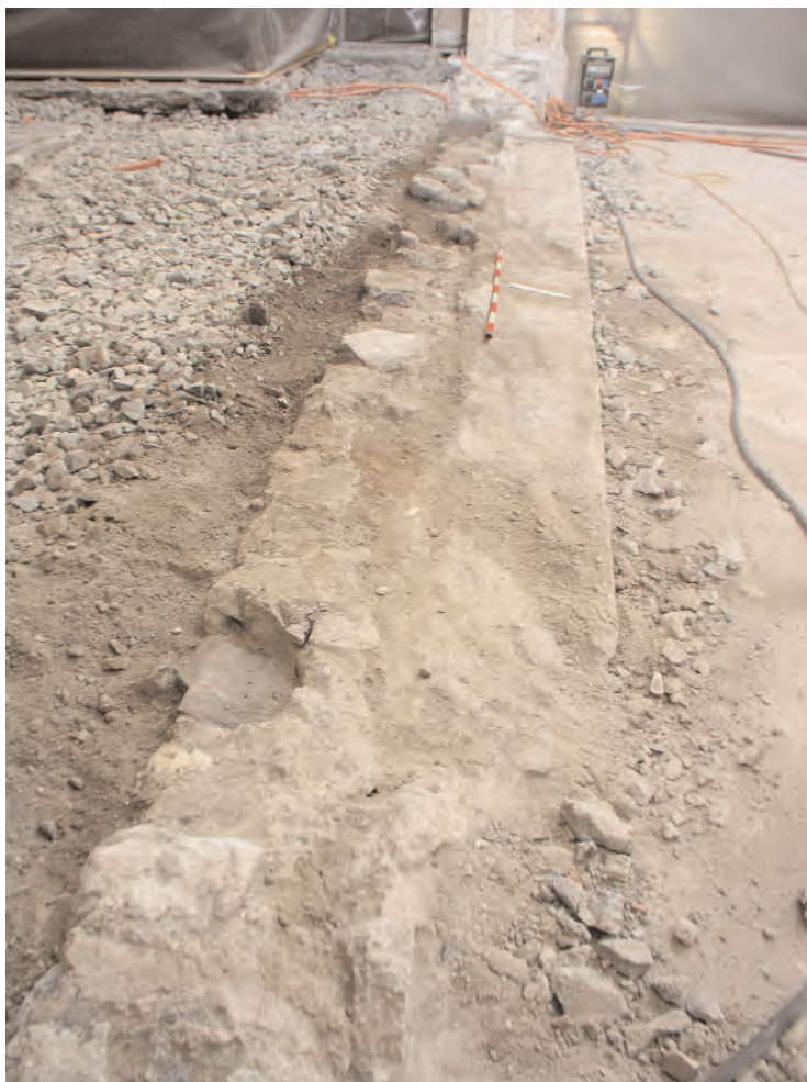
Fig. 11 Basilique actuelle. Fondation (M728) du chancel primitif ? Vue vers l'ouest.
