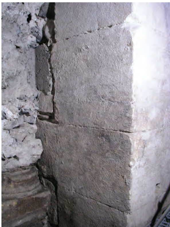
Fig. 7/4B. Martolet. Couloir des catacombes, portail occidental (piédroit sud, détail). Vue vers le sud-ouest.
