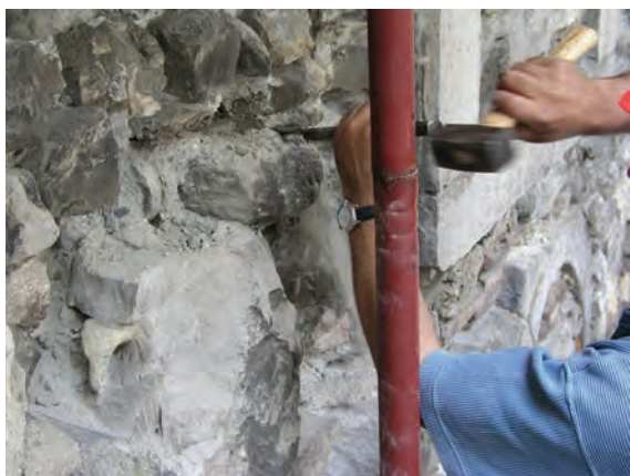
Fig. 1/21. Cour du Martolet, extraction d'un chapiteau scellé en remploi dans la façade sud de la cour.
