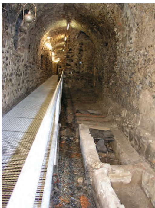
Fig. 1/29. Aile nord du bâtiment conventuel (couloir des catacombes), le passage provisoire établi en 2005.
