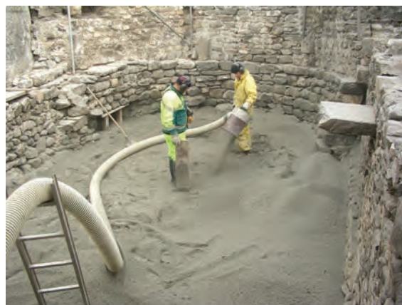
Fig. 1/24. Cour du Martolet, remblaiement des vestiges. 2005 Du gravier lavé (4/8) a été réparti sur le site à l'aide d'un « super-aspirateur » (entreprise Huber-Etter, Vuadens).
