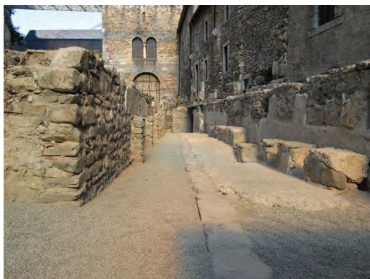
Fig. 5/7. Martolet. Couloir d'accès de l'église rouge. Vue vers l'intérieur.
