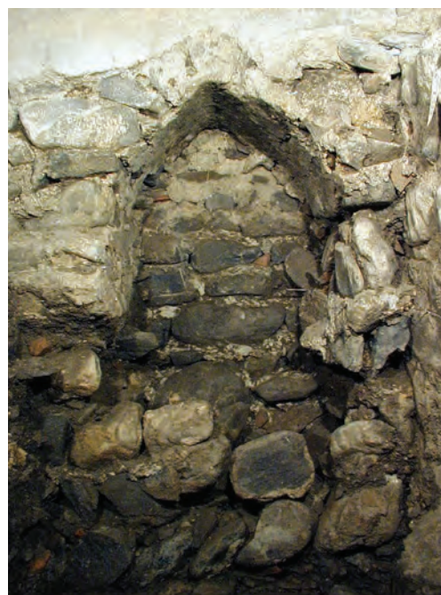
Fig. 5/24. Martolet. Couloir d'aè s de l'église rouge (faç s d du ouloir). Doublage de maçonnerie poé s r un voûtain (pour épargner une tombe ?) (Rampe IVB). Le voûtain coffré (M223) est posé sur une fondation o ntinue (M221). Derrière le vûtain, apparaît le mur (M225) o n s ruit lors du premier rallongement du couloir (Rampe IVA). Tera 2003
