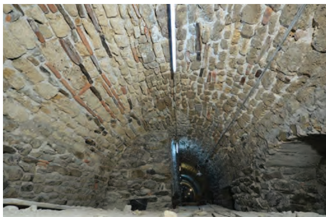
Fig. 1/39. Aile nord du bâtiment conventuel (couloir des catacombes), assainissement de la voûte. 2014
