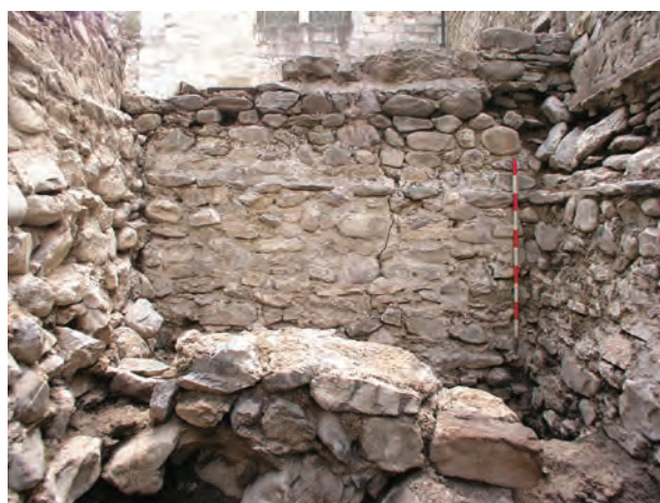
Fig. 5/20. Martolet. Sacristie s d, adoé e à la deux è me ab s de (rouge II). Parement intérieur du mur oriental, aç c re s ut horiè ntl. Au premier plan, la maç onnerie arasé e plus anc è nne M905. Vue è rs l'è s .
