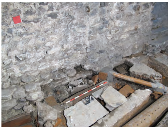
Fig. 5/39. Martolet. Aire funéraire en contrebas du couloir d'accès de la 2e église (phase rouge II) : le groupe de blocs maçonnés est antérieur au premier rallongement du couloir. Vue vers le nord.
