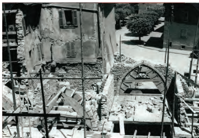
Fig. 10/21. St-Maurice . Les travaux de construction pour la nouvelle église (1947-1949). Au centre, l'arc du portail d'entrée. Vue vers l'est. (ASM)
