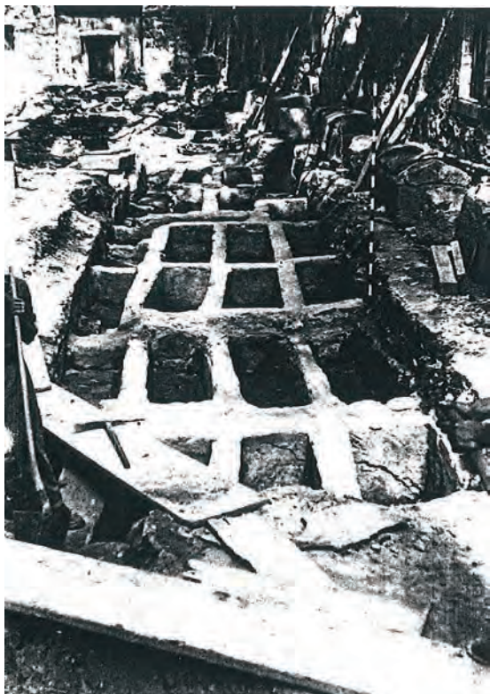
Fig. 7/28. Martolet. Fouille des tombes aménagées dans la nef, dans les remblais qui comblaient l'ancienne rampe d'accès. Vue vers l'est, vers 1947. (ACVS, fonds Blondel D23 – 1968/19, no1)
