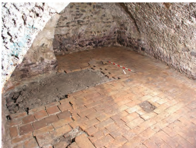
Fig. 1/27. Aile nord du bâtiment conventuel (cave 3), le revêtement en briques recouvre un pavage de boulets. 2004
