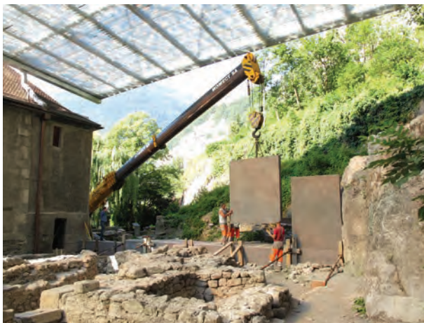
Fig. 1/43. Cour du Martolet, construction du mur occidental en éléments préfabriqués. 2010
