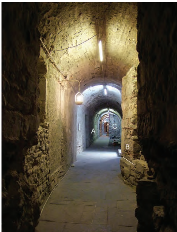
Fig. 8/5. Martolet. Couloir des galeries. Vue vers l'ouest.
