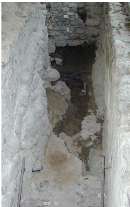
Fig. 5/13. Martolet. Vestibule de l'annexe occidentale. Vue vers le nord.
