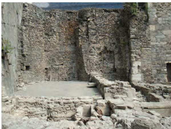
Fig. 1/36. Cour du Martolet, fermeture orientale du site, avant l'assainissement des maçonneries. 2011
