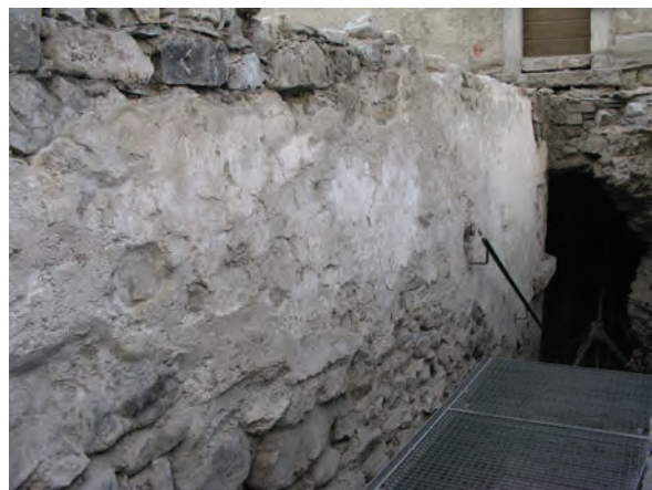
Fig. 7/16. Martolet. Quatrième église, détail de l'escalier monumental (paroi est). Vue vers le sud-est.
