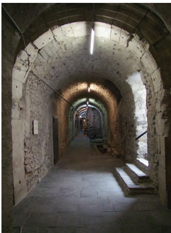
Fig. 7/3. Martolet. Couloir d'accès passant sous la nef de l'église, couloir des catacombes avec arc romain en remploi. Vue vers l'ouest.
