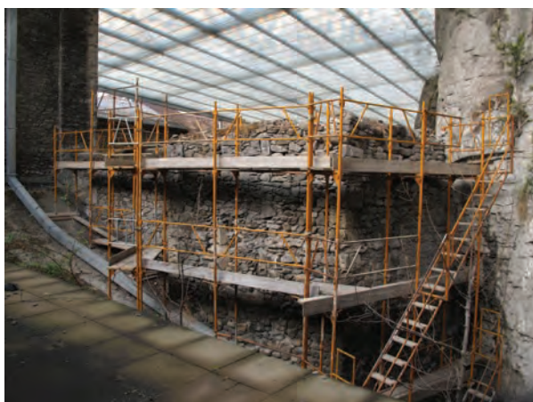
Fig. 1/46. Cour du Martolet, fermeture orientale du site (parement extérieur) lors des travaux d'assainissement. 2012
