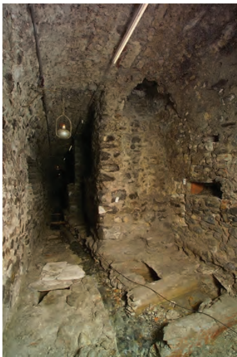
Fig. 8/25. Martolet. Couloir des arceaux soutenant les piliers des arcades sud du vaisseau central. Vue vers l'ouest.
