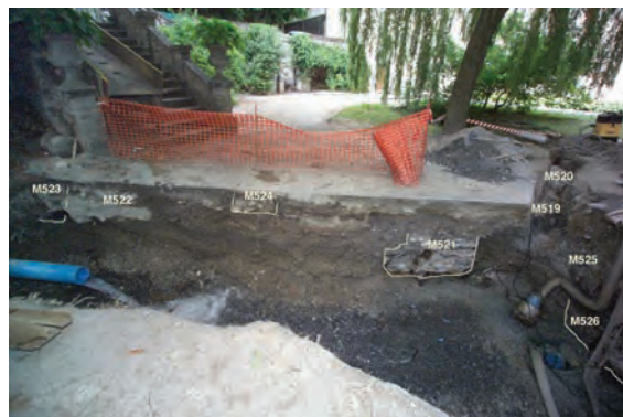
Fig. 1/26. Cour St-Joseph, excavation pour un forage de drainage. 2003
