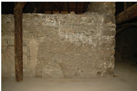
Fig. 1/25. Aile nord du bâtiment conventuel (combes), façade sud de la chapelle Félix. 2003
