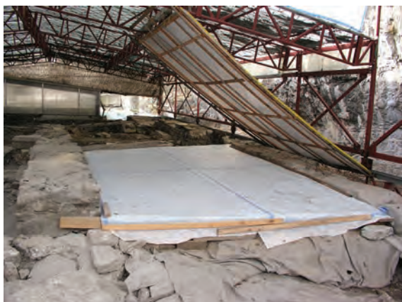
Fig. 1/23. Cour du Martolet, protection finale des vestiges du mausolée par un plancher revêtu d'une bâche en plastique. 2005
