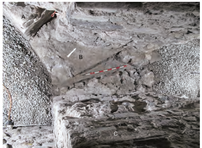
Fig. 8/7. Martolet. Extrémité orientale du couloir des galeries. A) contrefort du cœur (4e église) ; B) élargissement du contrefort (5e église) ; C) épaulement nord du chevet roman. Vue vers le nord-ouest.
