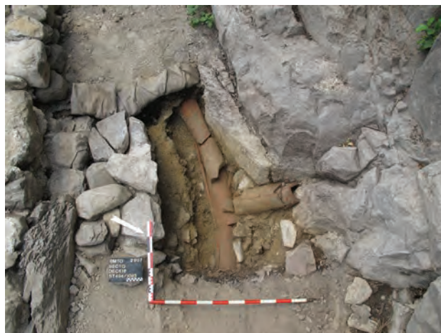
Fig. 7/24. Martolet. Détail de la canalisation. Jonction d'une conduite latérale capant l'eau ruisselant d'une faille du rocher. Vue face au sud-ouest.
