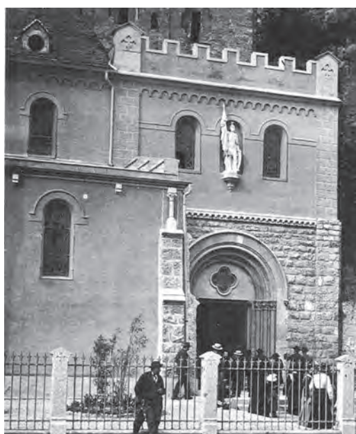
Fig. 10/17. St-Maurice . Le porche au pied du clocher construit en 1891. Vue vers l'ouest. (ASM)
