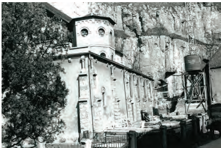
Fig. 10/16. St-Maurice. La façade orientale (vaisseau latéral) avant l'agrandissement de l'église au milieu du XXe siècle. Vue vers le nord-ouest. (ASM)
