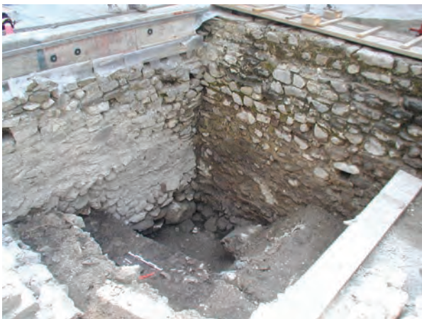
Fig. 5/15. Martolet. Epaulement sud des deux premières absides (façade intérieure).
