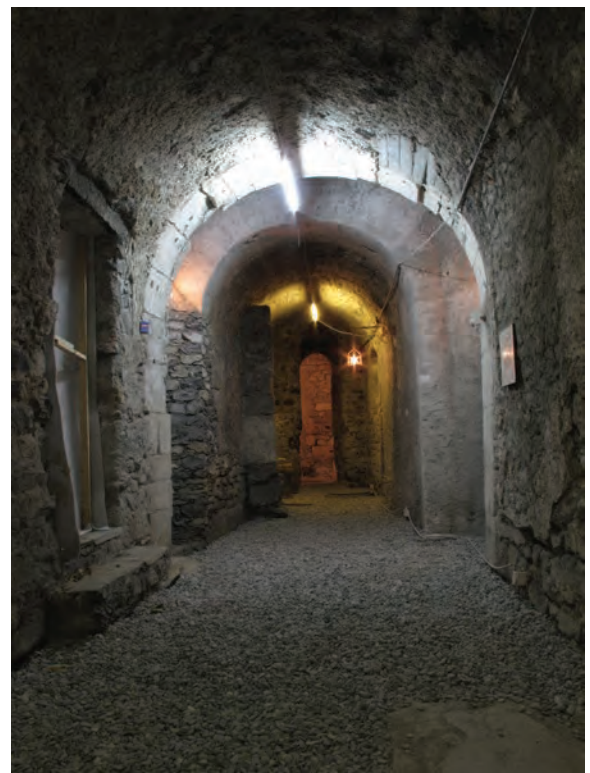
Fig. 8/6. Martolet. Couloir des galeries. Vue vers l'est.
