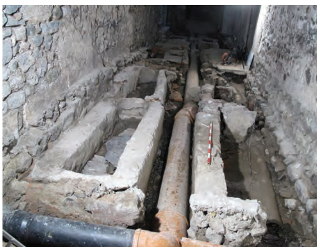
Fig. 1/34. Aile nord du bâtiment conventuel (couloir des catacombes), travaux de drainage. 2010
