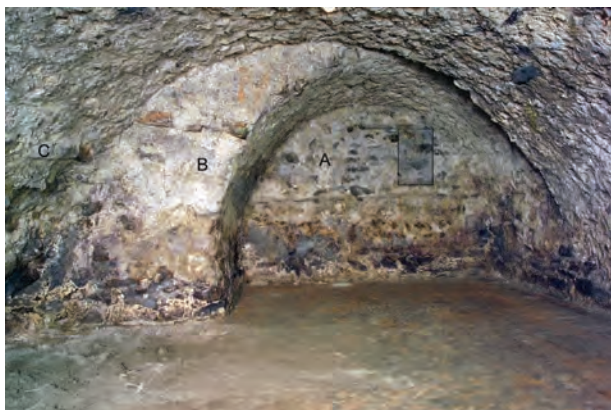
Fig. 8/22. Martolet. Caves du bâtiment conventuel bordant le sud du Martolet : situation de trois façades orientées
