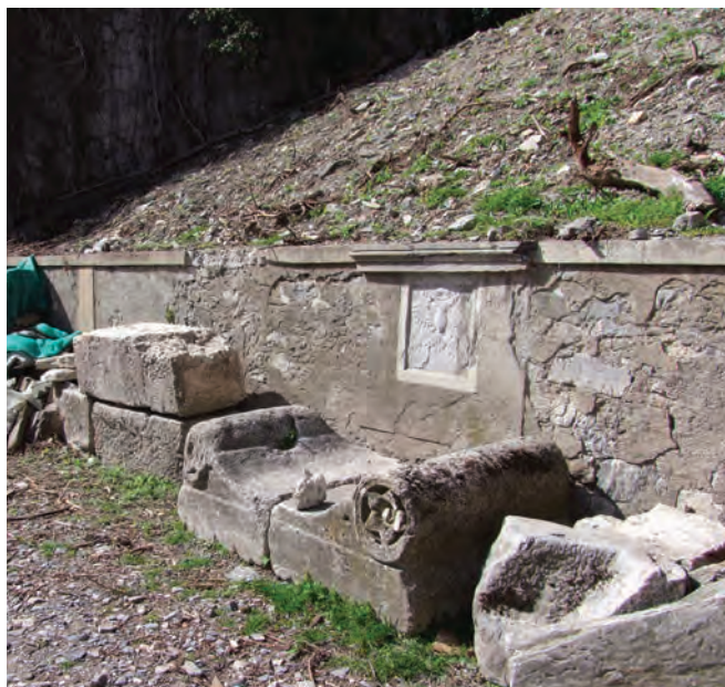
Fig. 9/22. Martolet. Mur auuel de la terrasse à l'ouest de la clôture du site. Sur l'écusson figure la date « 1697 » au-dessus d'un aigle.
