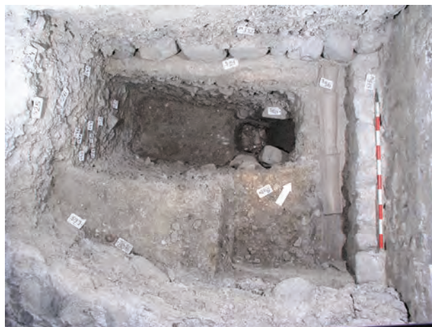
Fig. 7/20. Martolet. Quatrième église, espace à l'ouest de la cage d'escalier. Détail de la canalisation et des vestiges de sol en mortier. Vue face au nord-ouest.
