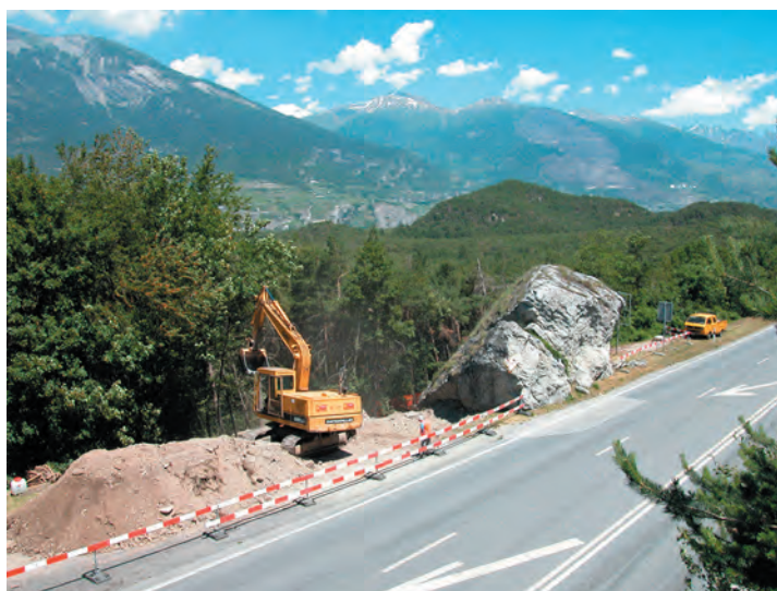
Le site du Mörderstein vu depuis le sud.
