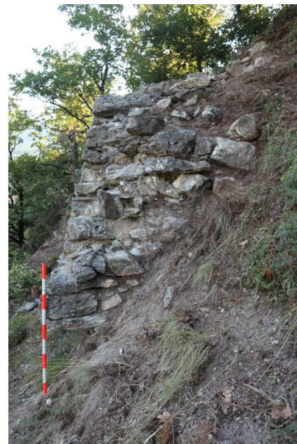
Fig. 33 – Principal élément du mur défensif au nord du troisième fossé. Il forme un angle (au niveau du jalon). Il s'agit du seul élément avec maçonnerie en talus. Cette disposition servait ici de renfort d'angle. Vue en direction du nord-est. 2020.
