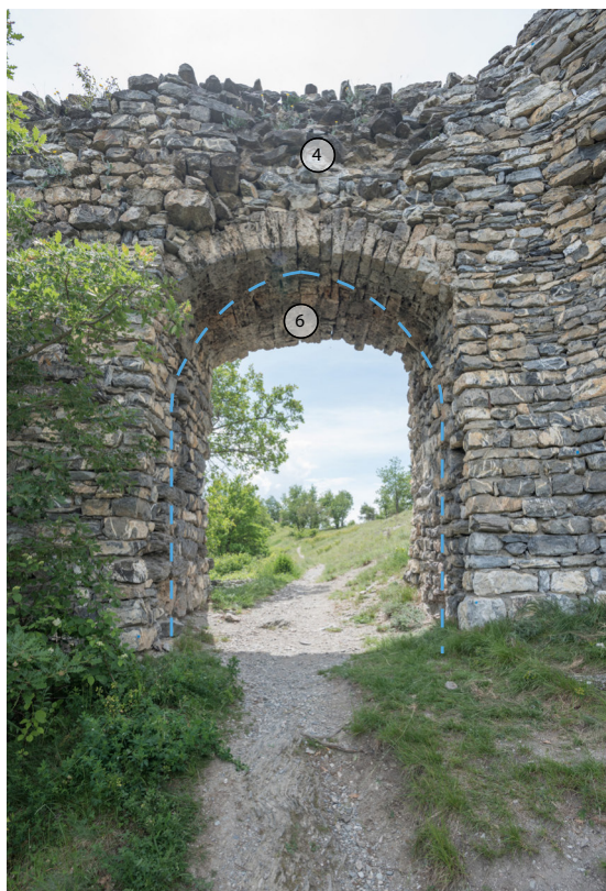
Fig. 18 – Porte d'entrée du bourg avec proposition de restitution du profil de l'arc disparu, d'après l'exemple de Tourbillon (supra, fig. 13). Vue vers le sud-ouest. 2018.
