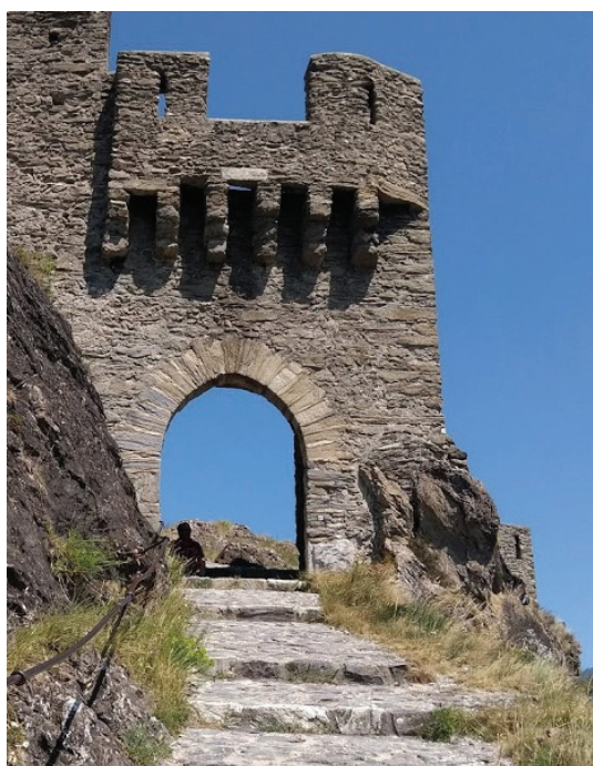
Fig. 13 – Vue de la porte avancée du château de Tourbillon, avec son arc brisé en léger ressaut par rapport à l'embrasure du passage. L'arc, qui forme un écran au profil différent de la voûte, servait de butée pour les battants de la porte. Ludovic Bender 2018.
