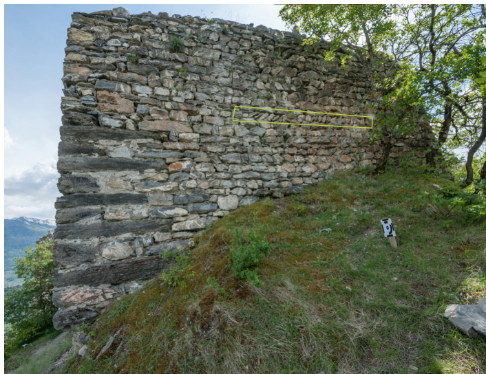
Fig. 17 – Mur bouclier (M4), segment nord, parement nord, en direction du sud. Quelques pierres de petits modules sont placées en épis pour compenser leur faible dimension. 2018.
