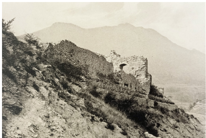
Fig. 22 – Vue générale vers le nord de la muraille méridionale du bourg (M11) au début du XX e siècle. La muraille a, depuis, beaucoup perdu de sa substance. Photographie d'après Solandieu 1912.
