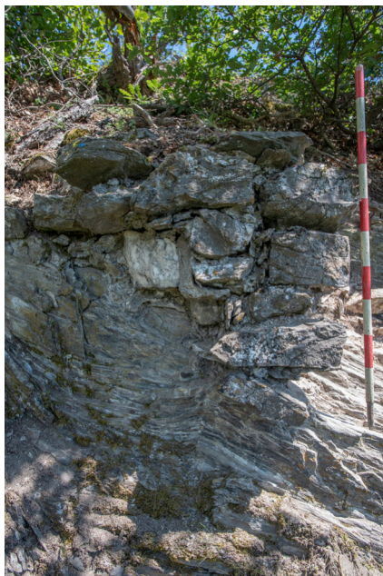
Fig. 32 – Vestige de mur défensif préservée sur 3 ou 4 assises (M170). Vue en direction du sud-est. 2020.
