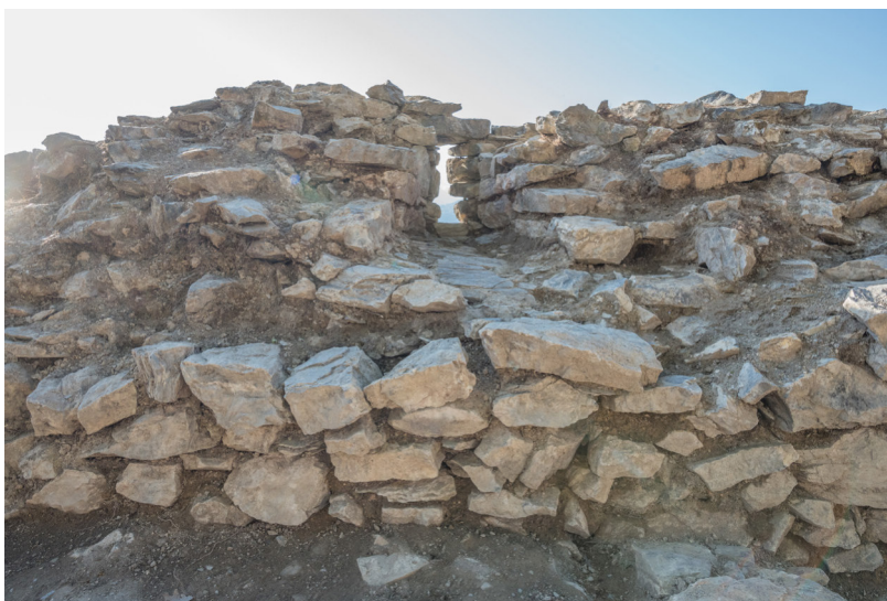
Fig. 23 – Vue de l'archère Str105 depuis le nord-ouest. Au premier plan, le niveau correspond à peu près au niveau ancien. 2019.
