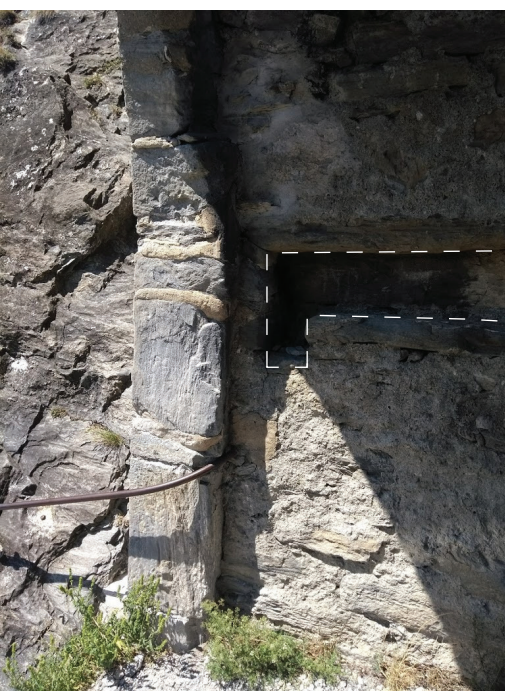
Fig. 14 – Vue du montant nord de la porte, avec l'arcature formant un léger ressaut par rapport au mur de l'embrasure. A noter encore l'encoche en équerre où l'on faisait coulisser une barre servant à bloquer les battants de la porte. Ludovic Bender 2018
