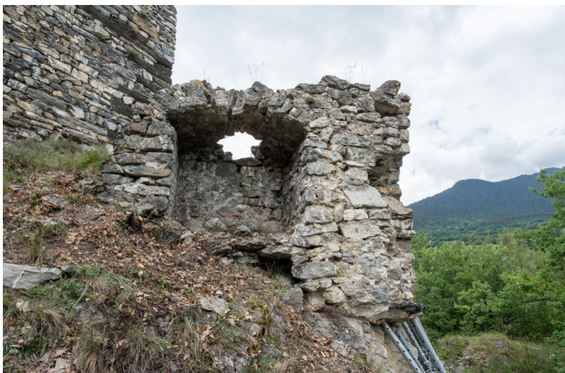
Fig. 11 – Vue du parement sud-est et de la niche du mur d'embrasure de la porte avancée que l'on appelle barbacane (M1), après coupe de la végétation envahissante. 2018.
