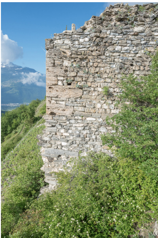
Fig. 16 – Angle nord-est de la tête du mur bouclier, avec sa chaîne d'angle en tufs finement taillés et ajustés. 2018.
