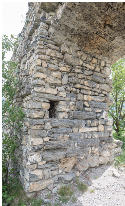
Fig. 19 – Embrasure de la porte d'entrée du bourg, mur sud-est. Le trou de logement de la barre de verrouillage est d'origine, mais l'embouchure a été entièrement refaite au ciment dans les années 1990, en même temps qu'une partie du parement. 2018.
