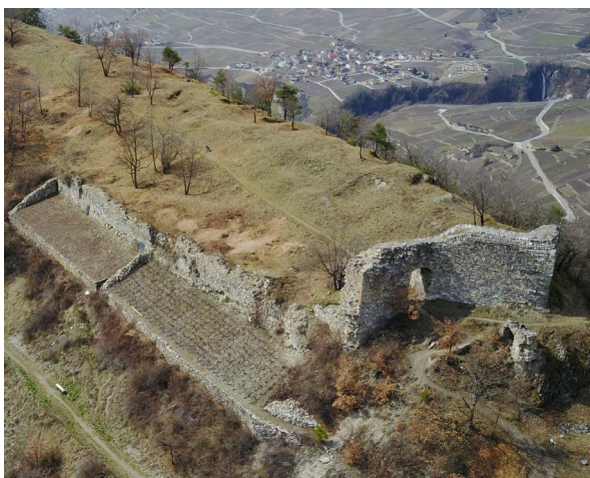
Fig. 21 – Vue générale et aérienne, vers le nord, de la muraille méridionale du bourg, dite « courtine sud », avant les restaurations (M11). Archeotech 2017.
