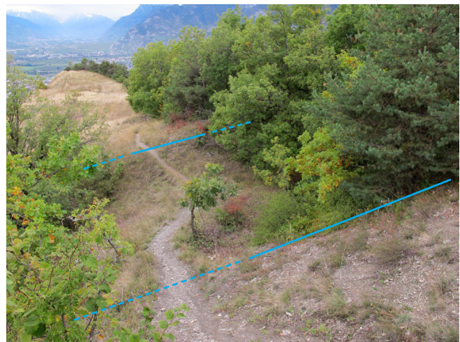
Fig. 6 – Fossé occidental (Fossé4) séparant le château épiscopal (Secteur5) des jardins. Il est partiellement comblé et encombré de végétation, mais encore parfaitement visible. A l'arrière-plan se développe le plateau des jardins de l'évêque (Secteur6). 2014.
