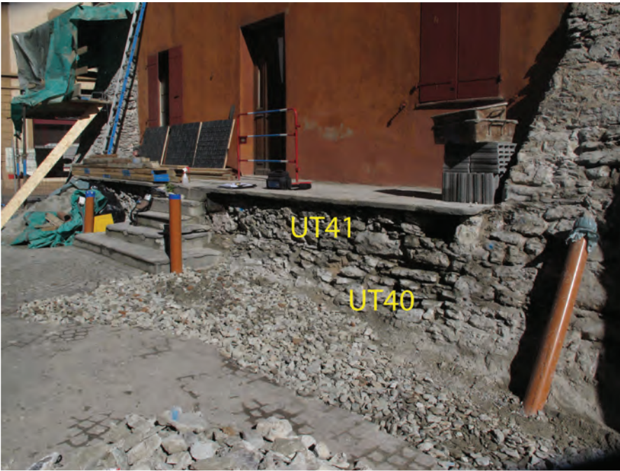
Fig. 18 Sierre, Château des vidomnes. Façade ouest, estrade. Le glacis a été démonté dans la partie centrale pour permettre l'ouverture de trois anciennes fenêtres mises au jour sous le crépi.
