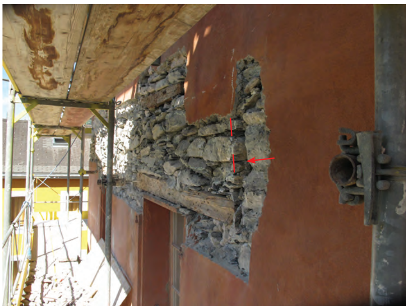
Fig. 22 Sierre, Château des vidomnes. Façade sud, 1ère phase du bâtiment. Piédroit du deuxième redent du pignon sud (côté est).
