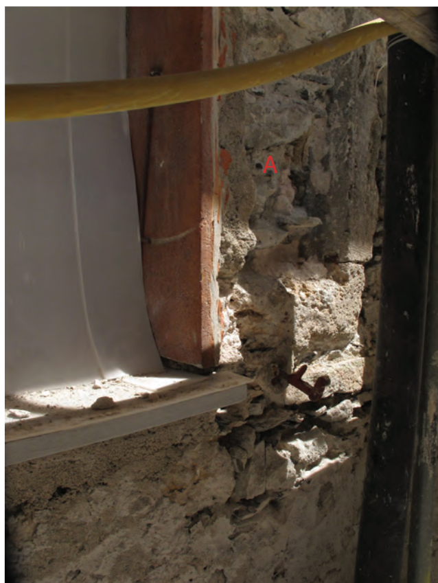
Fig. 31 Sierre, Château des vidomnes. Façade ouest, 3e phase du bâtiment. Fenêtre du rez-de-chaussée percée dans le mur, après le démontage d'une partie du socle. A: Ouverture avec cadre en blocs de tuf chanfreinés.
