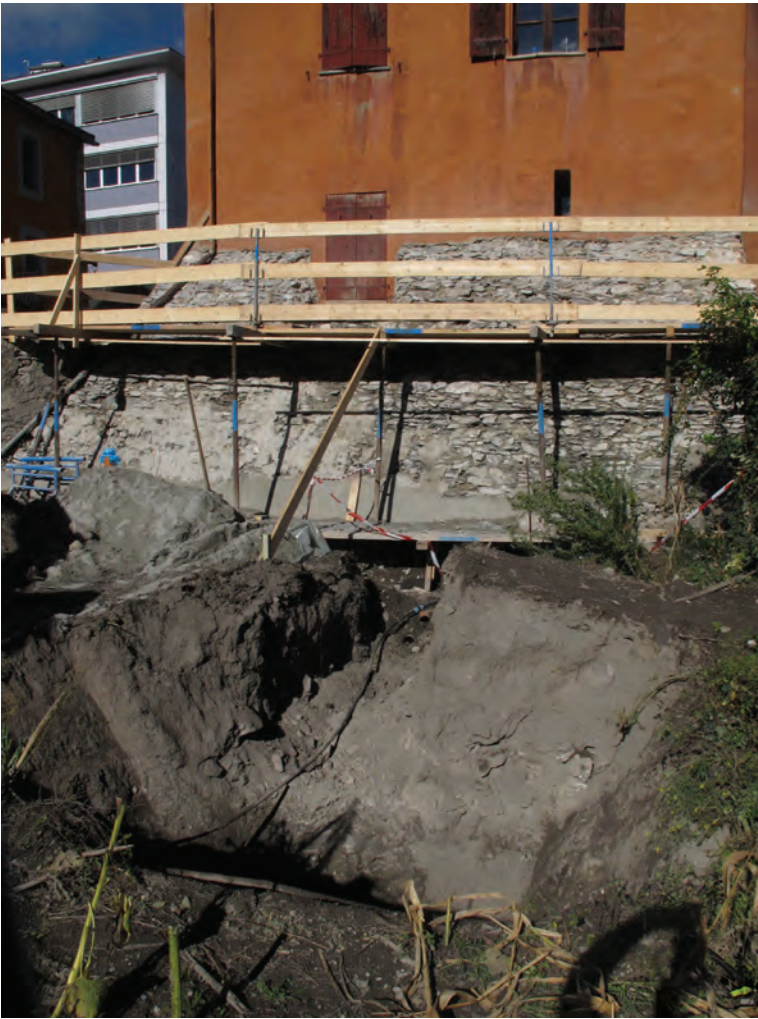
Fig. 7 Sierre, Château des vidomnes. Jardin sud, tranchée pour le puits perdu, vu vers le nord. Le profil de terrain dans la tranchée (au premier plan) comprend à son sommet un épaisse couche de terre fine et humique ; un remblai rapporté pour surélever le jardin.
