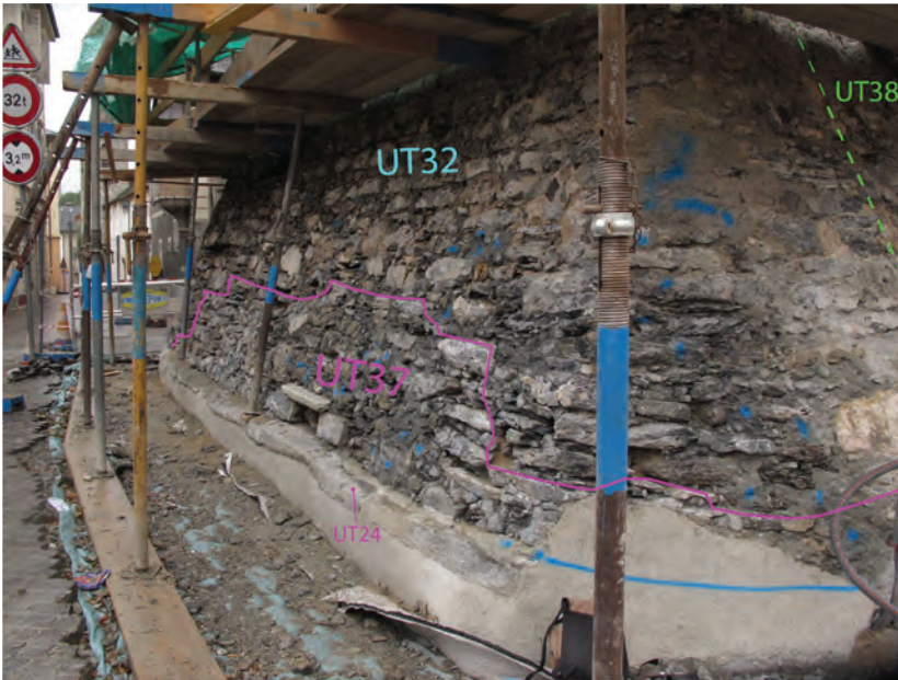
Fig. 9 Sierre, Château des vidomnes. Glacis de la façade nord. Vue vers l'est.
