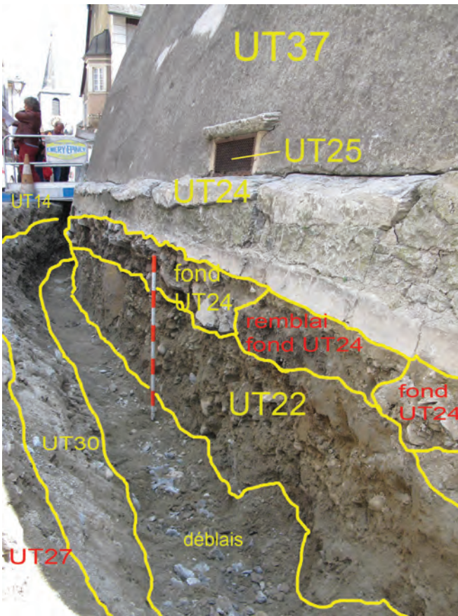
Fig. 1 Sierre, Château des vidomnes. Tranchée de drainage au pied de la façade nord. Le glacis (UT37) et son socle (UT24) sont fondés dans le terrain naturel (UT22) affleurant à 30cm sous la rue actuelle.
