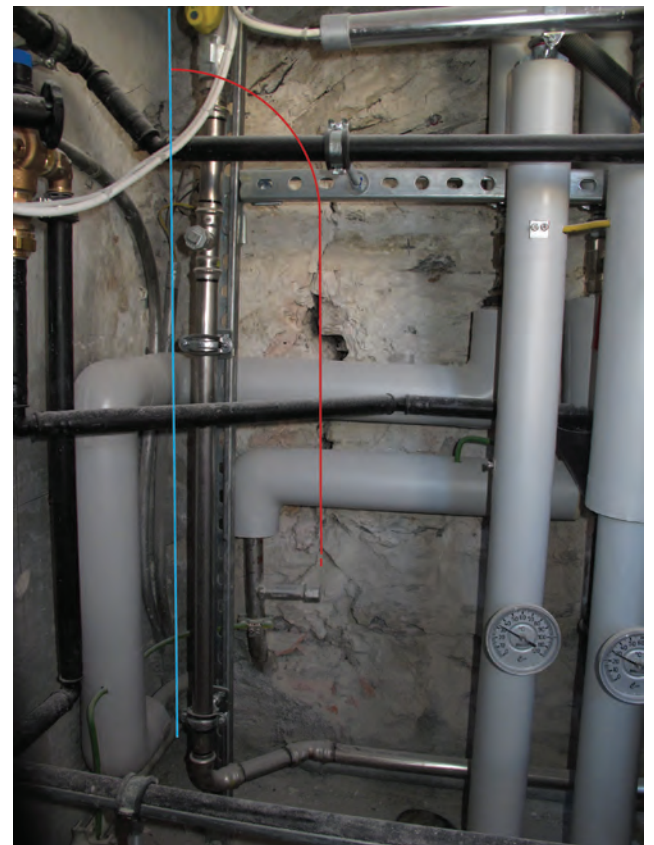
Fig. 13 Sierre, Château des vidomnes. Façade est de la tour (1er étage). Vestige d'une ancienne fenêtre arquée (en rouge). La paroi de la tourelle des latrines (à gauche) s'appuie contre le cadre et le bouchon de cette ouverture qui pourrait être contemporaine de la première phase de la tour (à vérifier).
