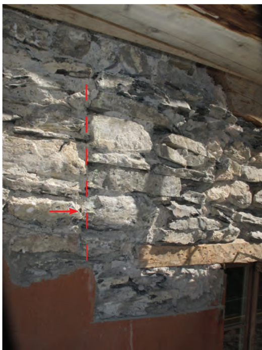
Fig. 21 Sierre, Château des vidomnes. Façade sud, 1ère phase du bâtiment. Piédroit du deuxième redent du pignon sud (côté ouest).
