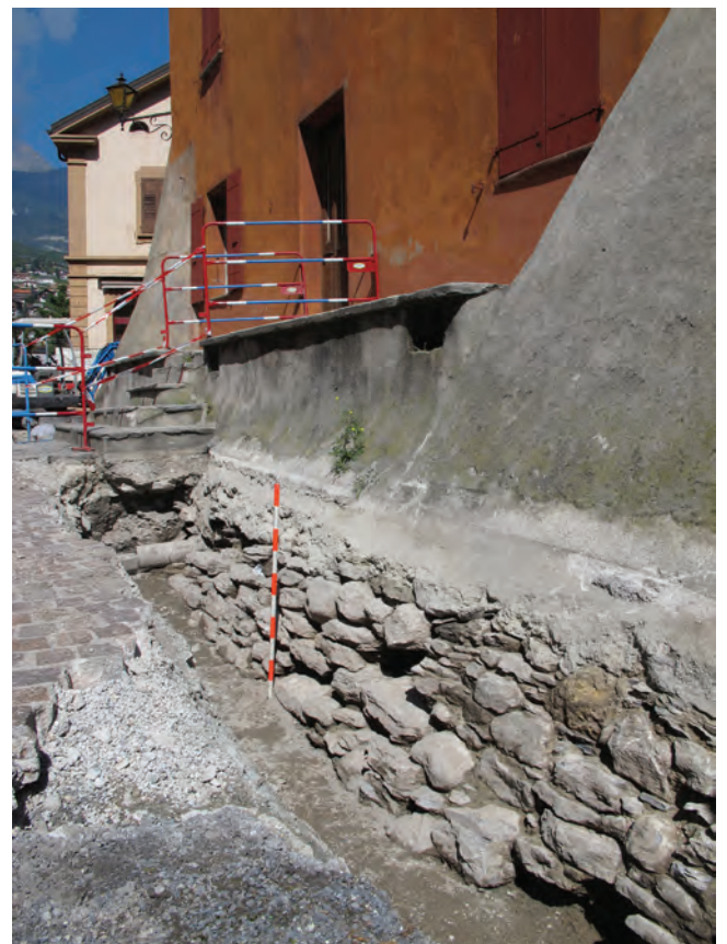
Fig. 2 Sierre, Château des vidomnes. Tranchée de drainage ouest. La fondation du glacis n'a pas été atteinte dans la tranchée.
