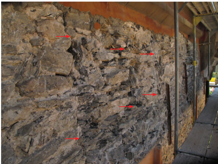
Fig. 25 Sierre, Château des vidomnes. Façade ouest, 2e phase du bâtiment. Les trois corbeaux arrachés caractérisant la base d'une bretèche au milieu de la façade. Les flèches indiquent les deux extrémités des corbeaux.
