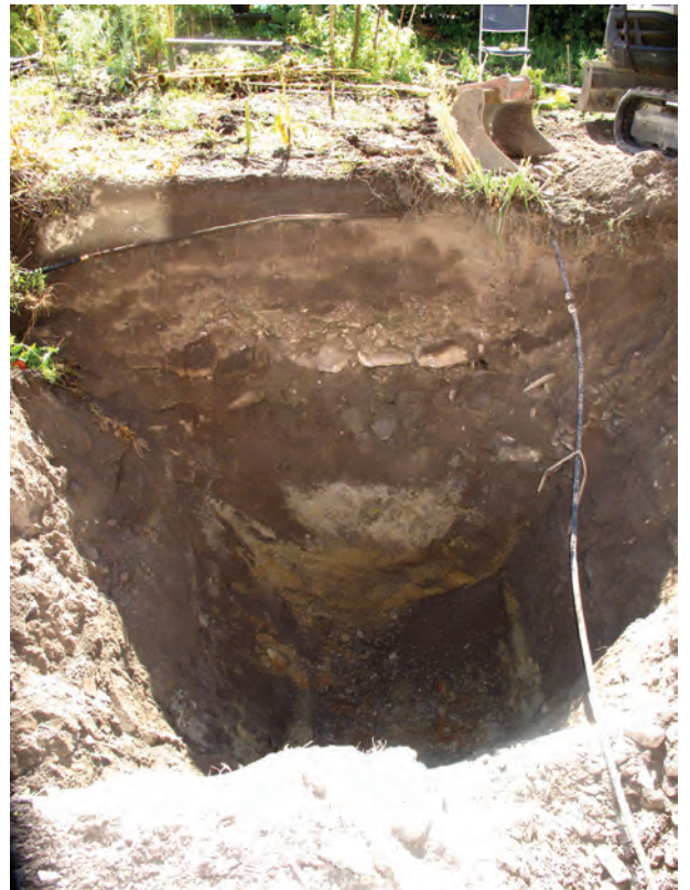
Fig. 8 Sierre, Château des vidomnes. Jardin sud, excavation pour l'aménagement d'un puits perdu, face sud.
