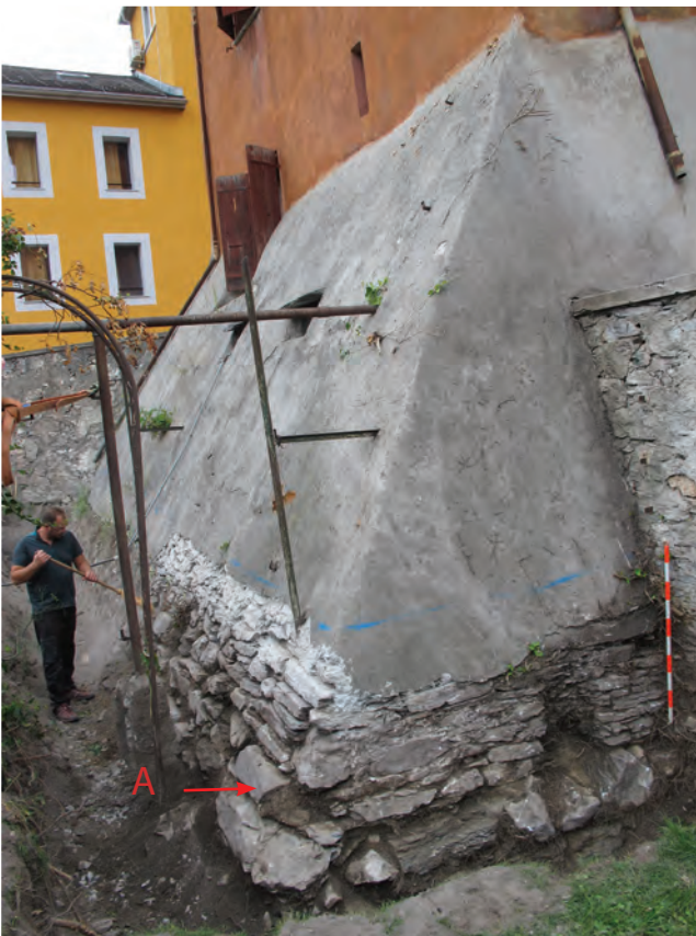
Fig. 6 Sierre, Château des vidomnes. Glacis de la façade sud (angle sud-est). Le ressaut de fondation (A) indique le niveau de construction et d'utilisation de l'espace au sud du glacis. Pour le jardin actuel, le niveau a été surélevé de 60 cm environ.
