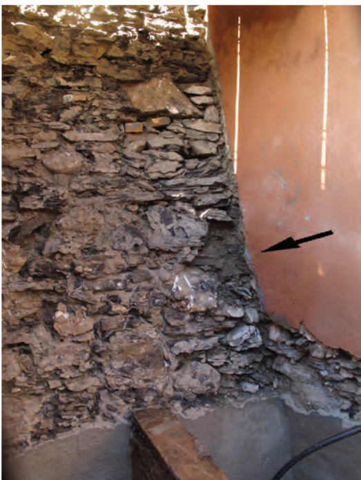
Fig. 11 Sierre, Château des vidomnes. Jonction entre le glacis de la façade orientale (UT40) et la tourelle des latrines (UT7). La maçonnerie de la tourelle (designé par la flèche) semble s'appuyer contre le parement du glacis. En fondation, le caractère des deux maçonneries était similaire; toutes deux pourraient avoir été construites en même temps. Le décrépiage trop partiel de la façade n'a pas permis de clarifier la chronologie entre les deux éléments.
