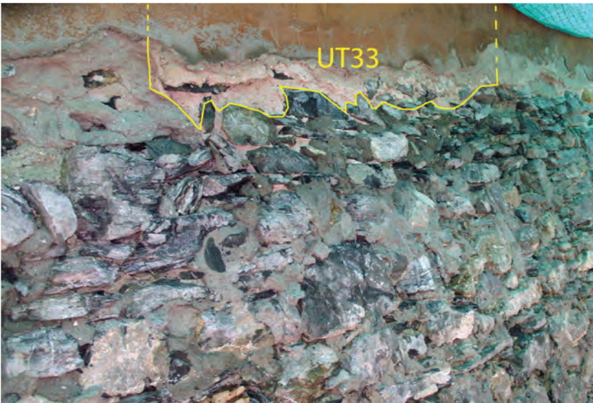
Fig. 15 Sierre, Château des vidomnes. Façade nord, limite supérieure du glacis, vue vers le sud-ouest. Restes de mortier à l'anhydrite rosâtre repérés sur une longueur de 1.45 m, à la limite de la découpe du crépi actuel. Situé exactement au milieu de la façade, il pourrait lier les pierres d'une fenêtre (UT33) percée après la construction du glacis (à vérifier).
