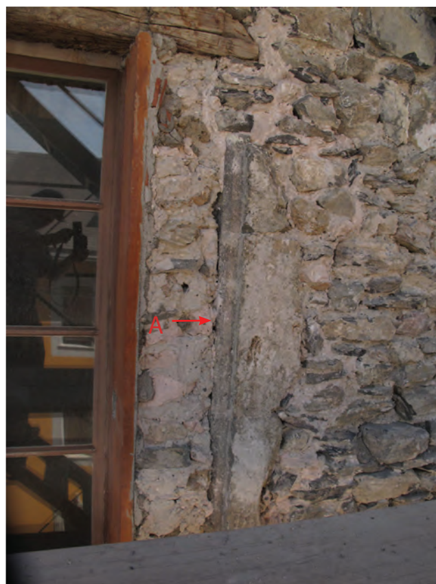
Fig. 32 Sierre, Château des vidomnes. Façade ouest, 3e phase. Fenêtre du 2e étage percée dans le mur. A: Montant constitué d'une pierre de tuf chanfreinée.
