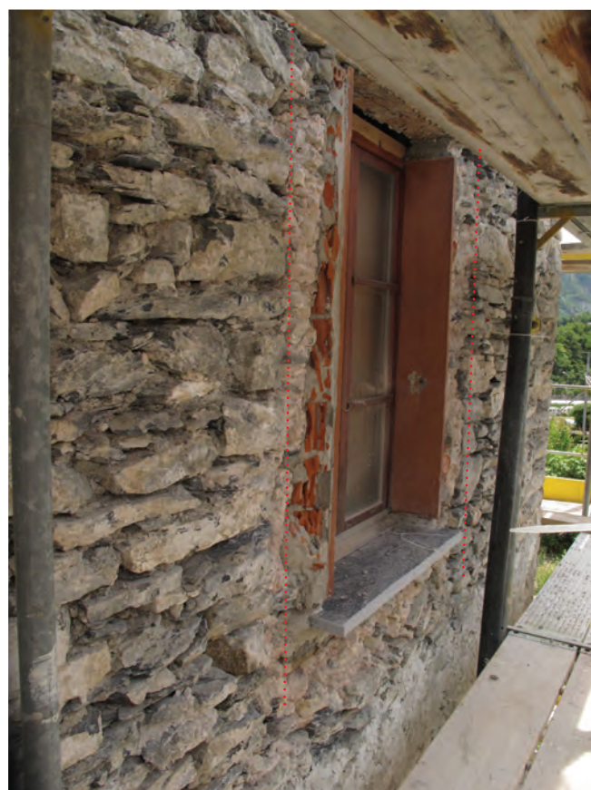
Fig. 24 Sierre, Château des vidomnes. Façade ouest, 1ère phase du bâtiment. Fenêtre à meneau central ou porte du 1er étage (UT64), d'origine dans le mur. La fenêtre actuelle s'insère entre les deux anciens montants.
