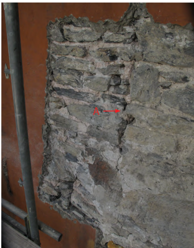
Fig. 29 Sierre, Château des vidomnes. Façade est, 2e phase du bâtiment. A: Piédroit d'une porte (de latrines?) aménagée dès l'origine au niveau du 3e étage.
