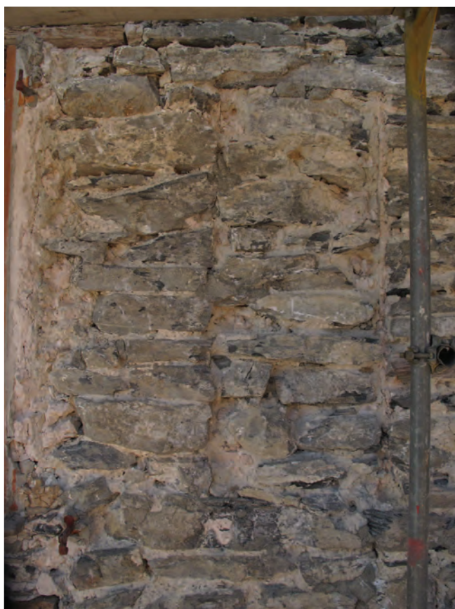
Fig. 27 Sierre, Château des vidomnes. Façade ouest, 2e phase du bâtiment. Fenêtres d'origine du 3e étage: fenêtre nord entièrement conservée.
