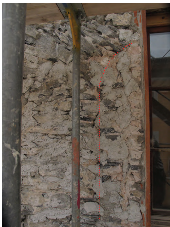
Fig. 23 Sierre, Château des vidomnes. Façade ouest, 1ère phase du bâtiment. Moitié nord d'une fenêtre du 1er étage (UT63), d'origine dans le mur.
