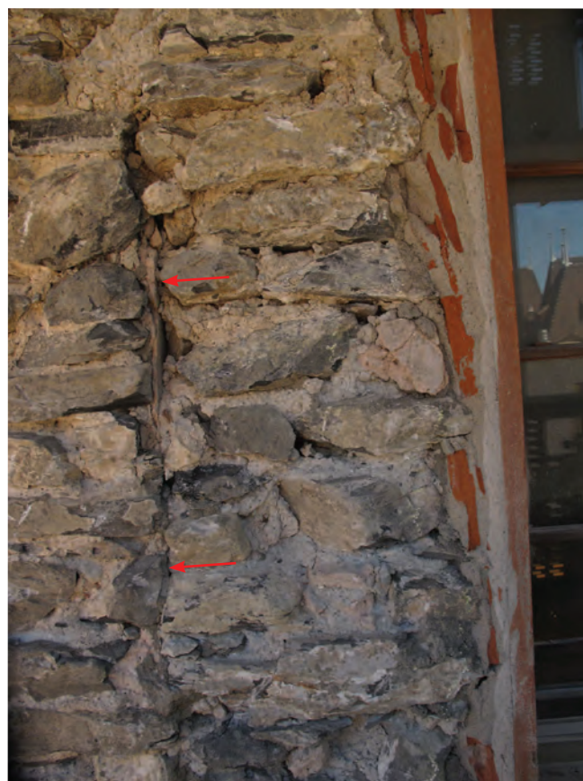
Fig. 28 Sierre, Château des vidomnes. Façade ouest, 2e phase du bâtiment. Fenêtres d'origine du 3e étage: ouverture sud perturbée par la fenêtre actuelle.
