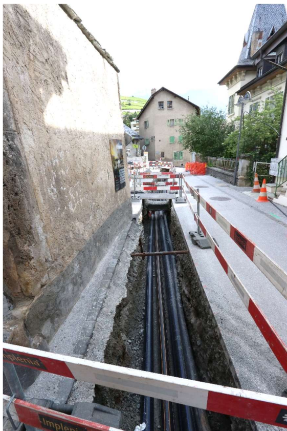
FIGURE 6 : vue générale de l'étape 2 (à la hauteur de la porte cochère d'accès au château de Villa), vue en direction du nord-est.
