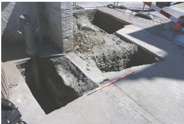
FIGURE 4 : vue générale de l'étape 1 (sondage au premier plan) avec les débuts de l'étape 2 au second plan, vue en direction de l'est.
