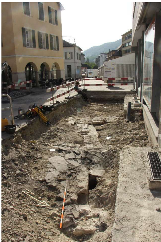
Figure 18 : étape 15, PLN25, vue générale des vestiges, en direction du sud-ouest.
