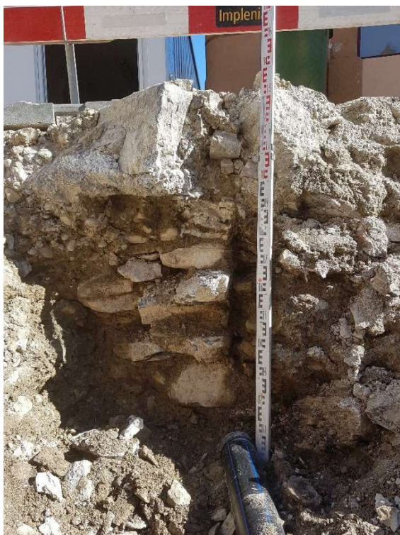
FIGURE 13: étape 12, STG19, le mur de cave UT 137 et la reprise UT 138, vue nord.
