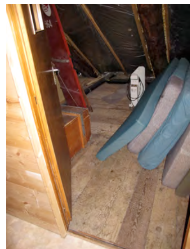
IMG_1028.JPG Dachstock, Treppenhaus: nicht isolierter Dachbereich
