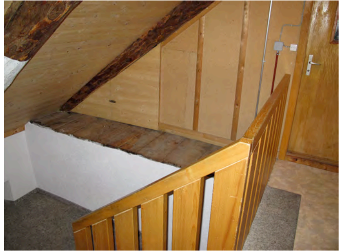
IMG_1029.JPG Dachstock, Treppenhaus
