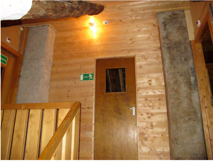
IMG_1021.JPG Dachstock, Treppenhaus
