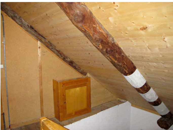
IMG_1024.JPG Dachstock, Treppenhaus
