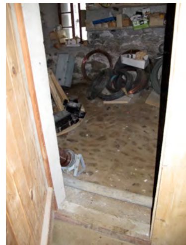
IMG_1147.JPG Keller, Ostteil: Nordteil mit originaler Stallpflasterung
