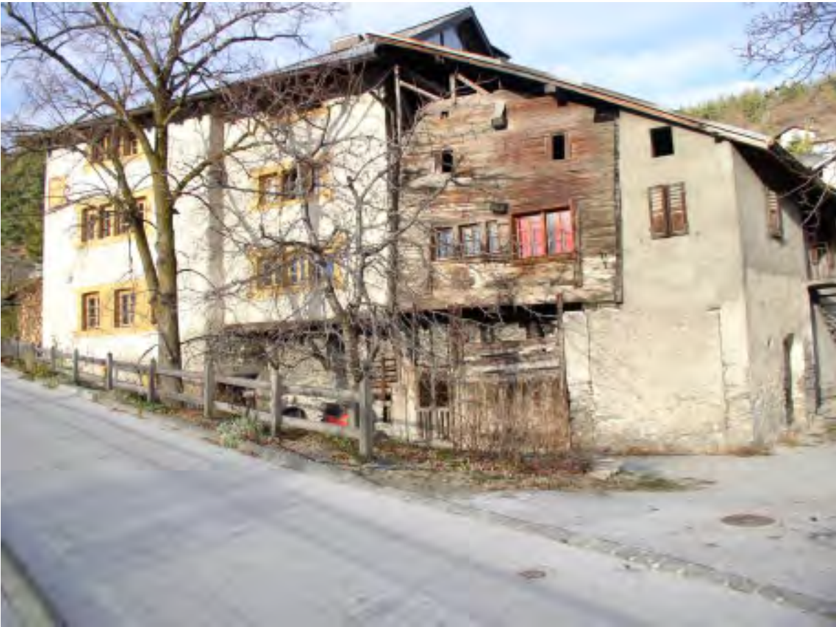
Fig. 1 Façade sud du bâtiment.
