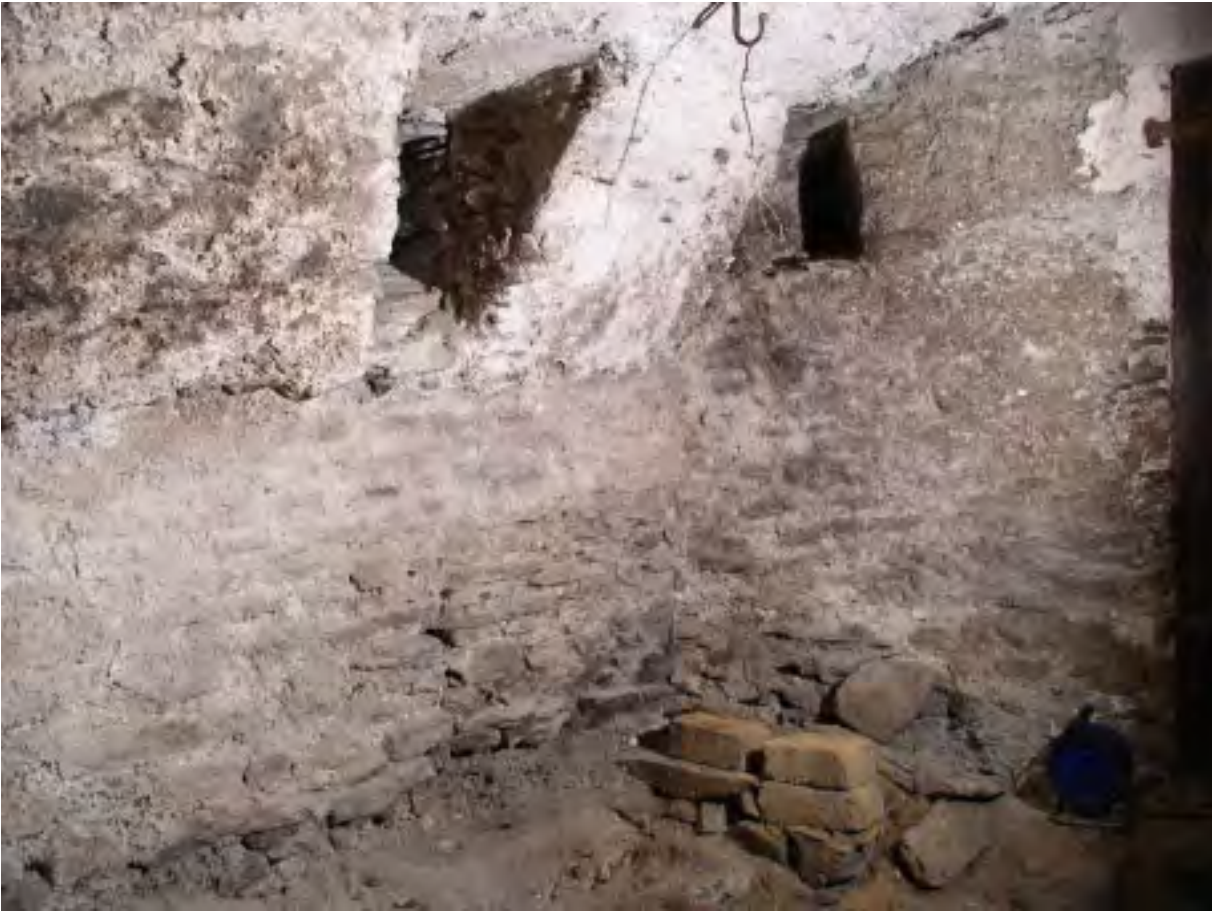
Fig. 9 Cave du soubassement (C), angle sud-est. La voûte est un élément rajouté dans un deuxième temps. Le niveau du sol a été abaissé ; il se situe aujourd'hui plus bas que la semelle des fondations.
