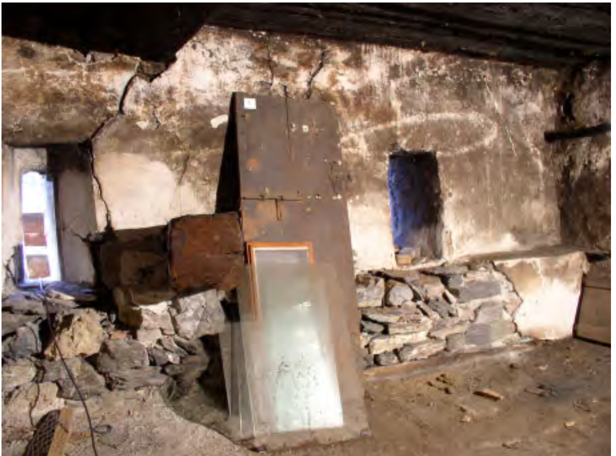
Fig. 6 Salle du soubassement (B), paroi sud. Entre les deux fenêtres et sur le ressaut de la maçonnerie, la poutre sortant en façade.
