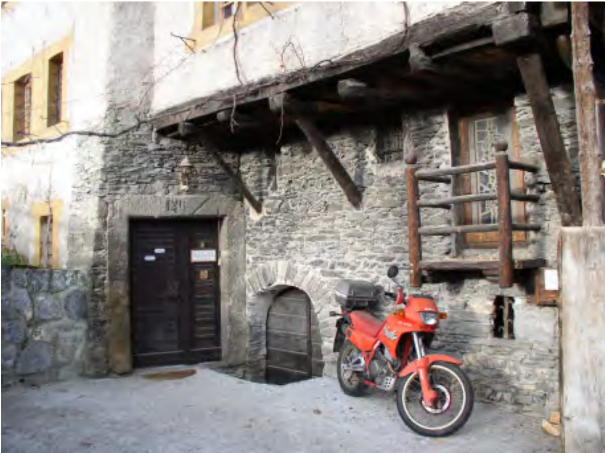
Fig. 3 Façade sud. A droite, le soubassement maçonné (A). Au fond, la porte englobée dans une maçonnerie venant buter contre le soubassement (A).
