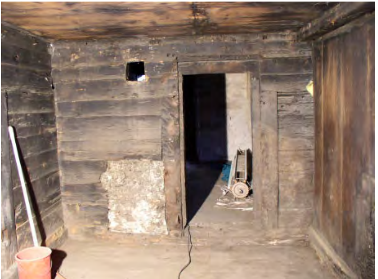
Fig. 12 Madrier (C), étage inférieur, paroi nord. Les montants verticaux de la porte indiquent la hauteur primitive de l'ouverture. A gauche de la porte, le bouchon maçonné correspond à l'ouverture de chargement d'un ancien fourneau en pierre ollaire. Dans la cuisine adjacente, l'âtre devait se situer contre cette paroi avant d'être déplacé dans l'angle nord-est de la pièce.
