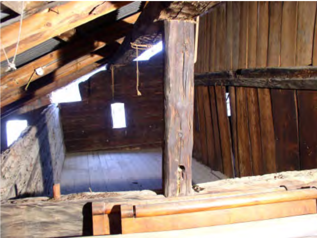
Fig. 13 Madrier (C), étage supérieur, local occidental vue vers le sud. Les rainures dans le madrier à gauche et dans la sablière haute à droite indiquent l'emplacement des planches du plafond. Les planches de la cloison verticale sont emboîtées dans la rainure des sablière haute et basse.
