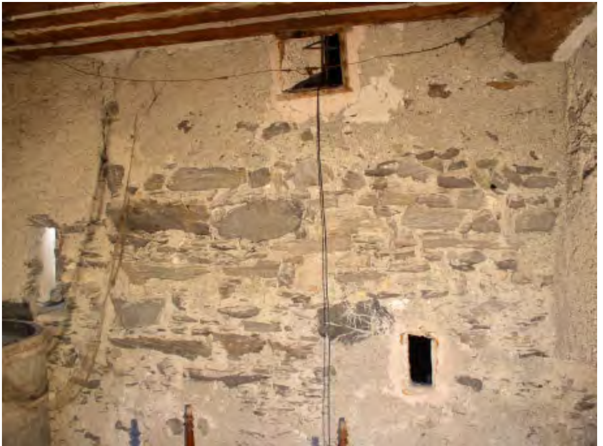
Fig. 8 Soubassement (B), façade orientale.
