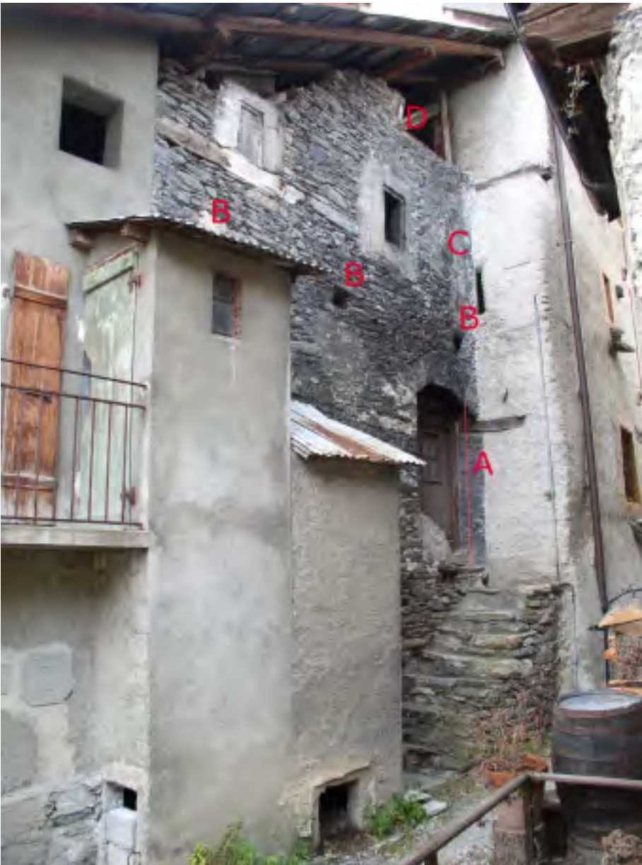
Fig. 17 Façade nord du bâtiment (C). A : Ancien emplacement du montant droit ; le piédroit a été déplacé en fonction de l'escalier actuel. B : Alignement de trois trous de boulin (échafaudage) aménagé d'origine dans la maçonnerie. C : Dalle verticale correspondant à une niche côté intérieur. D : Piédroit vraisemblablement d'une fenêtre. Les parties les plus anciennes de cette façade pourraient être contemporaines du soubassement (B). Certains éléments pourraient être des transformations (rehaussement ? rajout d'ouvertures ?).
