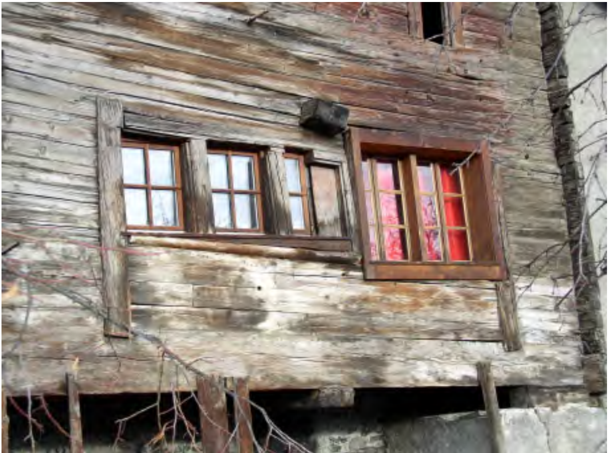
Fig. 2 Façade sud. Détail des fenêtres du madrier (C), 1 er étage.
