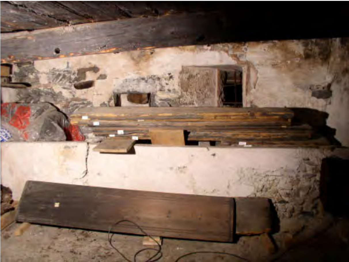
Fig. 5 Salle du soubassement (B), paroi orientale. Les cuves maçonnées sont plus récentes que les supports d'étagères présents sur toutes les parois de la pièce sauf au sud.
