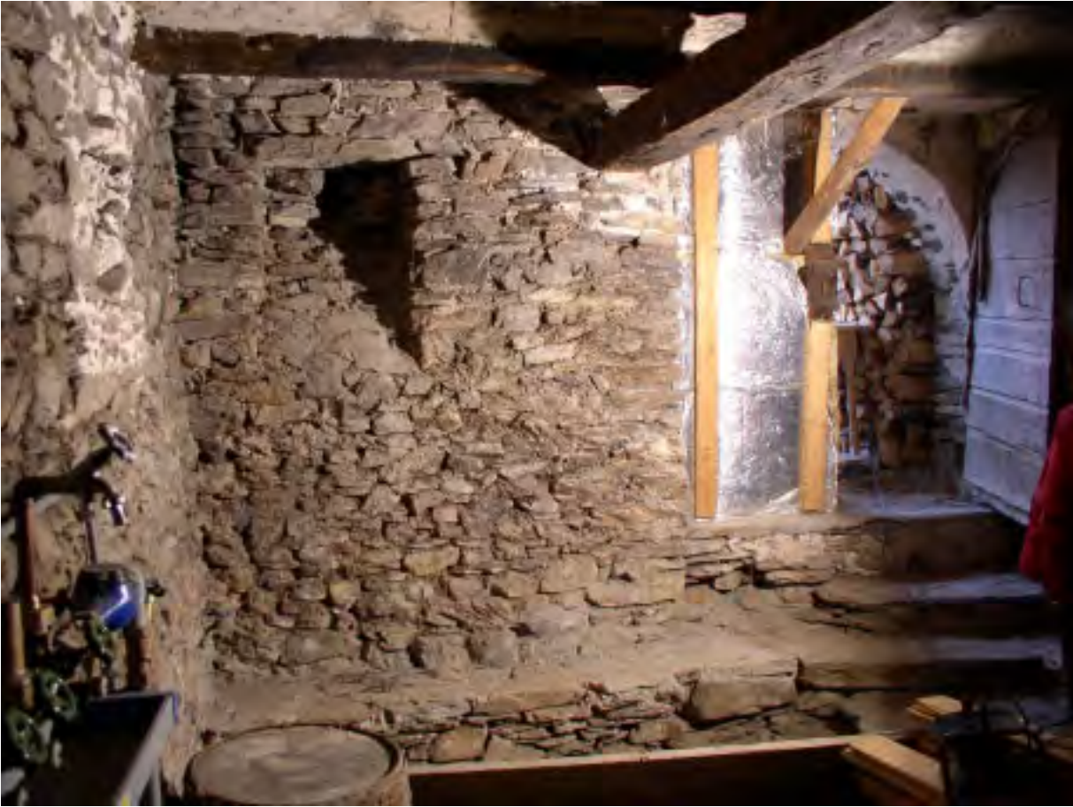
Fig. 7 Cave du soubassement (B), paroi sud.
