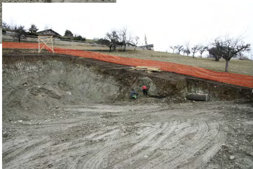
Fig. 17 — Vex, Devant-l'Église, parcelle 7082. Profils est et nord du terrassement, vus de l'est. A l'amont, le substrat morainique apparaît sous 50 cm de colluvions. A l'aval, à droite des enfants, la cuvette et son remplissage noirâtre.
