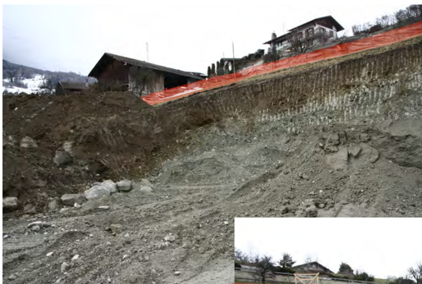
Fig. 16 — Vex, Devant-l'Église, parcelle 7082. Profils est et sud du terrassement, vus de l'est.
