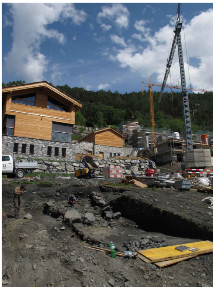
Fig. 3. Oberstalden, maison Blatter. Zone 2 en cours de fouille. Le chantier se situe en aval de plusieurs constructions récentes. Vue depuis l'ouest.
